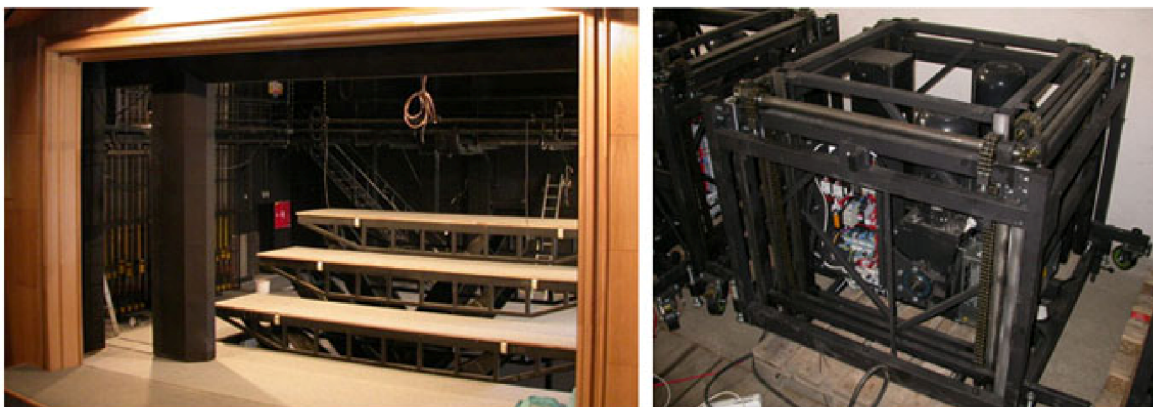
Obrázek 2.2 Dolní mechanizace - vlevo zvedací stoly, vpravo mechanismus propadla [4]
