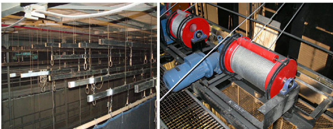
Obrázek 2.1 Horní mechanizace - vlevo prospektové tahy nad jevištěm [1], vpravo pohony v provazišti [4]
