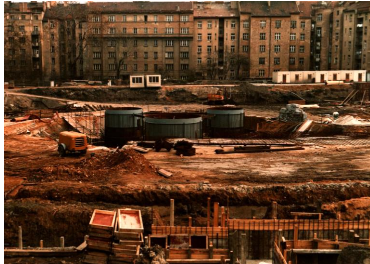
Obrázek 1 Stavba Žižkovské věže
