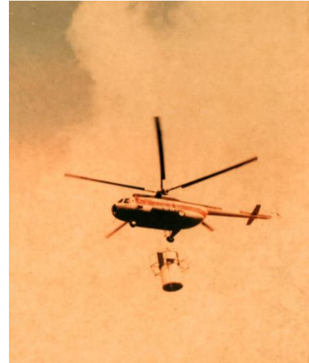
Obrázek 2 Stavba Žižkovské věže – - instalace vrchní části tubusu
