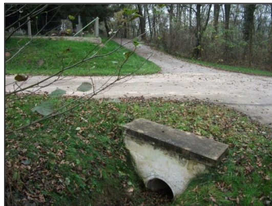
Obr. 53 Propustek pod HPC 3. Foto: KOVÁŘ Ondřej, 2013.
