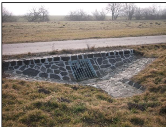
Obr. 48 Zpevněný konec průlehu. Foto: KOVÁŘ Ondřej, 2013.
