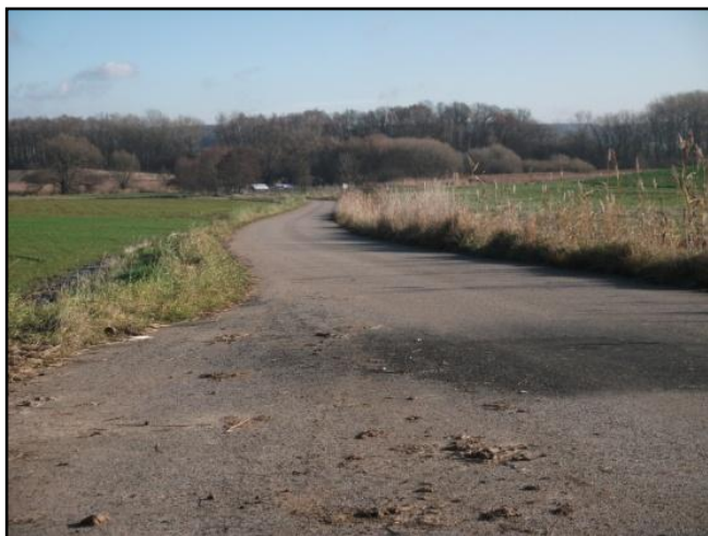
Obr. 28 Zrekonstruovaná PC 1 s výhybnou. Foto: KOVÁŘ Ondřej, 2013
