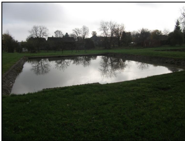
Obr. 21 Opravený rybníček, který slouží i jako protipožární nádrž. Foto: KOVÁŘ Ondřej, 2013.
