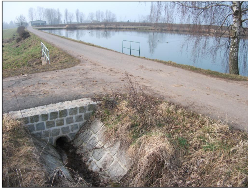
Obr. 42 HPC 3 vedoucí i po hrázi nádrže Bonda. Součástí cesty jsou vjezdy na pozemky a také propustek. Foto: KOVÁŘ Ondřej, 2013.
