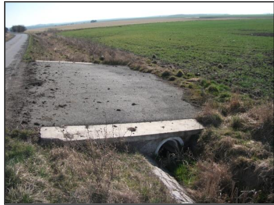
Obr. 62 Vjezd na pozemek s propustkem u HCZS 2. Foto: KOVÁŘ Ondřej, 2014.
