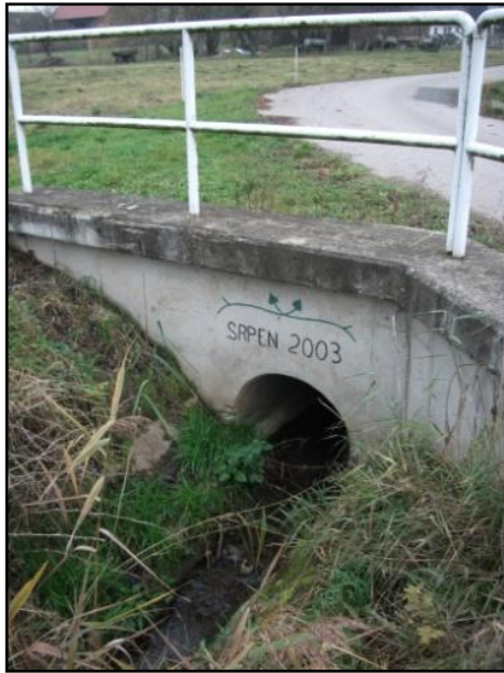
Obr. 31 Propustek pod PC 1. Foto: KOVÁŘ Ondřej, 2013.
