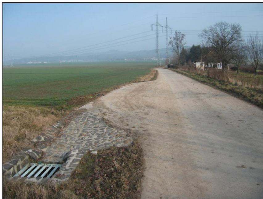
Obr. 44 HPC 5 s výhynou a odvodňovacím zařízením. Foto: KOVÁŘ Ondřej, 2013
