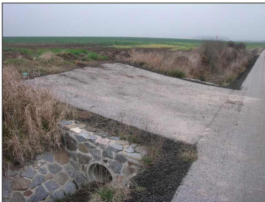
Obr. 55 HPC 4 s vjezdy na pole, propustky, výhybnami a příkopem. Foto: KOVÁŘ Ondřej, 2013.
