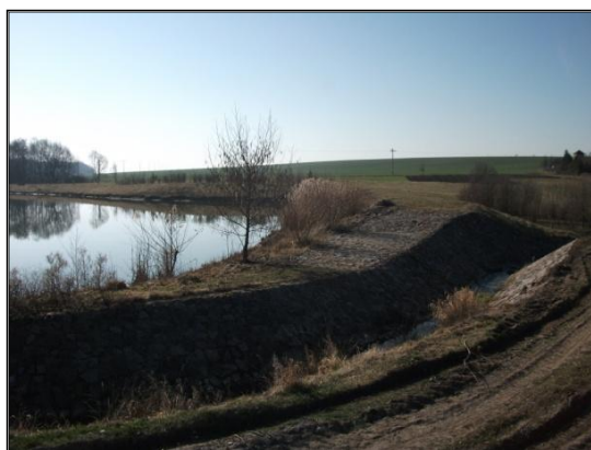
Obr. 76 Hráz vodní nádrže. Foto: KOVÁŘ Ondřej, 2014.
