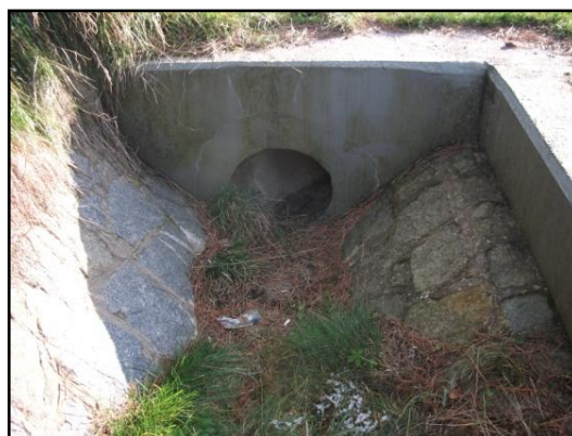
Obr. 34 Příkop s propustkem pod PC 6. Foto: KOVÁŘ Ondřej, 2013
