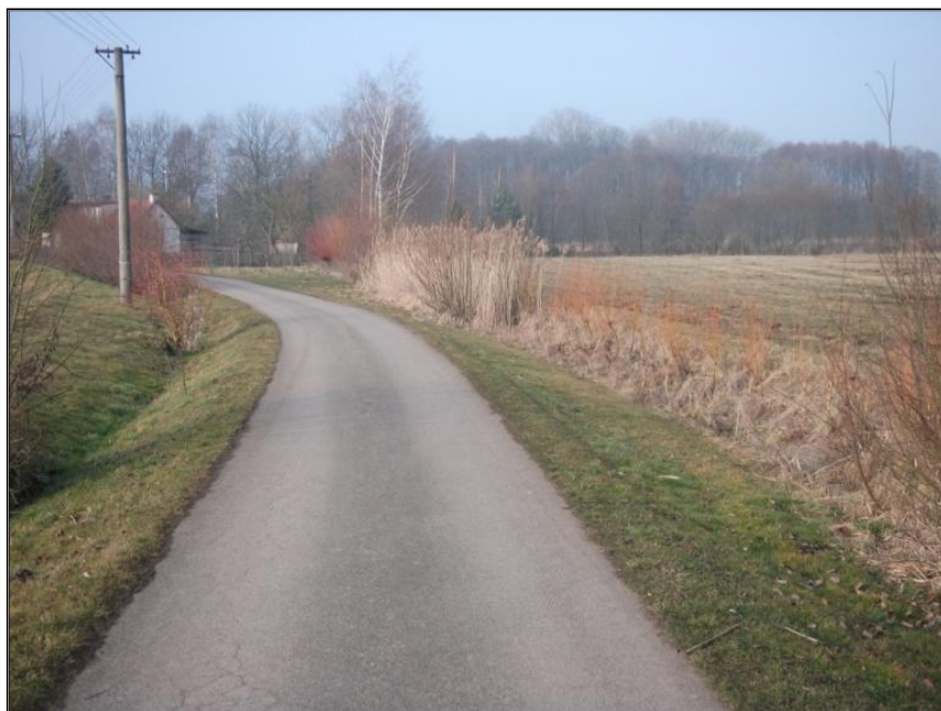
Obr. 39 Zrekonstruovaná část HPC 1a. Foto: KOVÁŘ Ondřej, 2013.
