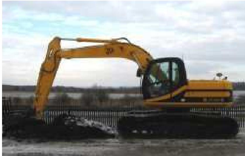
Obr. č. 2.3. Pásové hydraulické rypadlo při hloubení jámy
