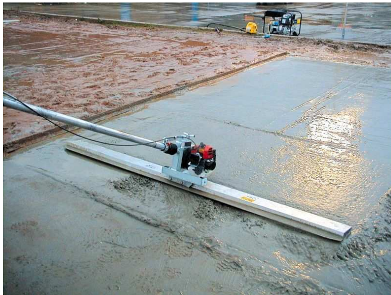
Obr. č. 2.9. Vibrační lišta pro vyrovnání čerstvého betonu
