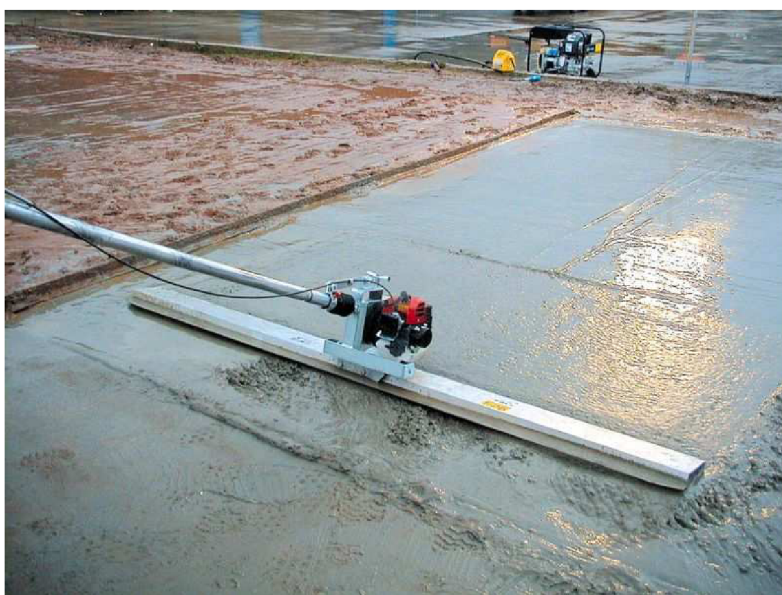
Obr. č. 2.9. Vibrační lišta pro vyrovnání čerstvého betonu
