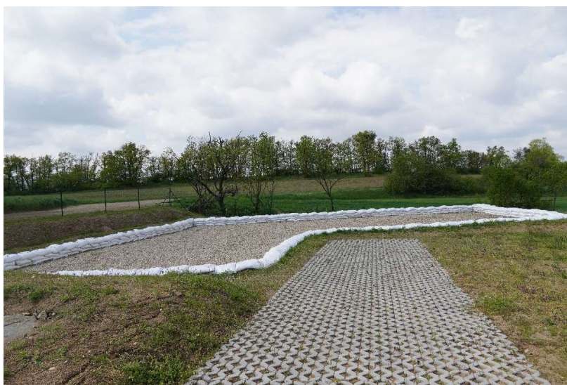
Obr. č. 28 Kalové pole v obci Hlína
