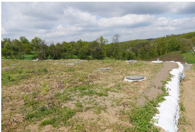
Obr. č. 16: Opevněná a zatravněná plocha anaerobního separátoru v obci Hlína
