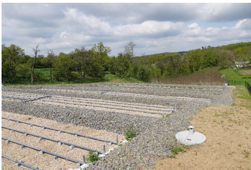
Obr. č. 21 Dvoustupňový vertikální filtr v obci Hlína – Rakouský systém
