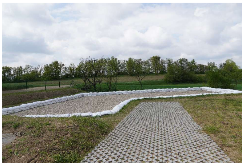
Obr. č. 28 Kalové pole v obci Hlína
