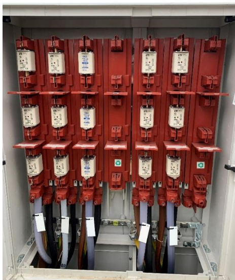
Obrázek 7.5 Rozpojovací skříň SD
