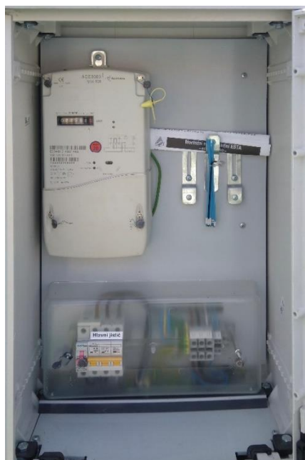
Obrázek 7.3 Elektroměrový rozváděč
