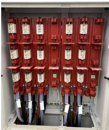
Obrázek 7.5 Rozpojovací skříň SD
