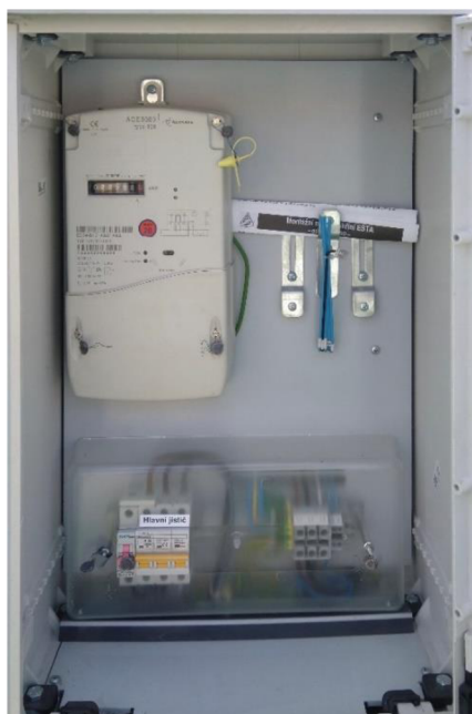
Obrázek 7.3 Elektroměrový rozváděč
