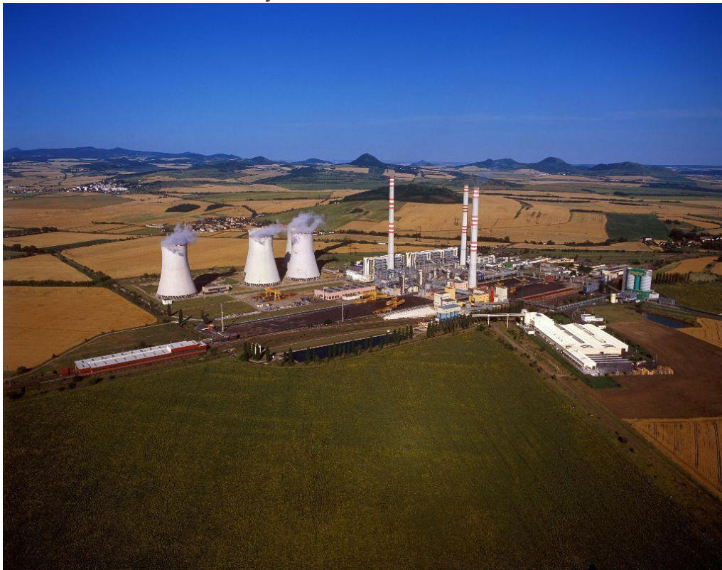
Obr. 11 Uhlerná elektrárna Počerady
