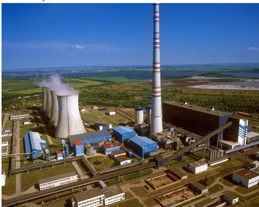
Obr. 13 Maximálně využívaná uhelná elektrárna Tušimice
