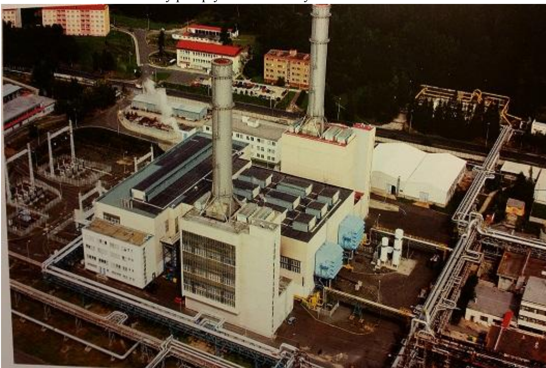
Obr. 16 Pohled na dva bloky paroplynové elektrárny ve Vřesové
