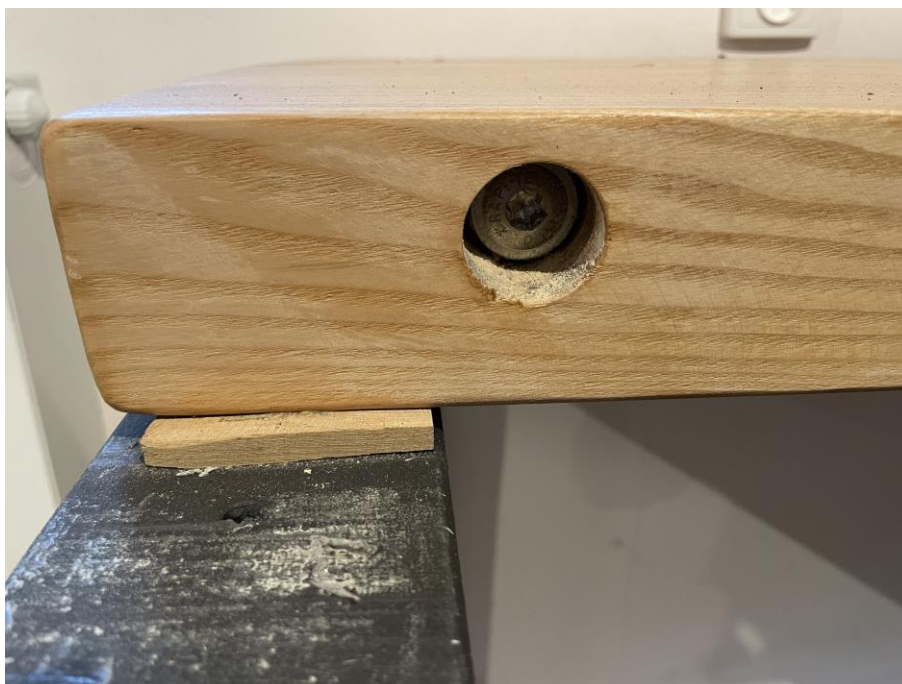
Obrázek 5: Příčné zpevnění vrutem
