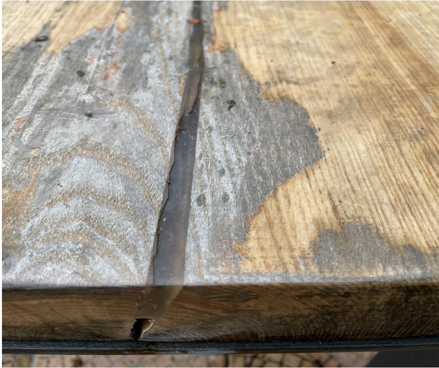
Obrázek 23: Oddělení epoxidu od dřeva, poničený nátěr
