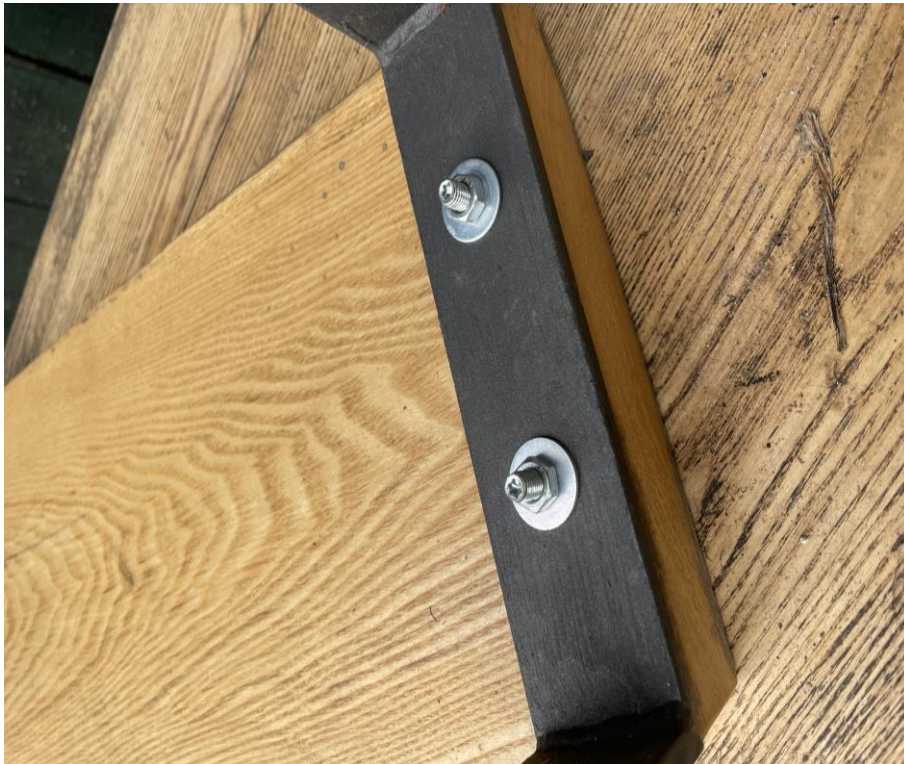
Obrázek 20: Detail kombinovaného šroubu
