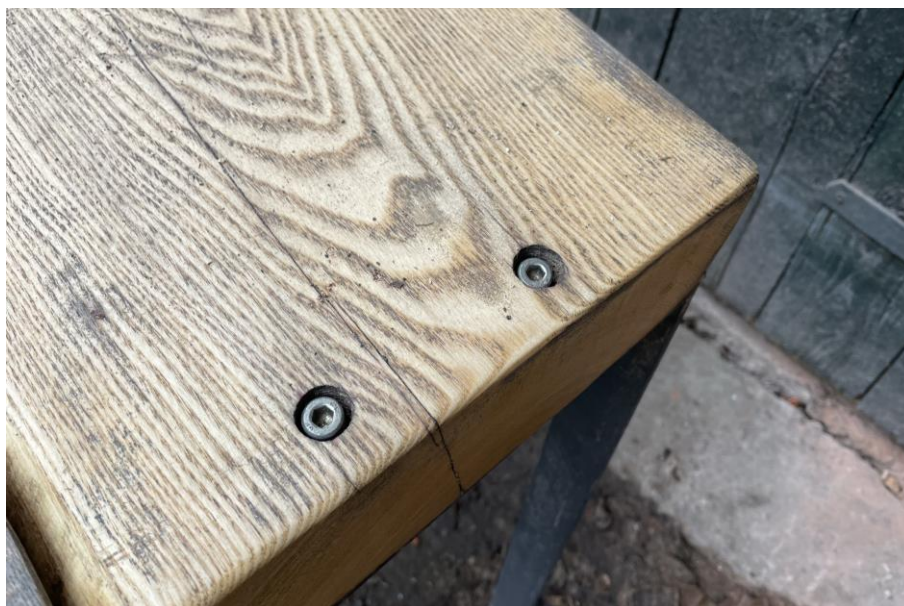
Obrázek 18: Typ č. 1 - detail spoje
