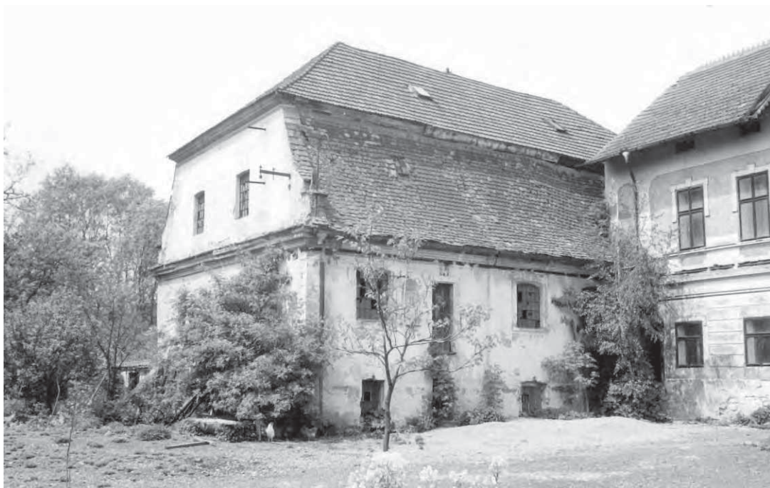
obr. 16/22 - Fotografie z roku 1984 (převzato z: Vepřek – mlýn čp. 19, stavebně historický průzkum, Jan Pešta, 2011, uloženo v osobním archivu Jana Pešty).
