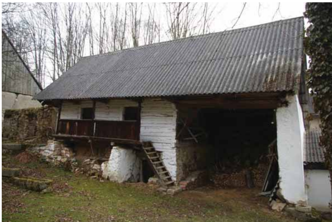
obr. 15/15 – Pavlačová sýpka s dřevníkem a sklepem (foto Matějček 2011).
