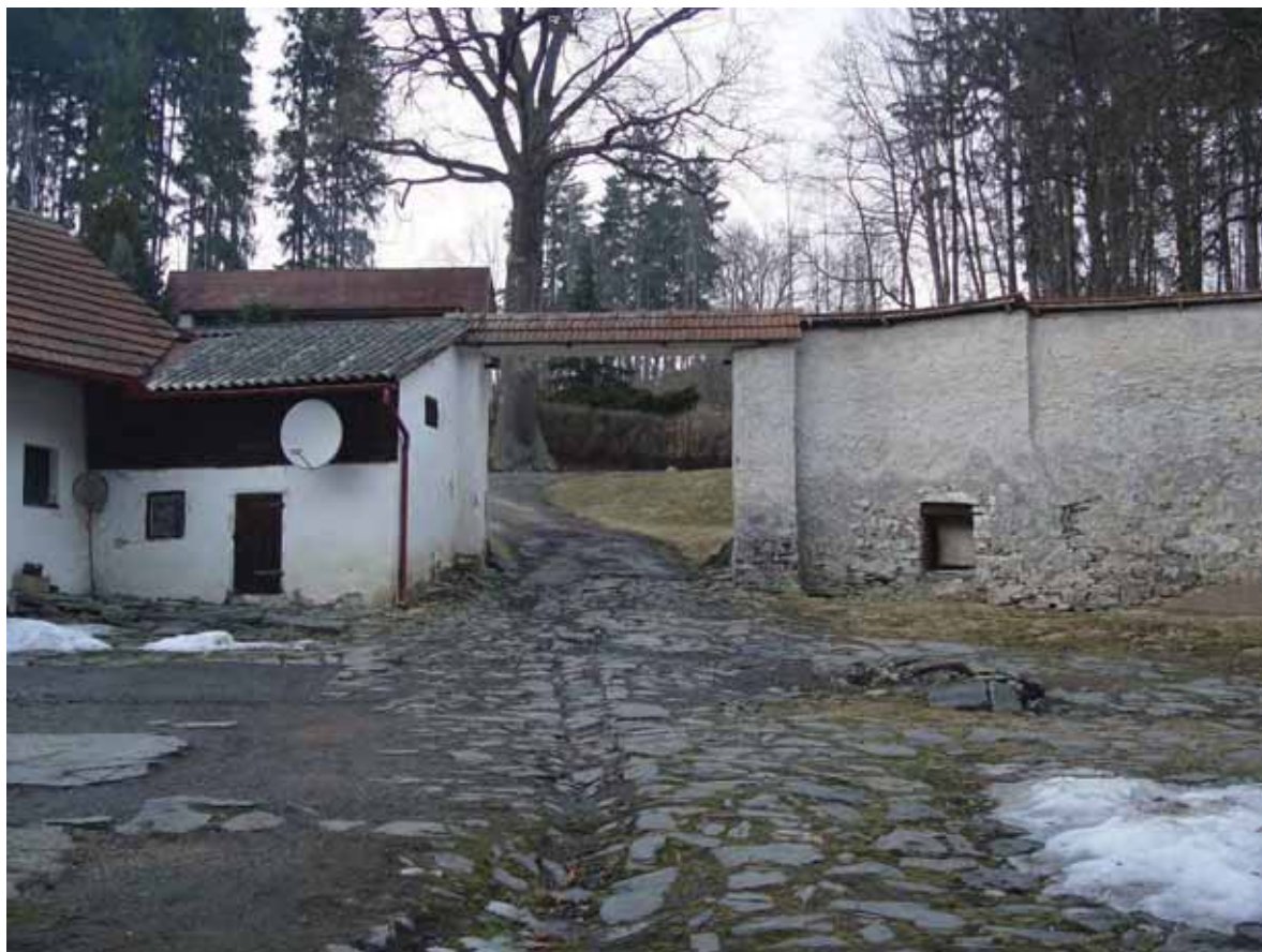
obr. 17/5 – Severní brána a vydlážděný dvůr (foto Šimek 2011).
