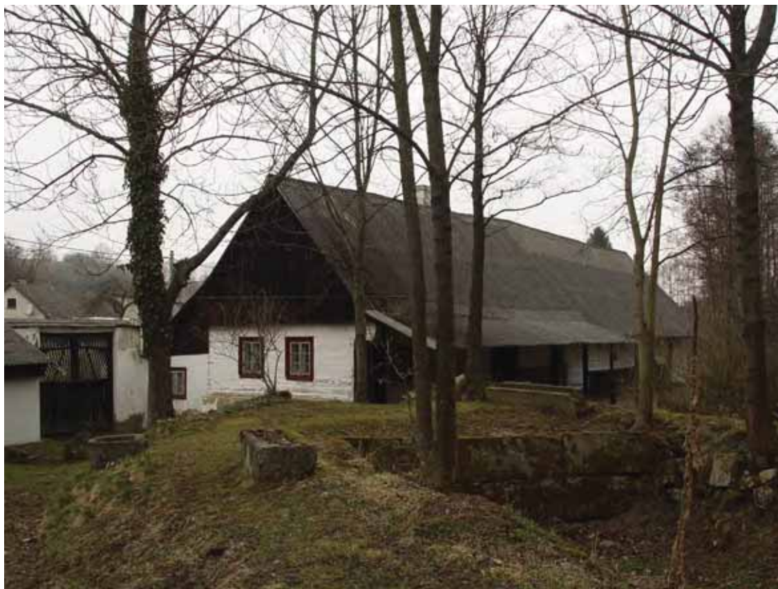
obr. 7/15 – Pohled na mlýn z jihu (foto Šimek 2011).
