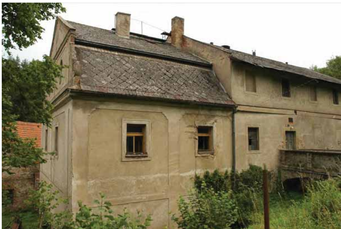
obr. 9/10 – Pohled na severozápadní průčelí (foto Pešta 2006).
