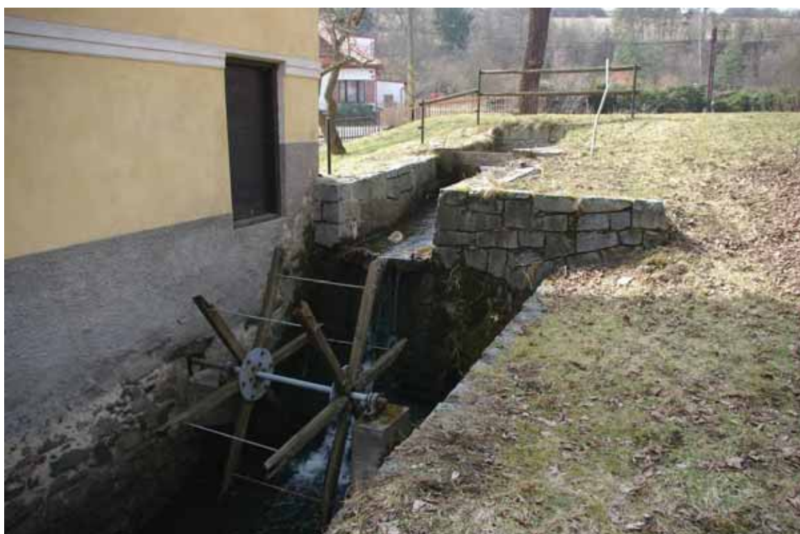
obr. 15/13 – Pohled na vodní dílo (foto Matějčíček 2011).
