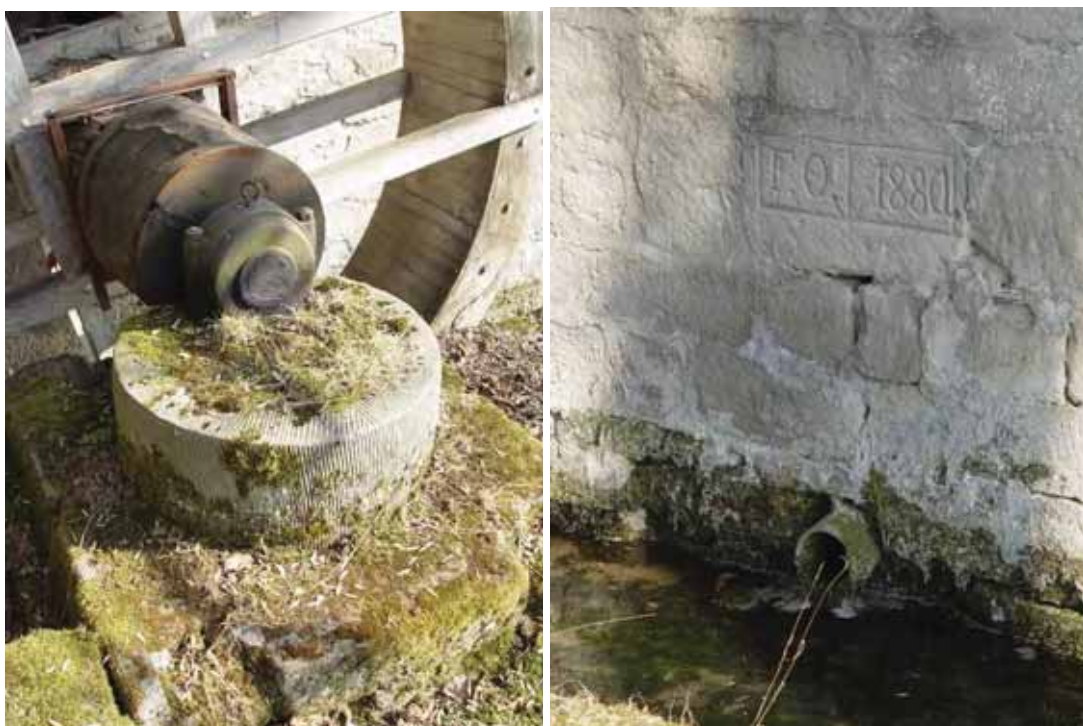
obr. 12/19 – Uložení hřídele vodního kola na kámen z krupníku (foto Šimek 2011).
