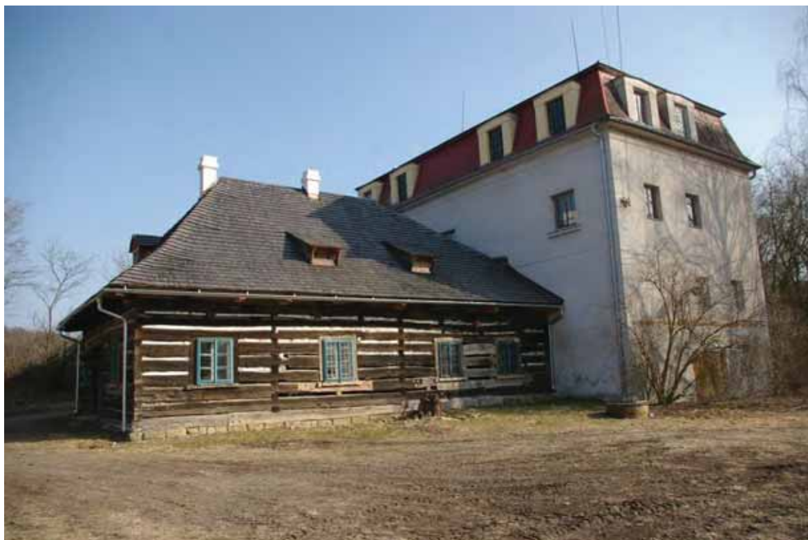
obr. 10/4 – Pohled na mlýn od severozápadu (foto Matějček 2011).
