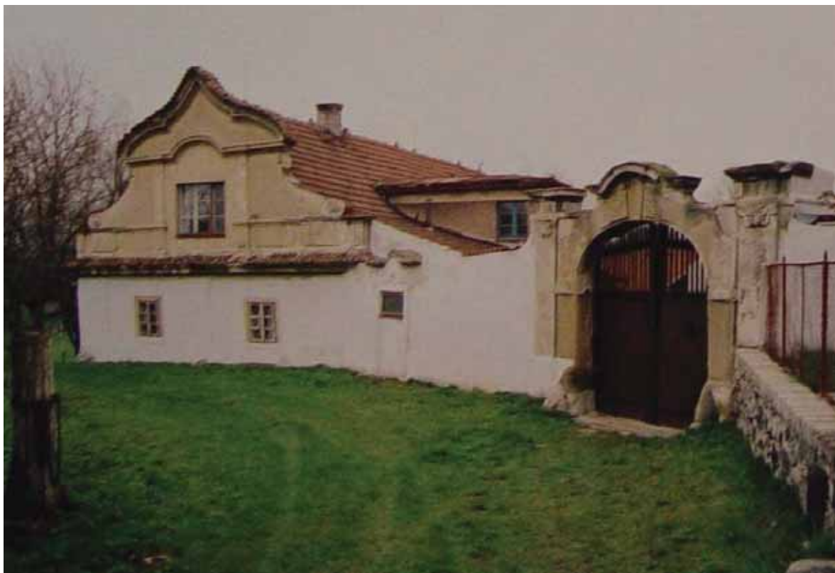
obr. 12/18 – Pohled na mlýn před rekonstrukcí (foto Pešta 2001).
