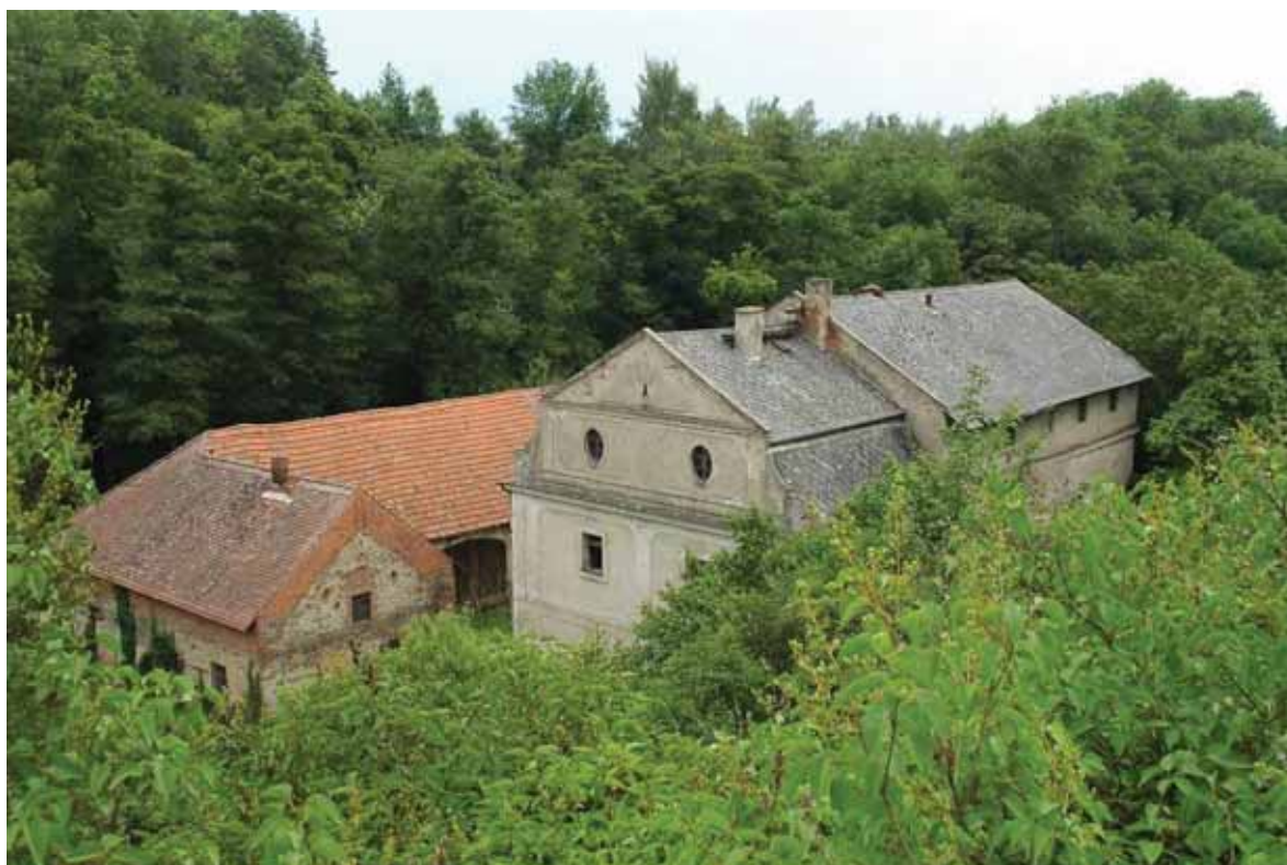
obr. 7/10 – Pohled na mlýn ze severu (foto Pešta 2006).
