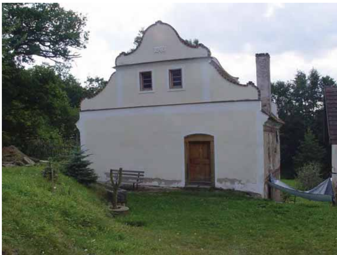
obr. 9/2 – Východní štítové průčelí (foto Šimek 2009).
