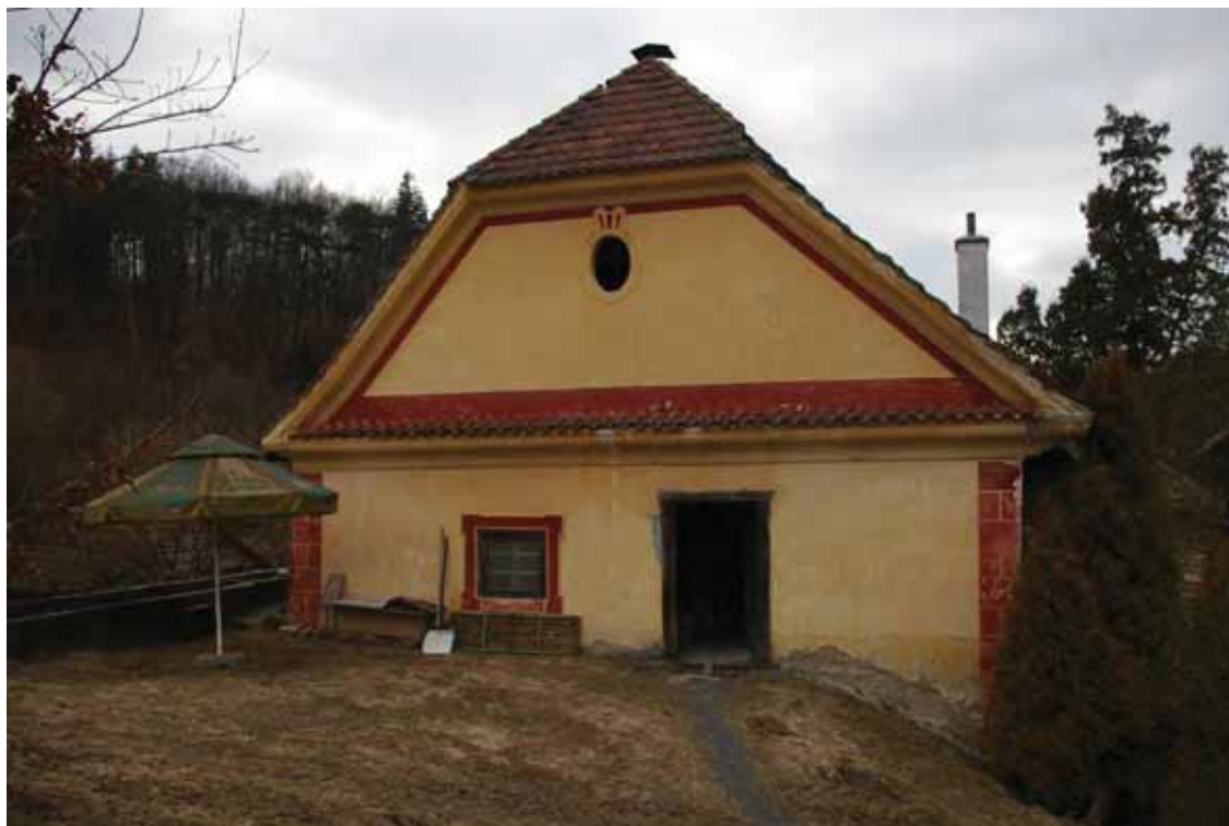
obr. 7/20 – Pohled na severovýchodní štítové průčelí (foto Matějček 2011).
