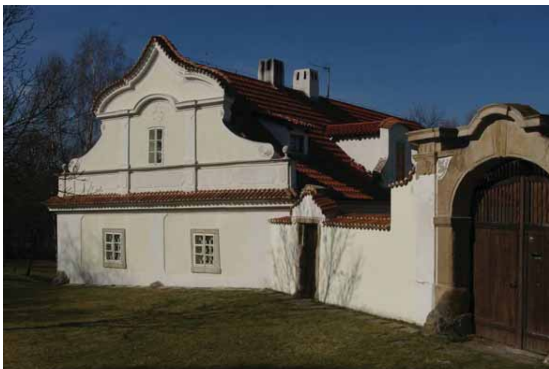
obr. 11/18 – Pohled na mlýn ze severovýchodu (foto Matějčíček 2011).
