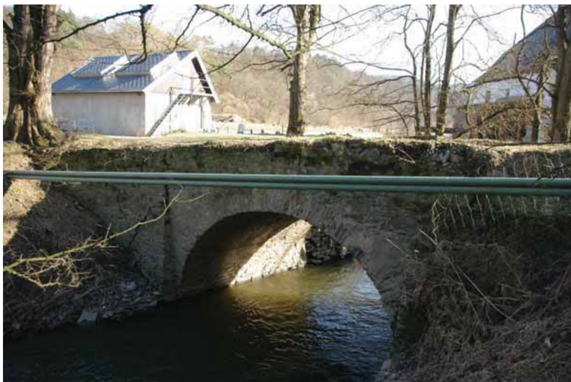
obr. 27/12 – Mostek, který vedl k pile dnes k MVE (foto Matějčíček 2011).
