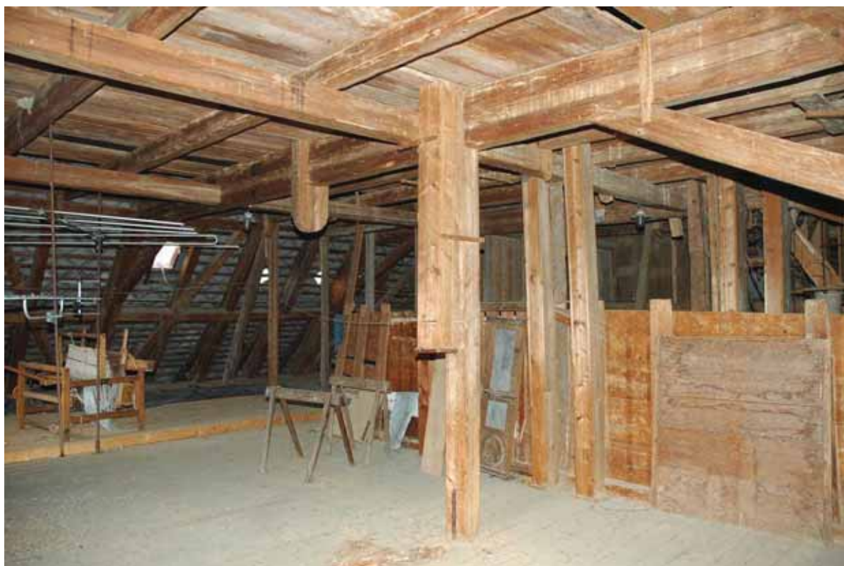
obr. 23/12 – Pohled do podkroví (foto Pešta 2006).
