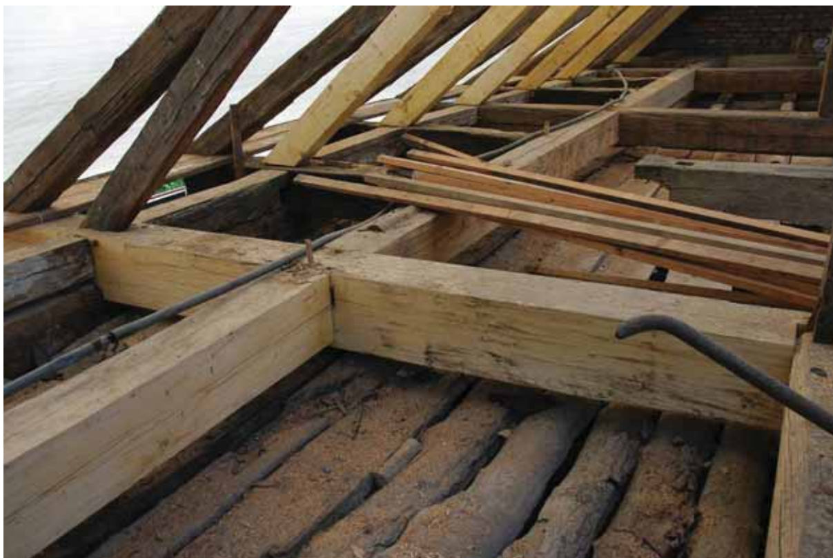
obr. 19/4 – Opravený rám krovu (foto Pešta 2008).
