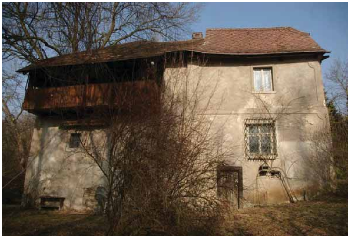
obr. 12/3 Pohled na jihovýchodní průčelí (foto Matějček 2011).
