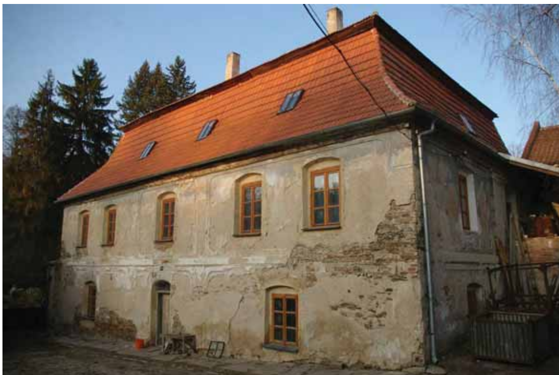
obr. 12/9 – Pohled na hlavní průčelí (foto Matějčíček 2011).
