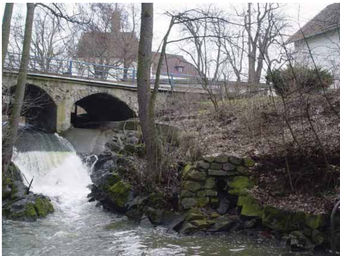
obr. 27/17 – Silniční kamenný most (foto Šimek 2006).
