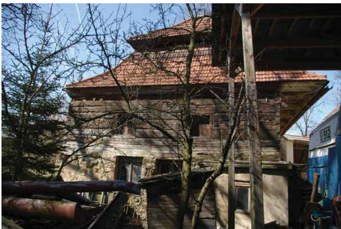
obr. 10/21 – Pohled na jihovýchodní štítové průčelí (foto Matějček 2011).
