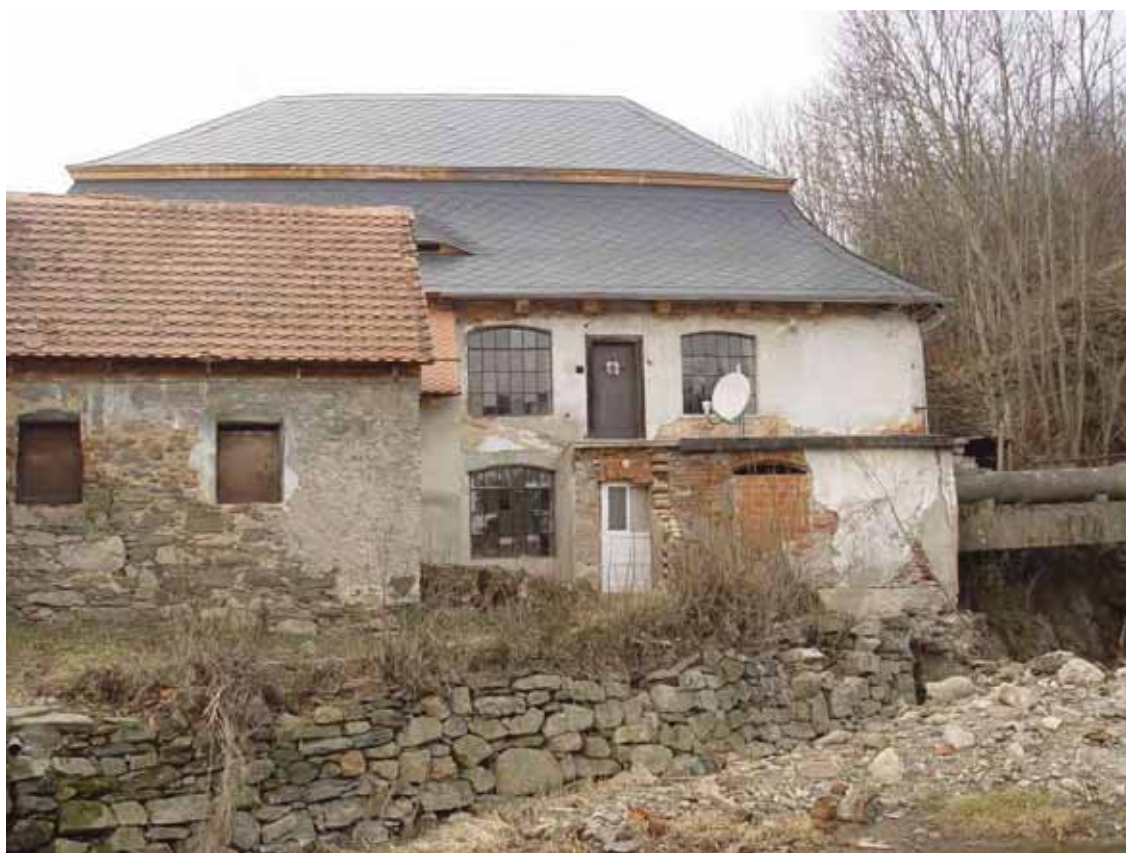
obr. 11/1 – Východní průčelí, v levé části turbínový domek (foto Šimek 2011).
