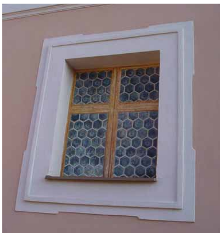
obr. 16/16 – Iluzivní okno v jihozápadním průčelí (foto Šimek 2011).
