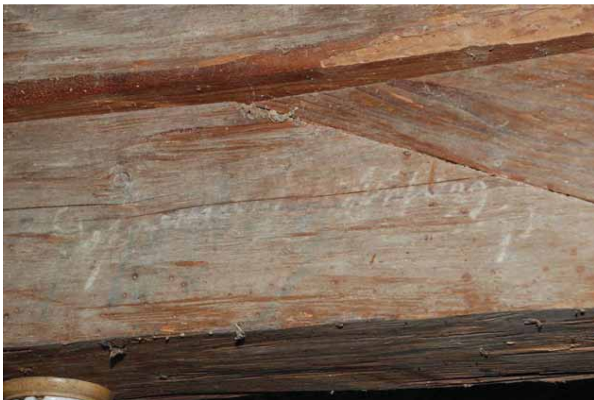
obr. 21/17 – Nápis v kurentu na trámu barokního krovu (foto Pešta 2008).
