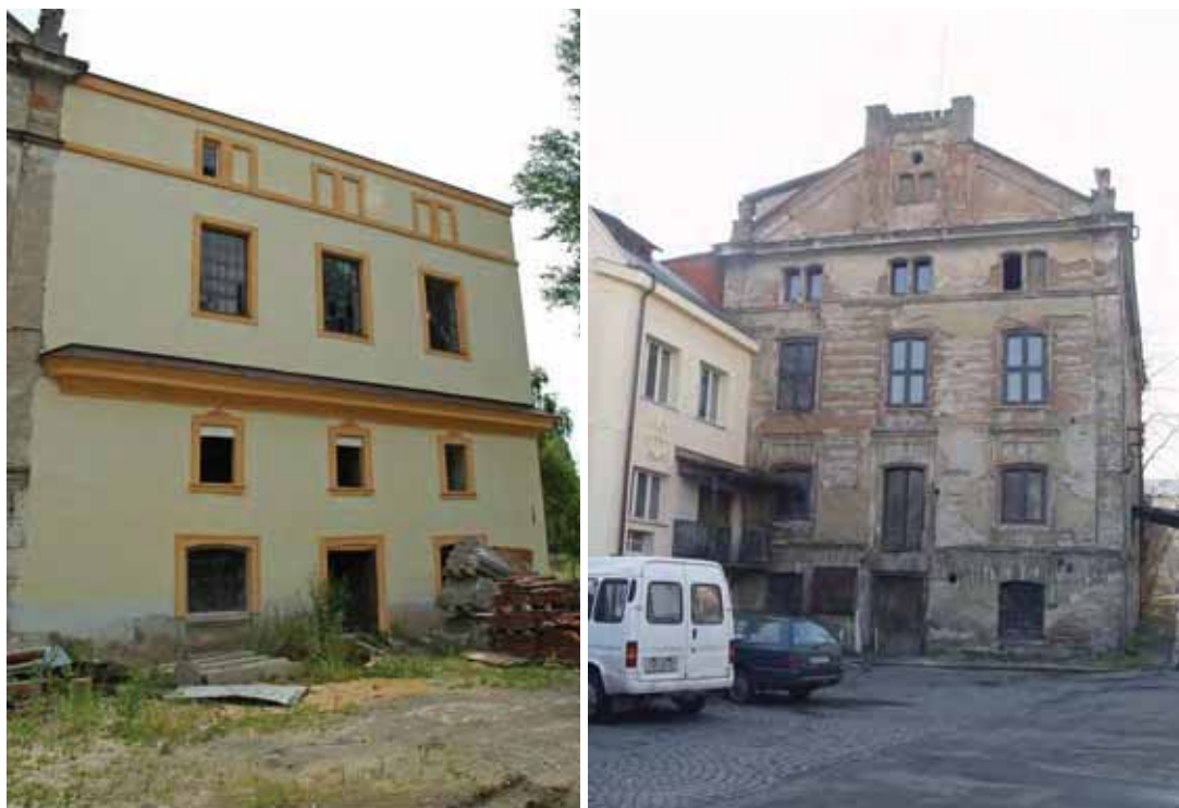
obr. 10/14 – Pohled na západní průčelí barokní části mlýna (foto Pešta 2006).
