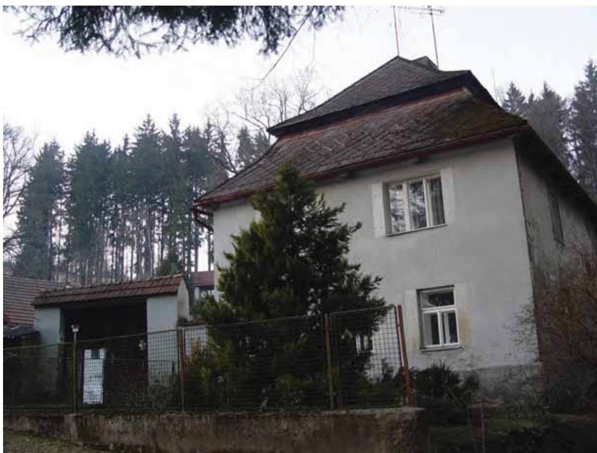
obr. 10/5 – Pohled na jihovýchodní štítové průčelí (foto Šimek 2011).
