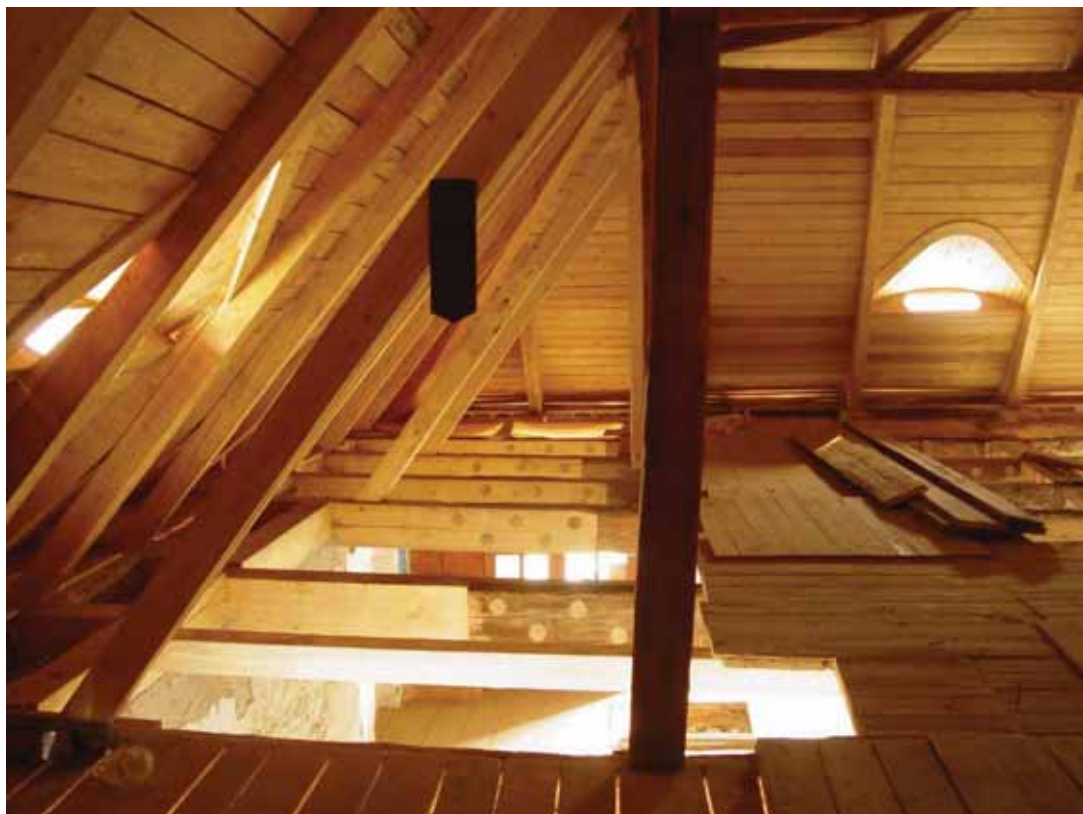
obr. 18/1 – Detail opravy vazných trámů (foto Šimek 2011).
