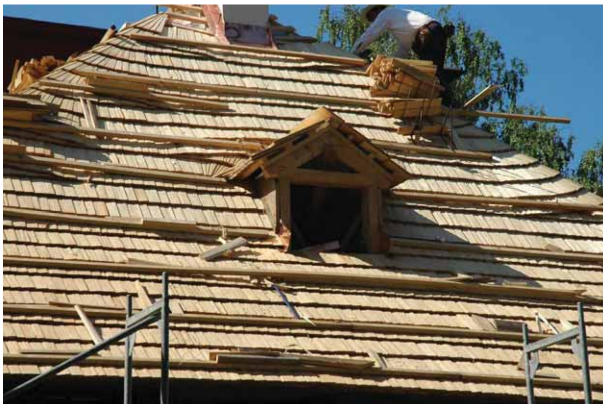
obr. 20/4 – Pokládka šindele (foto Pešta 2008).
