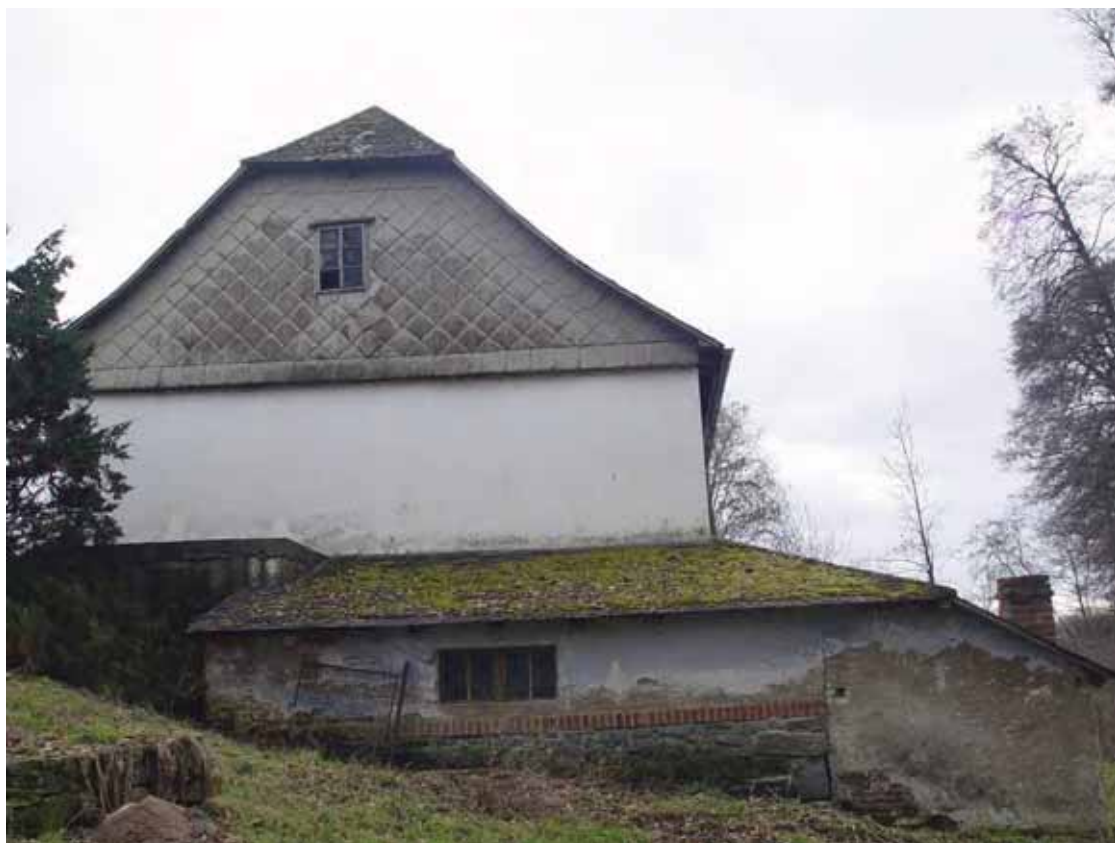
obr. 14/17 – Pohled na severozápadní průčelí (foto Šimek 2008).
