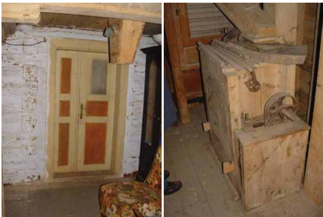
obr. 16/19 – Vstup do šalandy (foto Šimek 2011).
