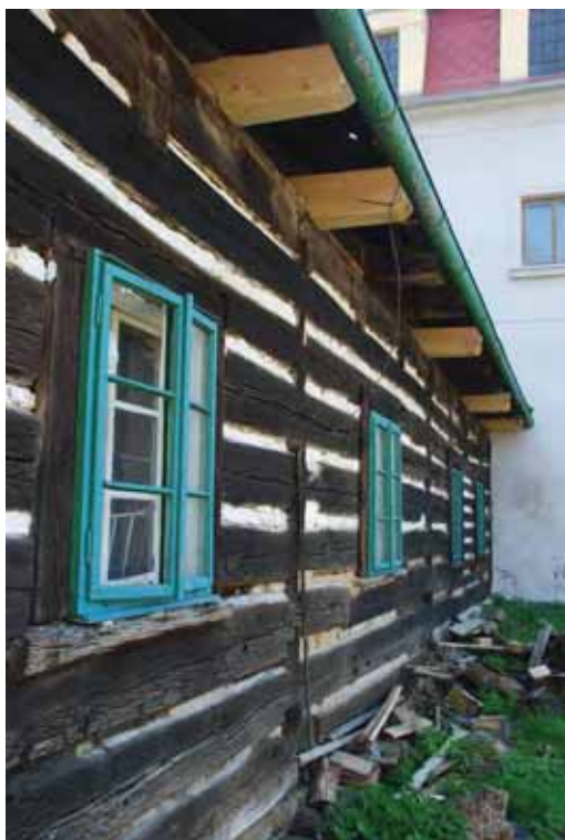
obr. 14/4 - Pohled na západní průčelí po opravě vazných trámů (foto Pešta 2008).
