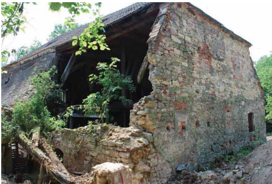
obr. 22/22 – Pohled na mlýnici ze severu (foto Pešta 2010).
