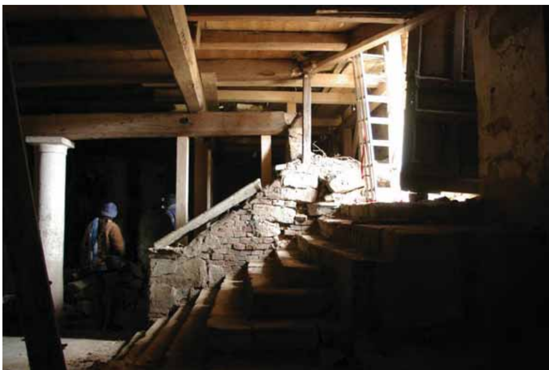
obr. 30/22 – Schodiště do přízemí mlýnice (foto Matějček 2011).
