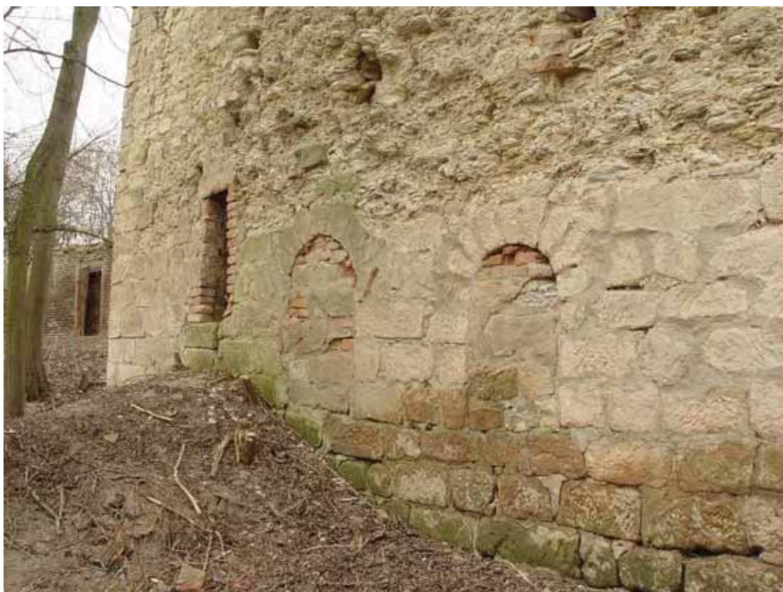
obr. 37/22 – Tři zadržené prostupy vodních kol tzv. dolní mlýnice (foto Šimek 2011).
