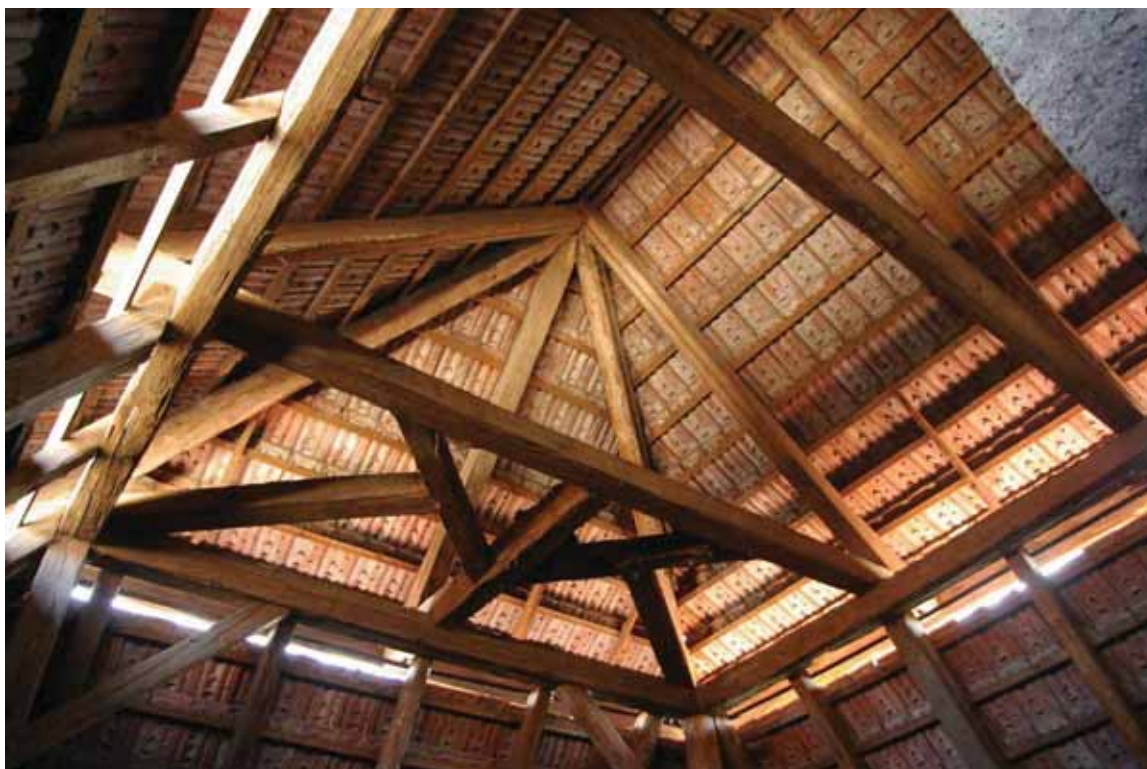
obr. 15/21 – Pohled do barokního krovu (foto Matějček 2011).
