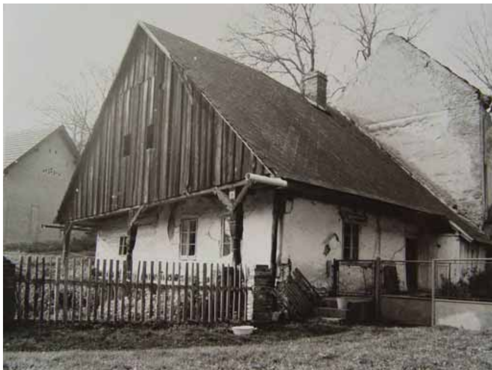
obr. 5/11 – Pohled na mlýn od jihovýchodu (fotografie převzata z: Inventarizační průzkum lidové architektury).
