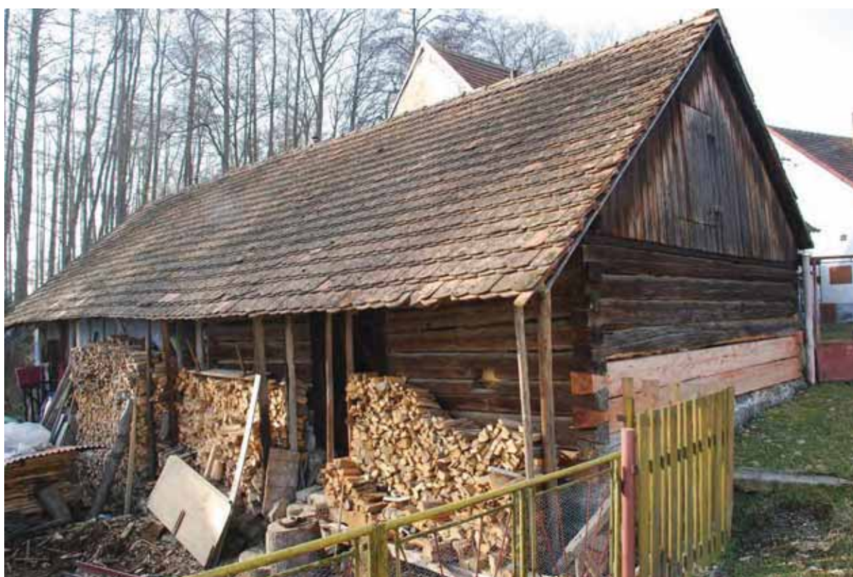
obr. 22/17 – Hospodářská budova s mlátkem (foto Pešta 2008).
