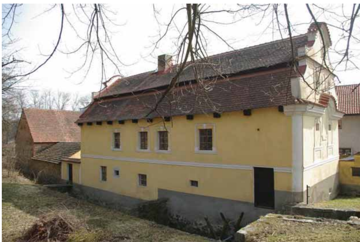
obr. 10/13 – Pohled na severozápadní průčelí (foto Matějček 2011).
