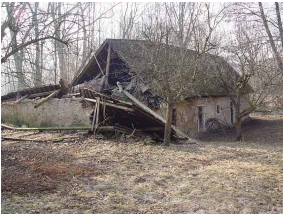
obr. 15/3 – Z části zbořená hospodářská budova (foto Šimek 2011).
