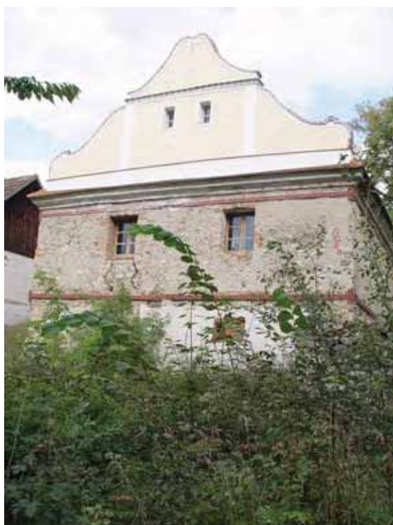
obr. 11/2 – Západní štítové průčelí (foto Šimek 2009).
