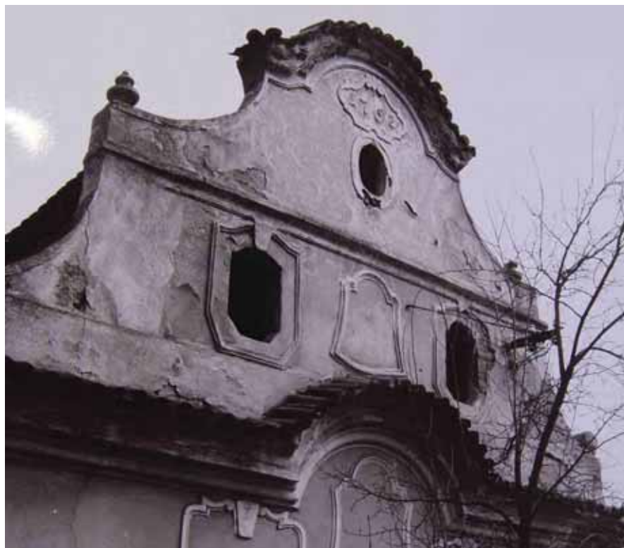
obr. 5/13 – Pohled na jihozápadní průčelí (převzato z: Inventarizační průzkum lidové architektury).
