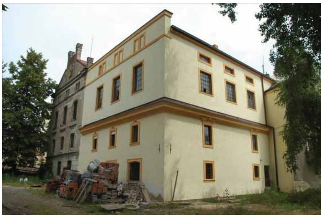
obr. 9/14 – Pohled na barokní část mlýna (foto Pešta 2006).
