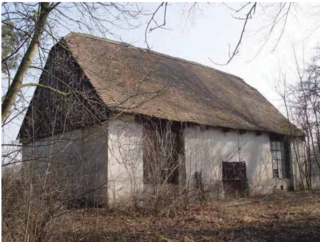
obr. 16/3 – Pilířová stodola ve východní části areálu (foto Šimek 2011).
