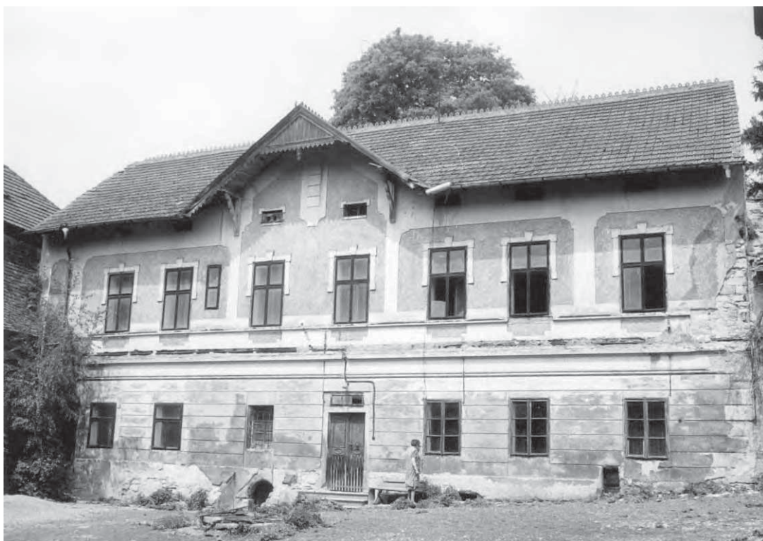
obr. 17/22 - Fotografie z roku 1984 (převzato z: Vepřek – mlýn čp. 19, stavebně historický průzkum, Jan Pešta, 2011, uloženo v osobním archivu Jana Pešty).
