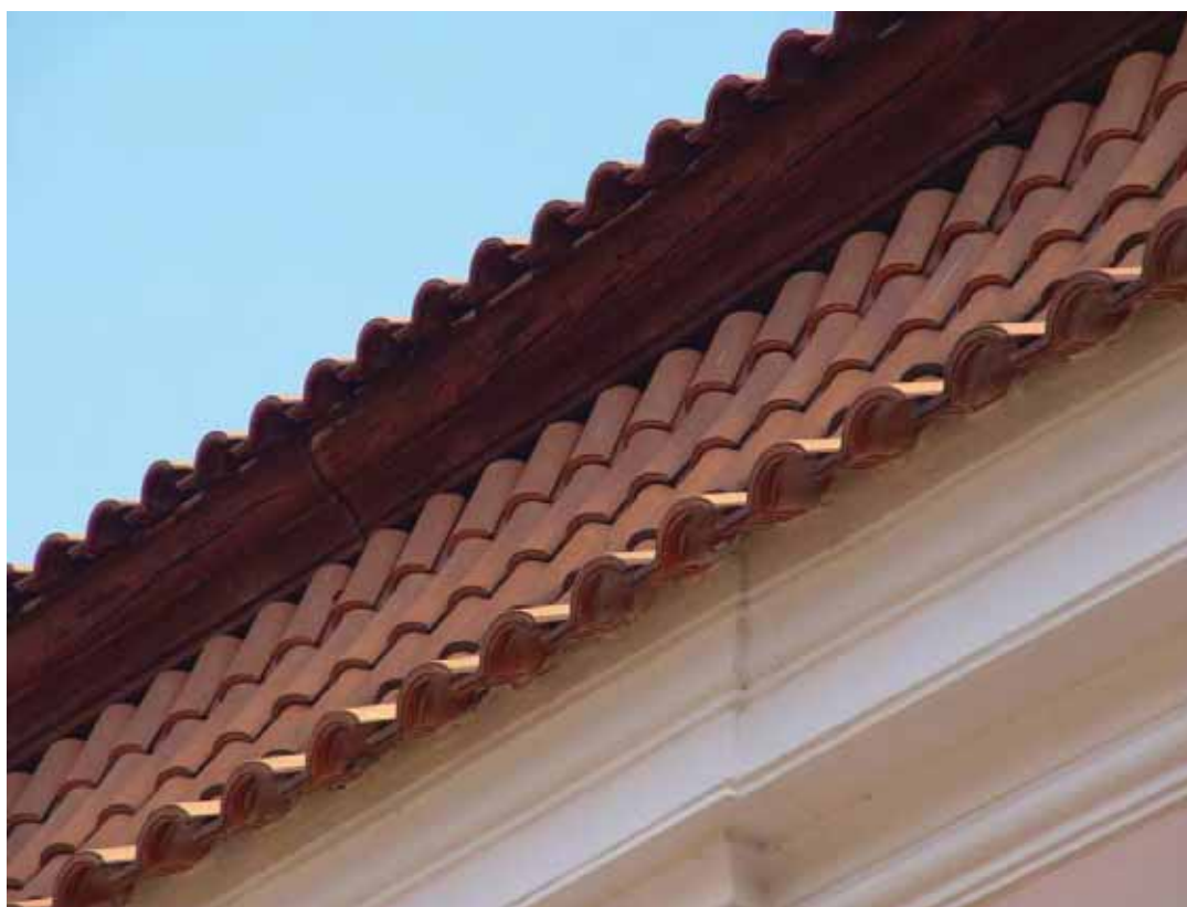
obr. 17/16 – Dřevěná mansardová římsa, jihozápadní průčelí (foto Šimek 2011).
