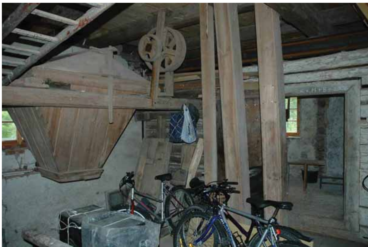
obr. 17/2 – Zanáška a dveřní otvor do šalandy (foto Kuča 2006).
