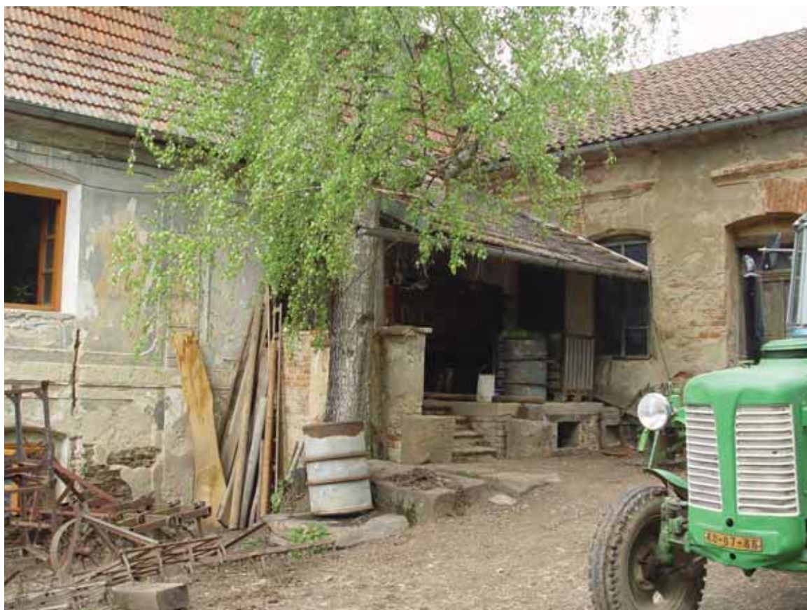
obr. 15/9 – Vstup na zanášku v jižním štítovém průčelí (foto Šimek 2011).
