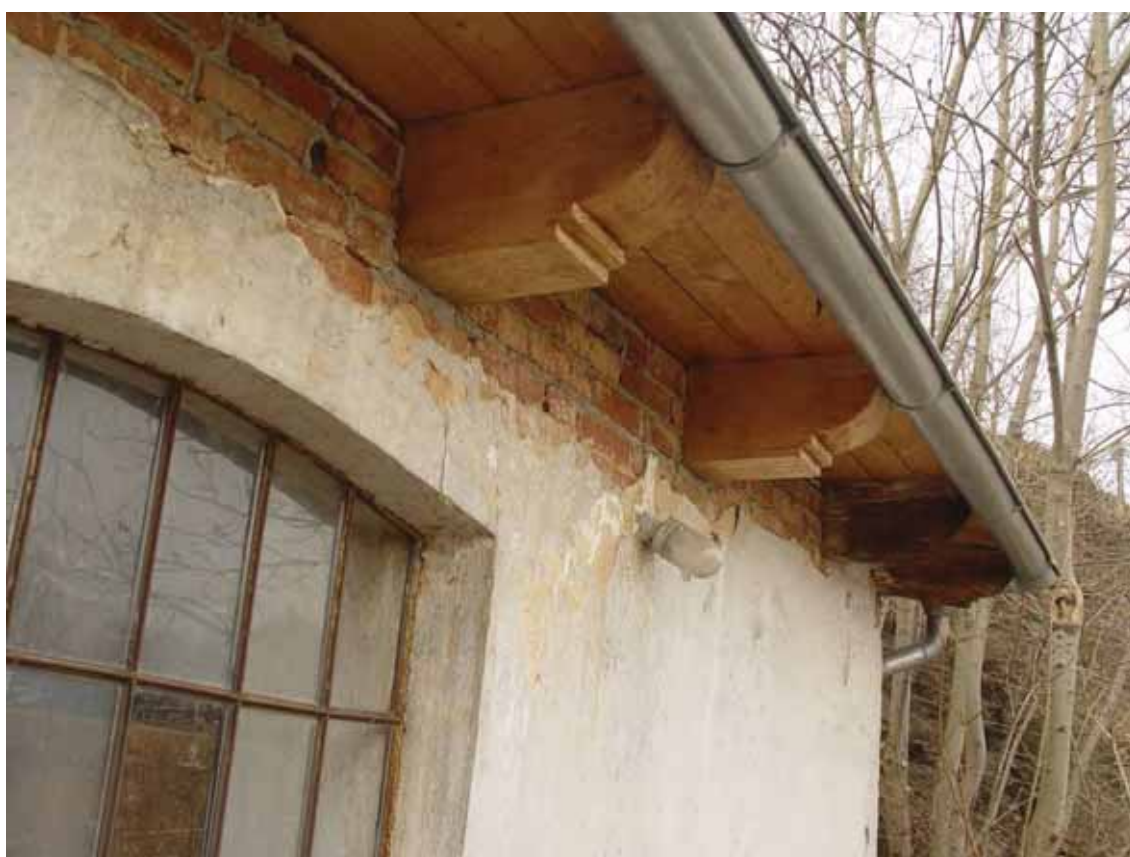
obr. 12/1 – Detail zhlaví vazných trámů na východním průčelí (foto Šimek 2011).
