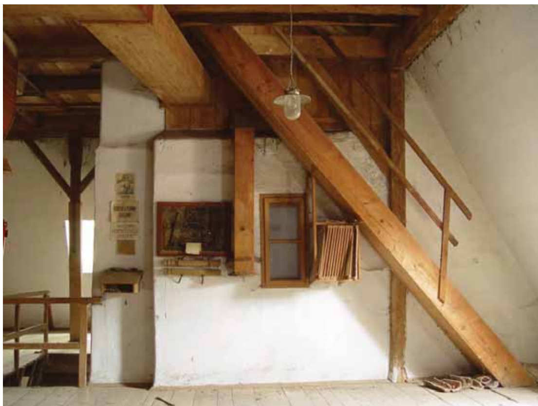
obr. 20/9 – Podstřeší se šalandou a schody do podkroví (foto Šimek 2011).
