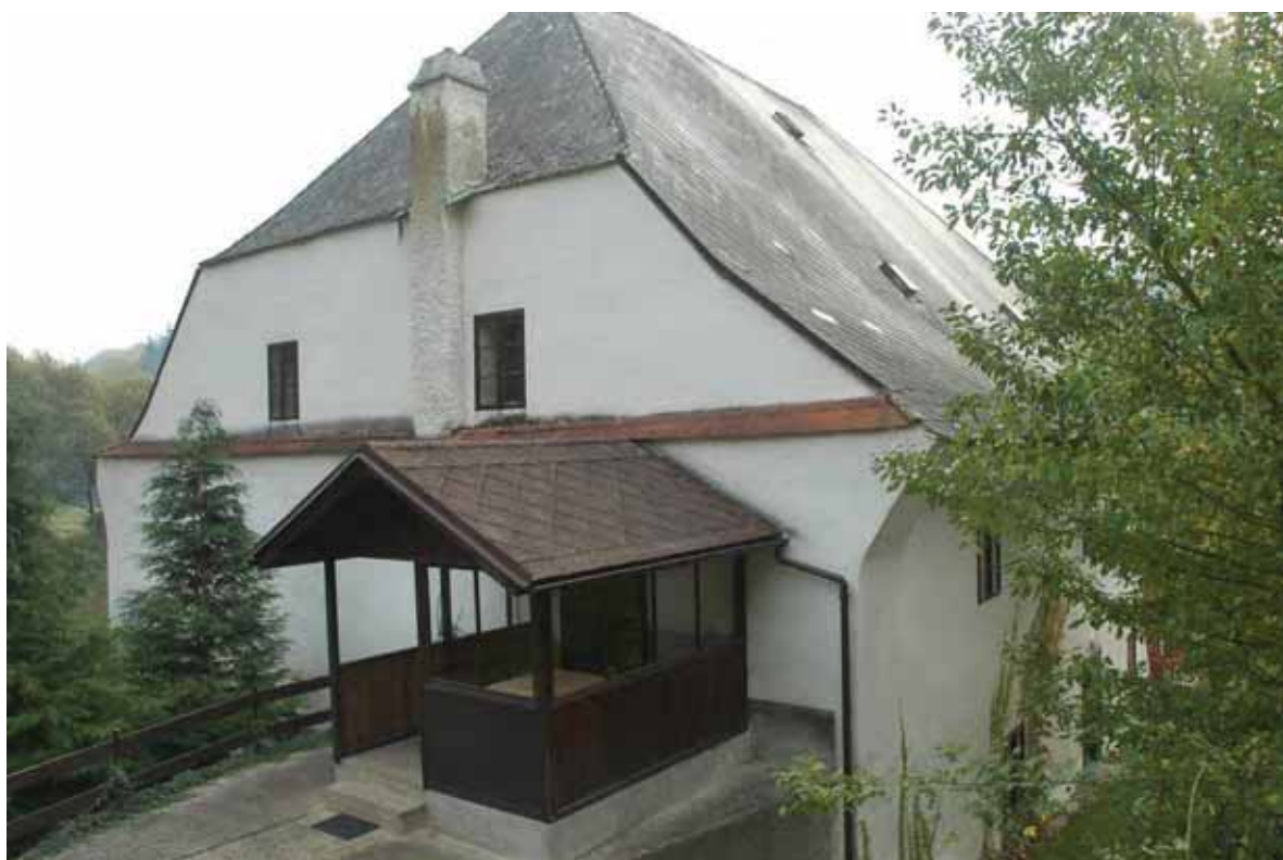
obr. 16/12 – Pohled na štítové průčelí (foto Pešta 2006).
