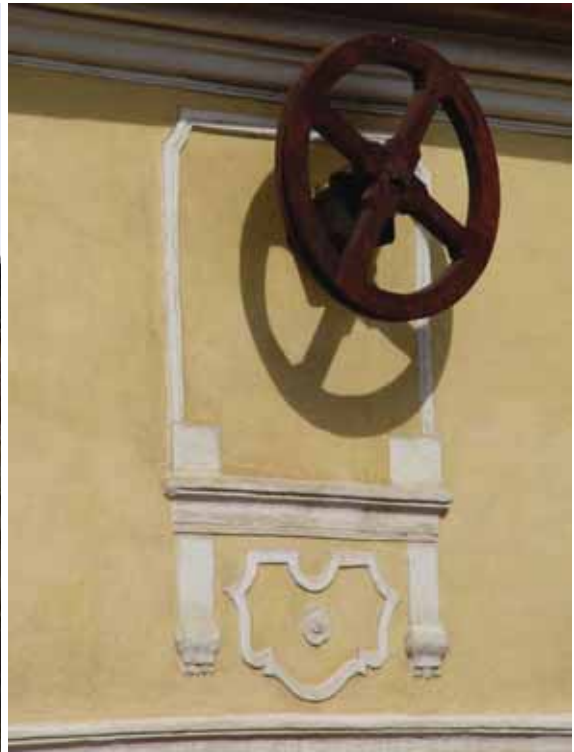
obr. 12/13 – Detail z jihovýchodního průčelí (foto Šimek 2011).
