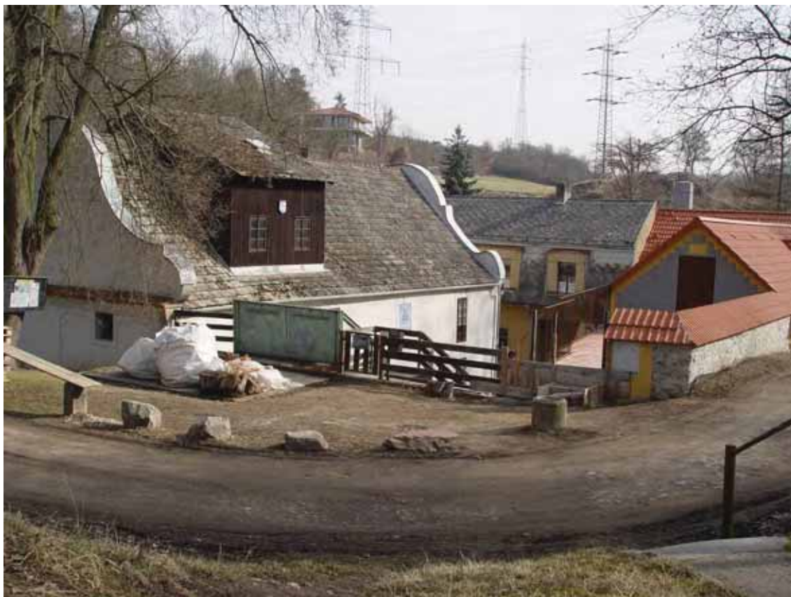
obr. 11/7 Pohled na areál mlýna od jihozápadu (foto Šimek 2011).
