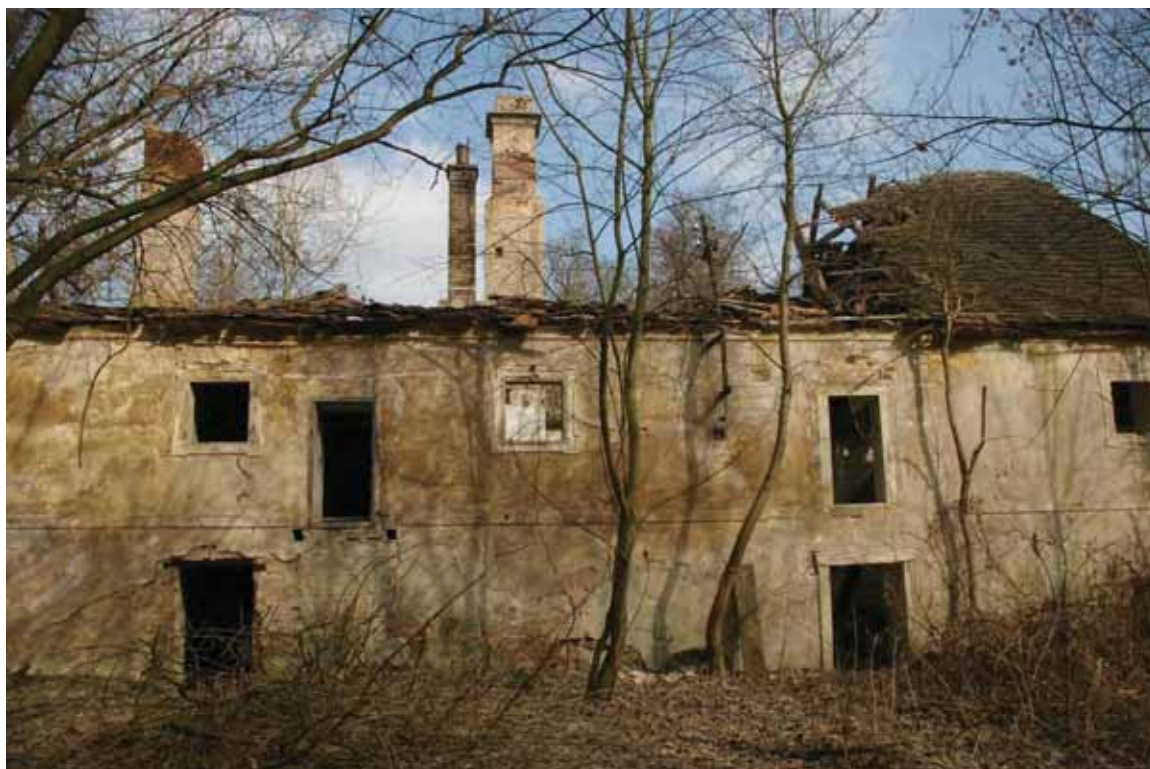
obr. 14/6 – Severovýchodní štítové průčelí (foto Matějček 2011).
