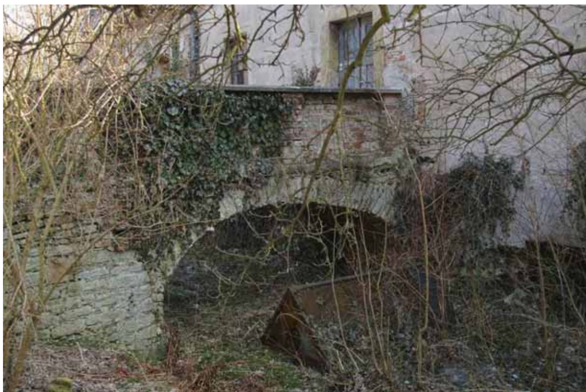
obr. 10/10 – Můstek vedoucí do prvního patra (foto Matějček 2011).
