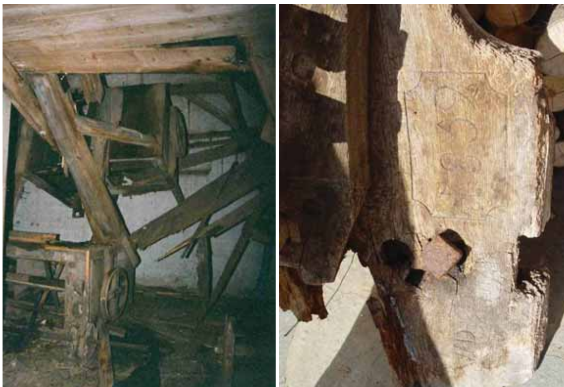
obr. 14/11 – Stav zařízení před rekonstrukcí objektu (foto Berková 2006).
