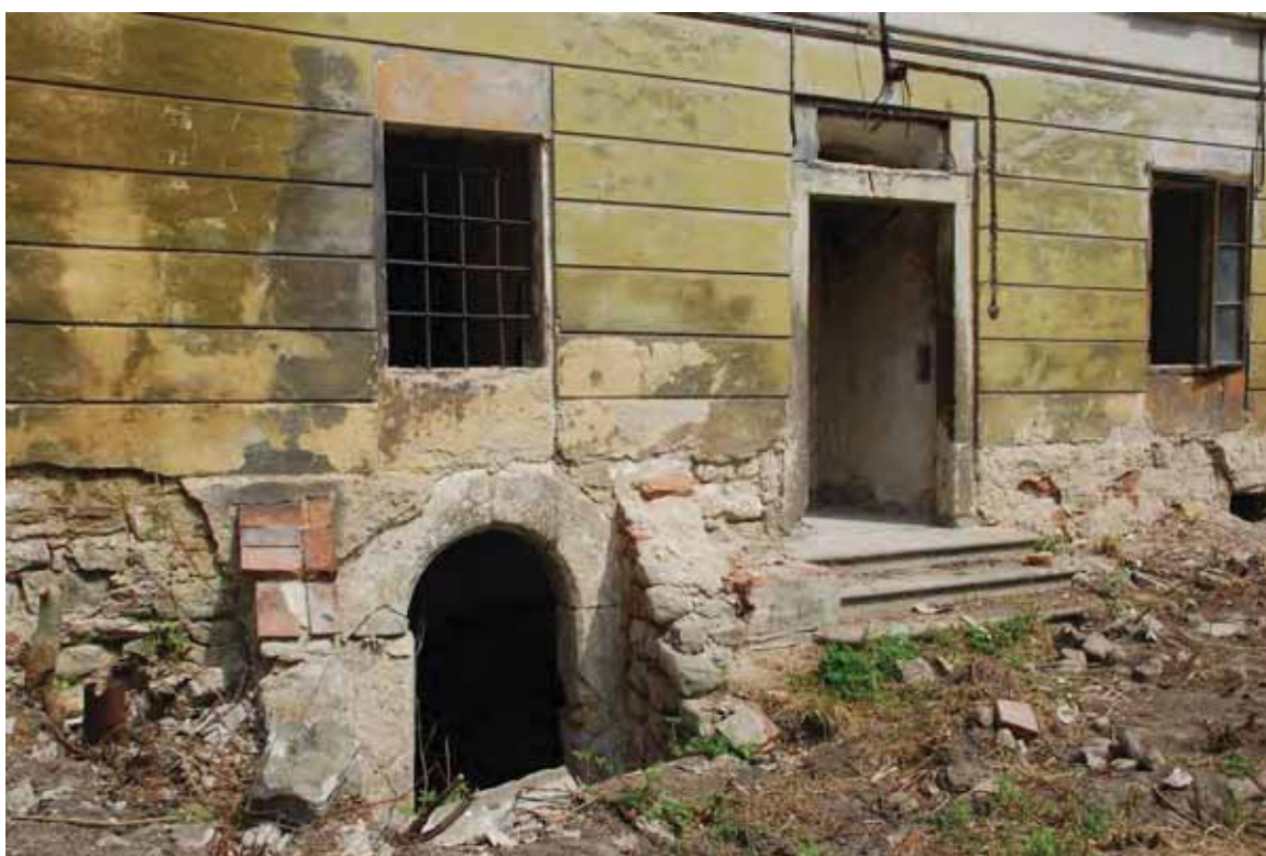
obr. 25/22 – Vstup do sklepení a hlavní vchod do obytné části (foto Pešta 2010).
