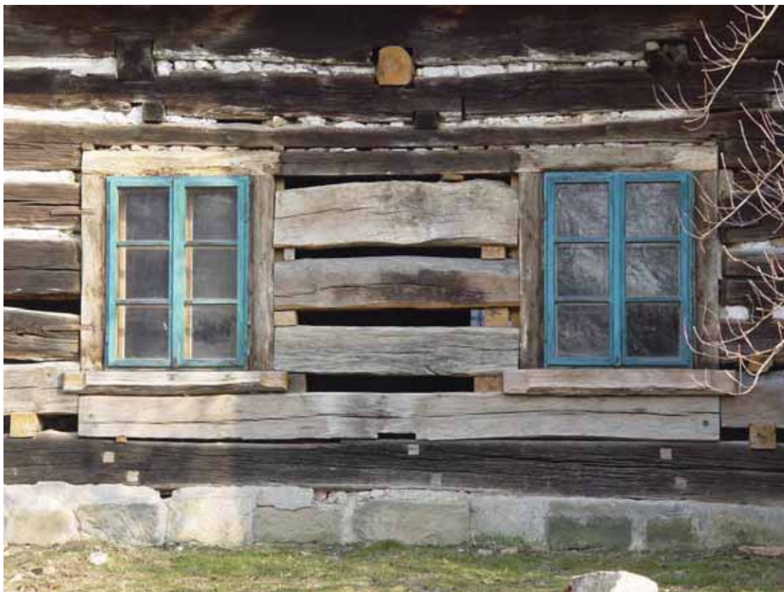
obr. 13/4 – Opravená stěna mezi okny západního podélného průčelí (foto Šimek 2011).
