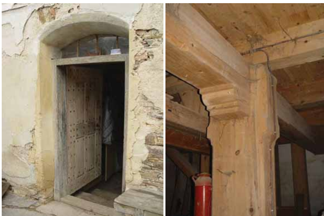
obr. 16/9 – Hlavní vchodové dveře (foto Šimek 2011).
