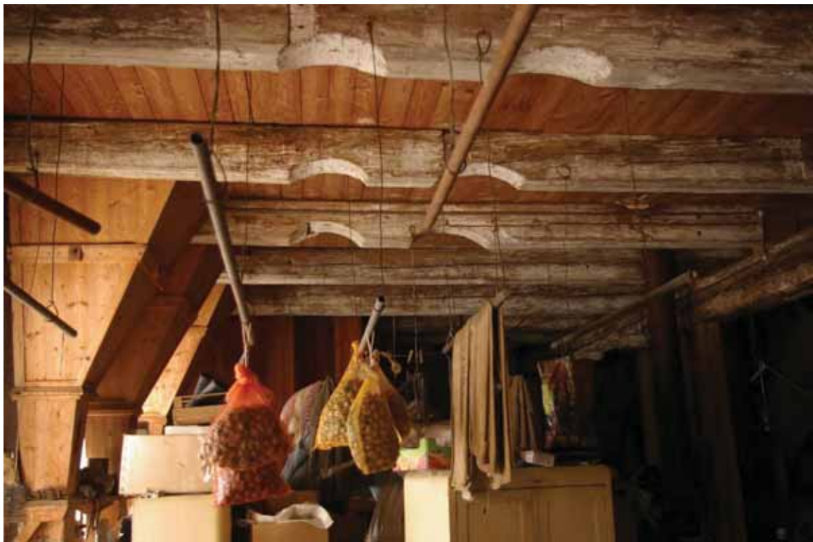
obr. 13/10 – Strop a násypky v prvním patře mlýna (foto Matějíček 2011).
