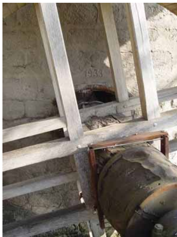
obr. 11/19 – Letopočet 1933 a poškozená hřídel vodního kola (foto Šimek 2011).
