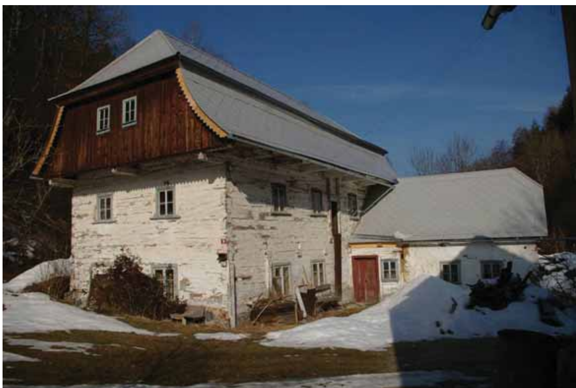
obr. 11/23 – Pohled na mlýn z jihovýchodu (foto Matějčíček 2011).
