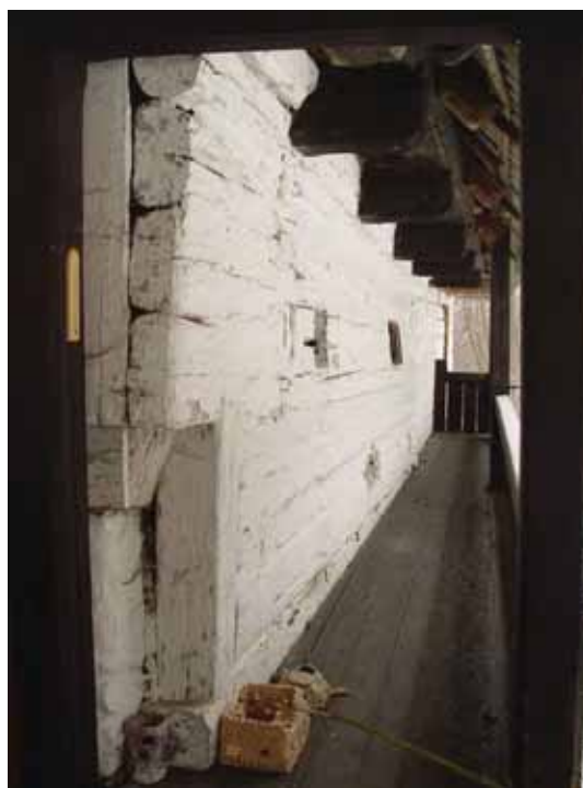
obr. 9/15 – Pohled na pavlač před mlýnicí (foto Šimek 2011).
