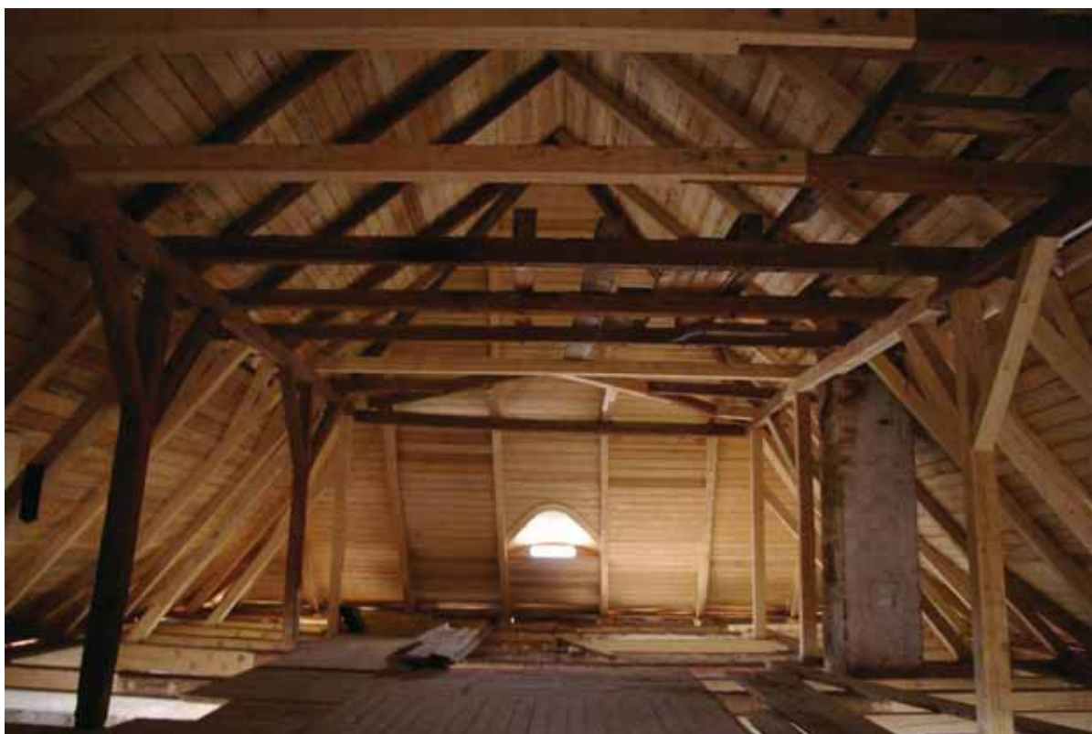
obr. 17/1 – Krov po opravě (foto Matějčíček 2011).
