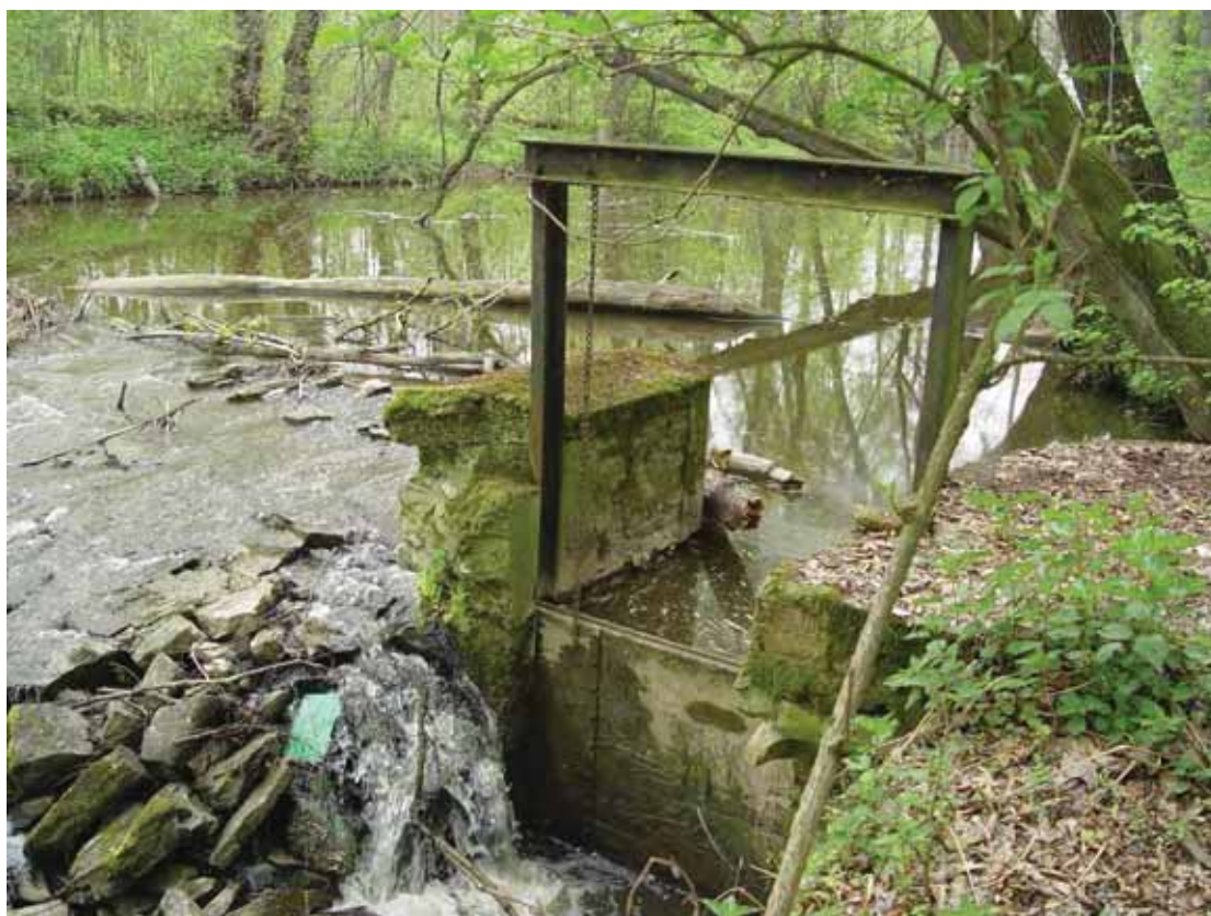
obr. 26/9 – Začátek náhonu s částí jezu (foto Šimek 2011).
