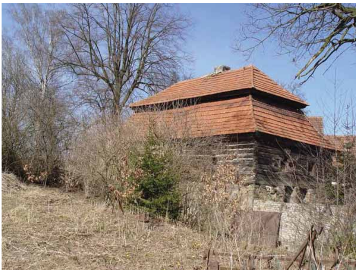
obr. 9/21 – Pohled na mlýn z jihu (foto Šimek 2011).
