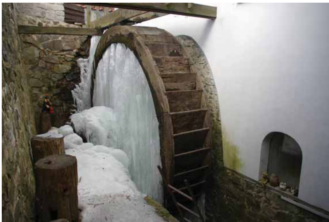
obr. 10/11 – Pohled na vodní kolo a prostup pro hřídel (foto Matějčíček 2011).
