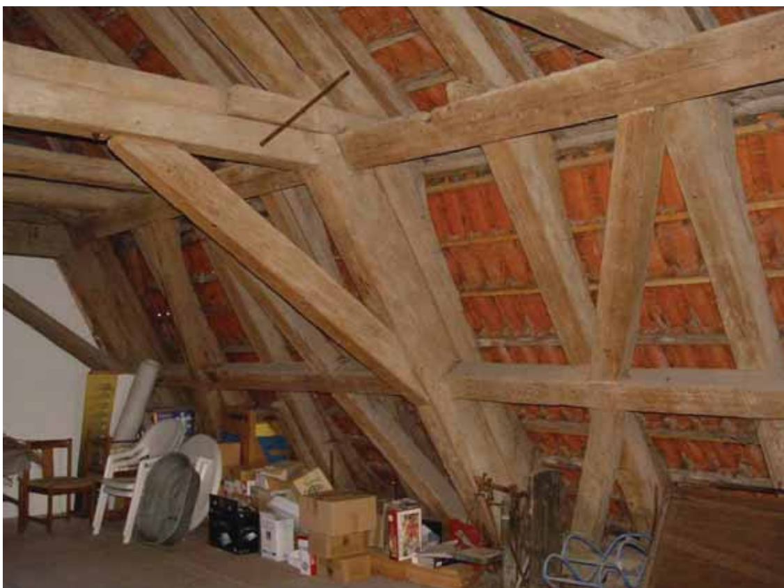
obr. 20/16 – Barokní krov (foto Šimek 2011).
