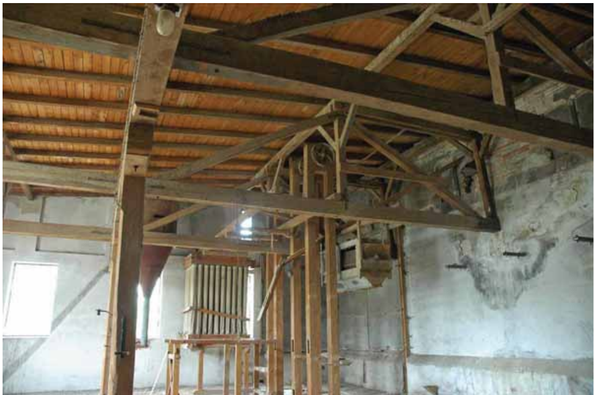
obr. 21/14 – Pohled do krovu nadstaveného patra nad barokní částí (foto Pešta 2006).
