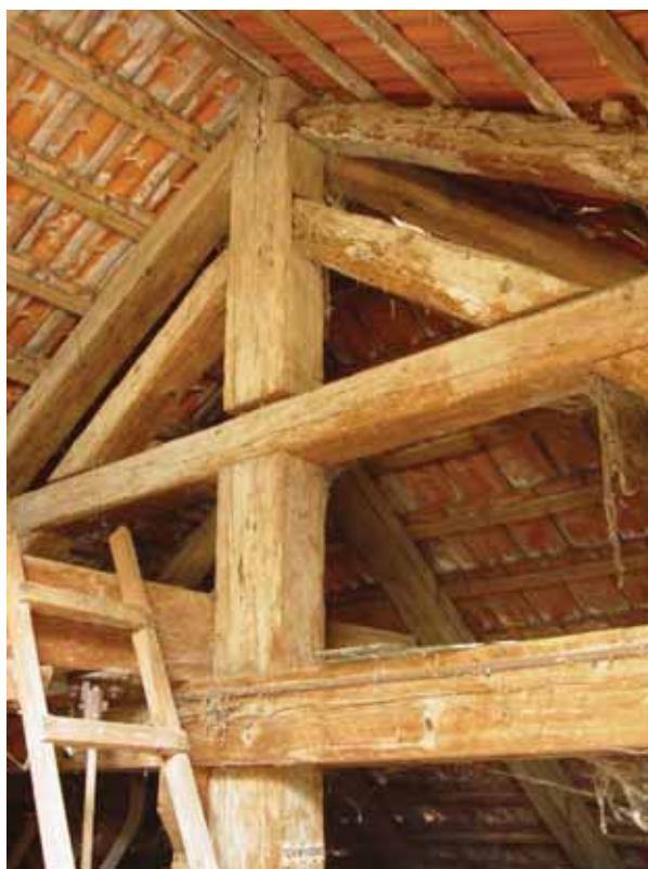
obr. 21/9 – Část barokního krovu (foto Šimek 2011).
