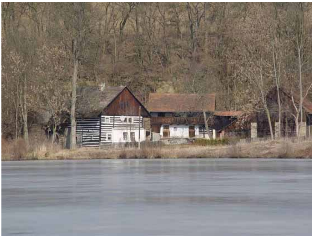
obr. 6/19 – Pohled na mlýn z jihu (foto Šimek 2011).
