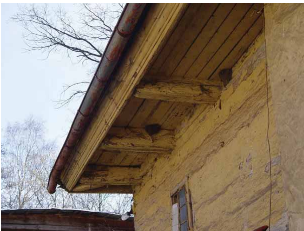
obr. 12/21 – Vazné trámy kryté profilovanou římsou (foto Šimek 2011).
