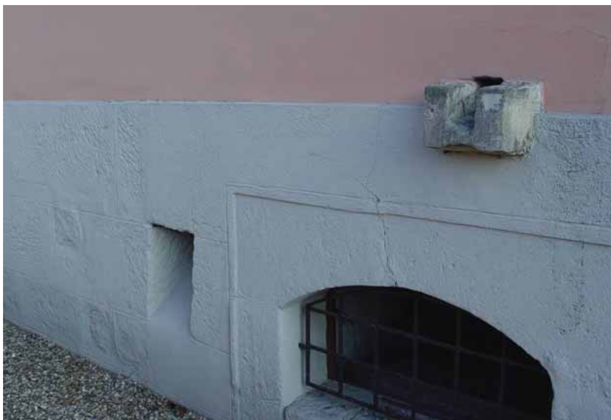
obr. 15/16 – Vyústění záchodu do prostoru lednice vlevo a vpravo žlábek pro odpadní vodu z kuchyně (foto Šimek 2011).
