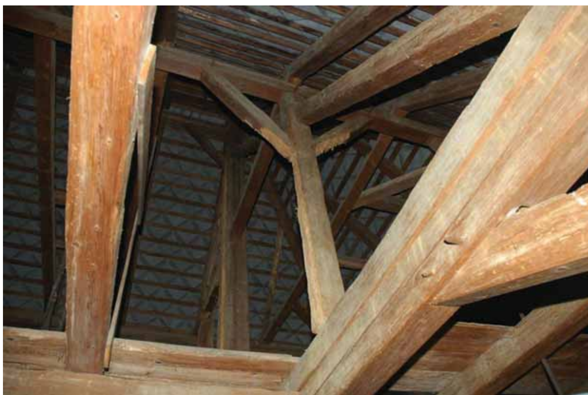
obr. 24/12 – Pohled do krovu (foto Pešta 2006).
