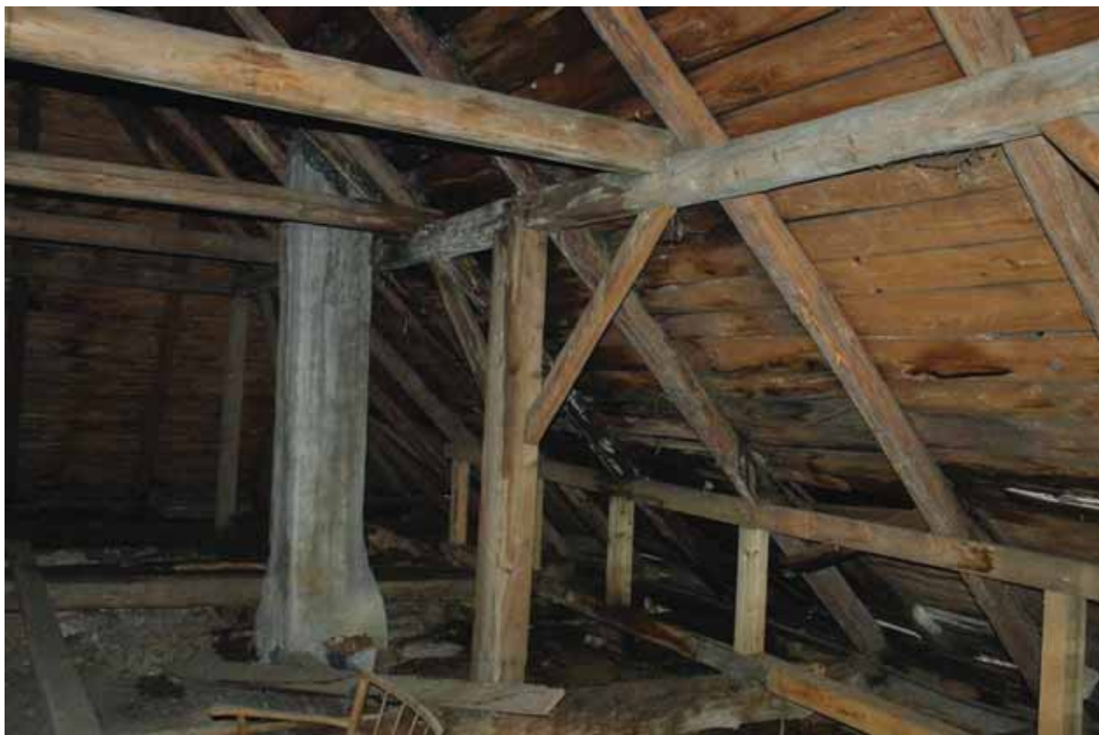
obr. 18/4 – Původní krov (foto Pešta 1997).
