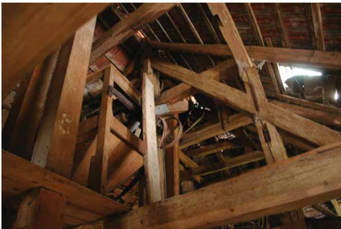
obr. 34/22 – Pohled do krovu mlýnice (foto Matějíček 2011).
