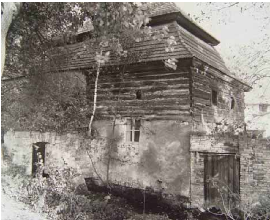
obr. 5/21 – Pohled na mlýn z jihu, vlevo dosud stojící kamenná lednice (fotografie převzata z: Inventarizační průzkum lidové architektury).
