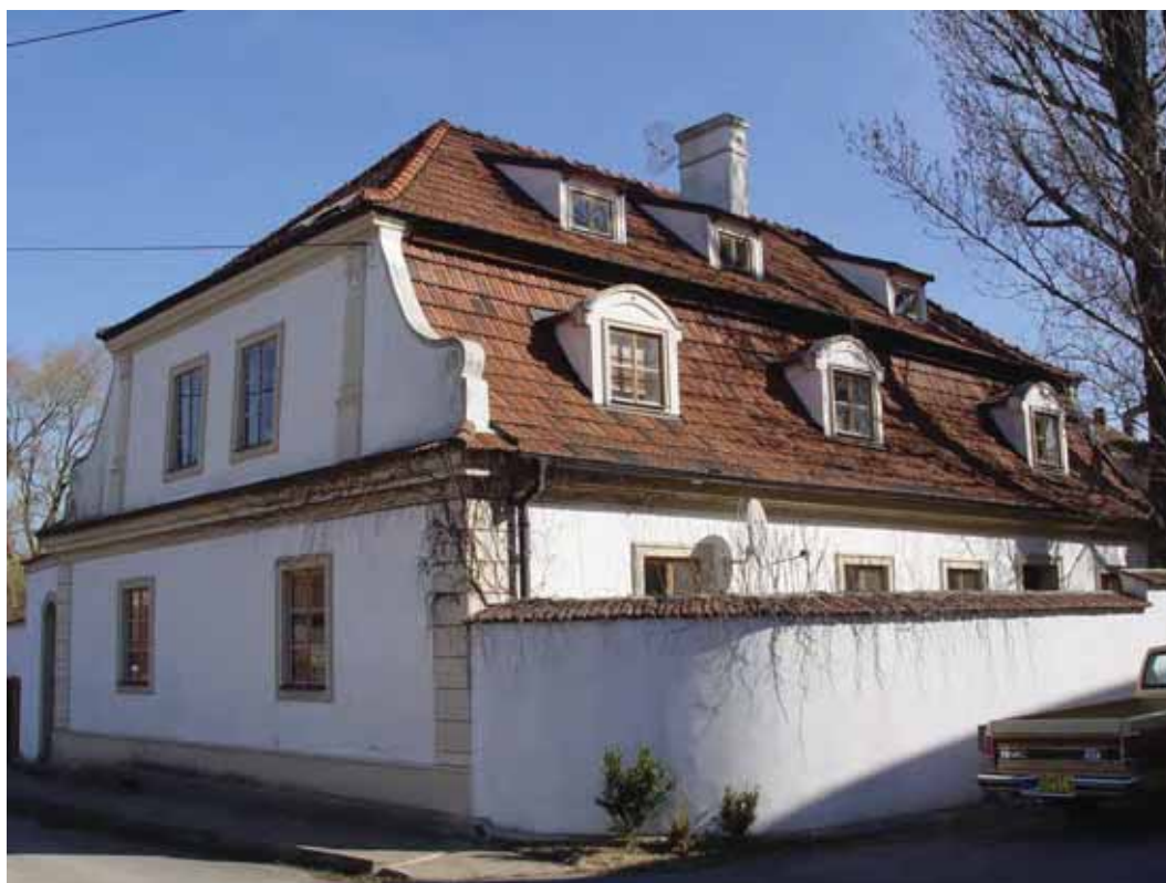
obr. 04 – Mlýn v Čičovicích (foto Šimek 2011).
