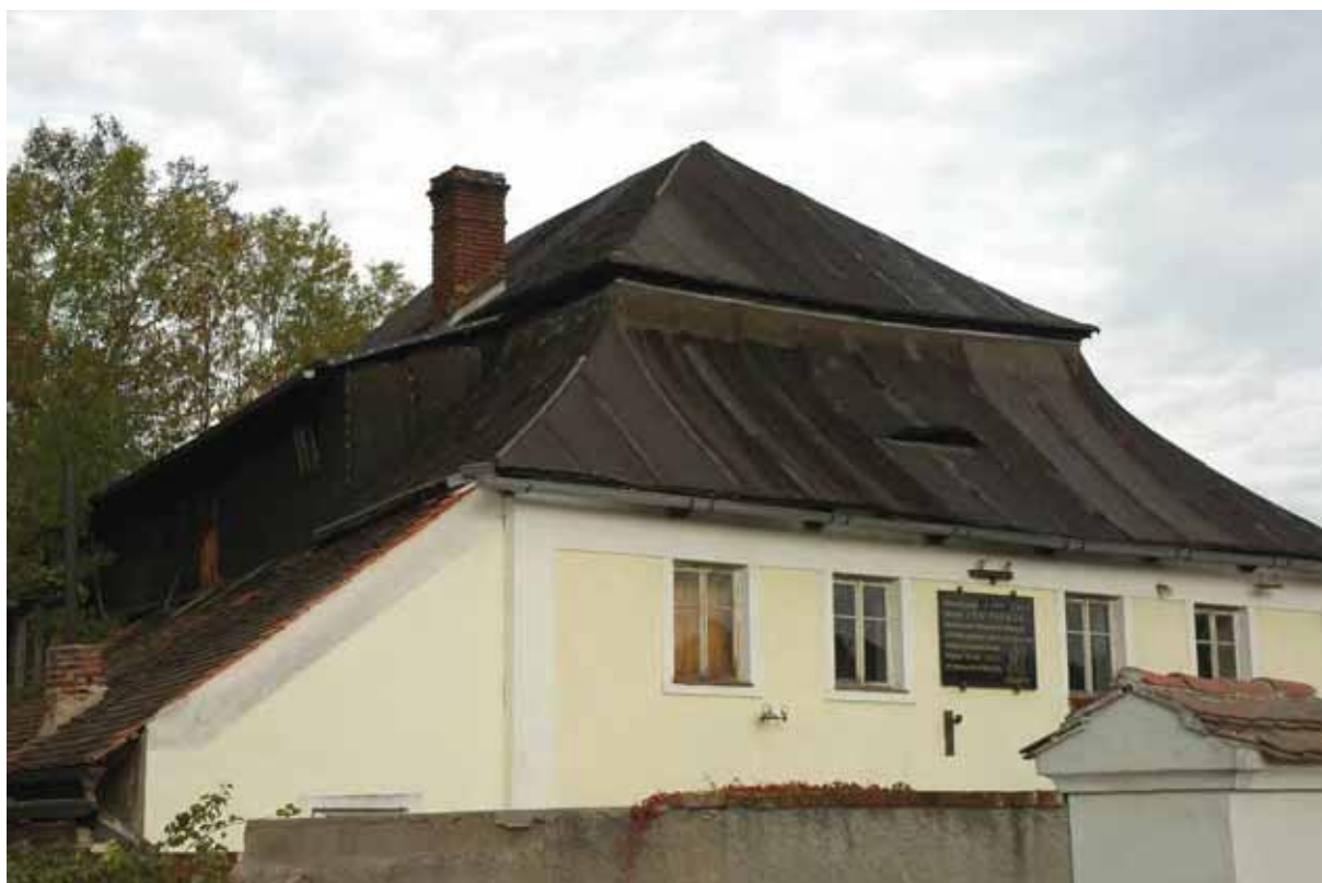
obr. 8/1 – Pohled na dnes zrušený střešní nástavec (foto Pešta 2006).
