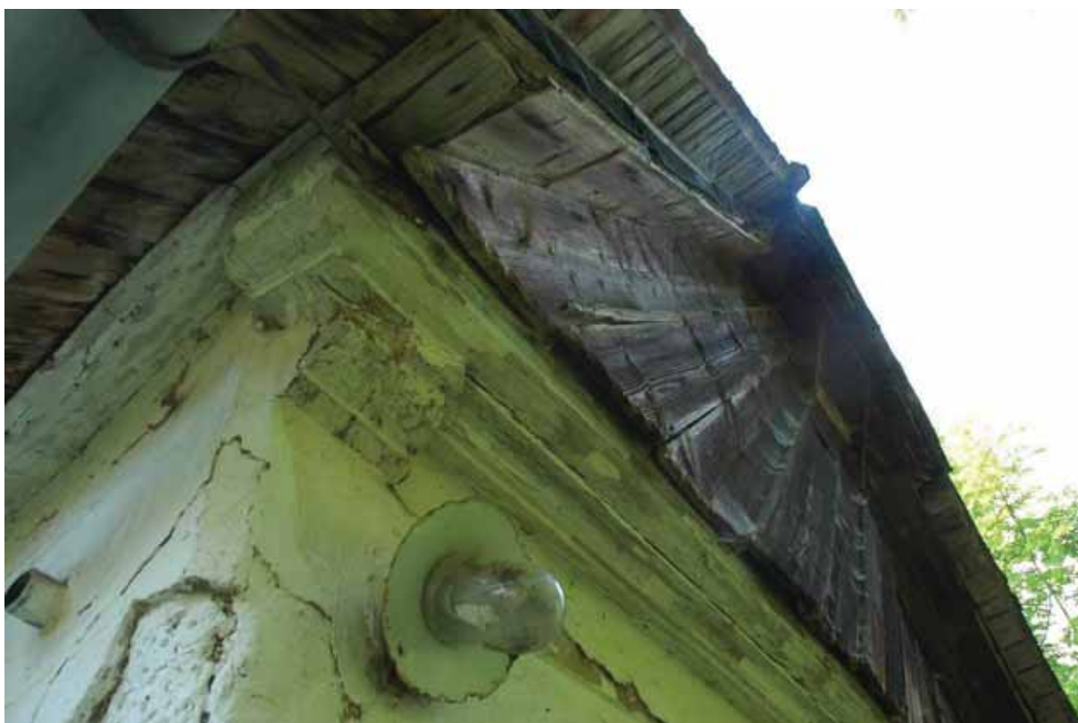
obr. 14/23 – Detail skladby trámů a štítu východního přístavku (foto Pešta 2008).
