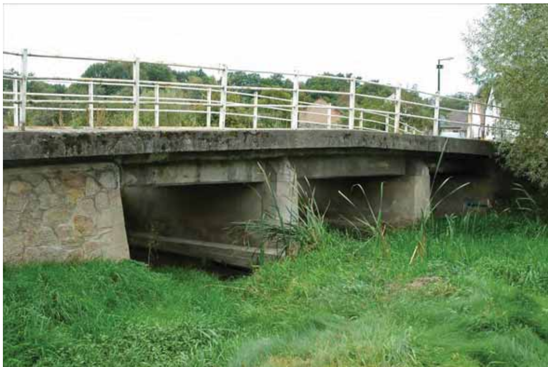
obr. 22/1 – Silniční most (foto Pešta 2006).
