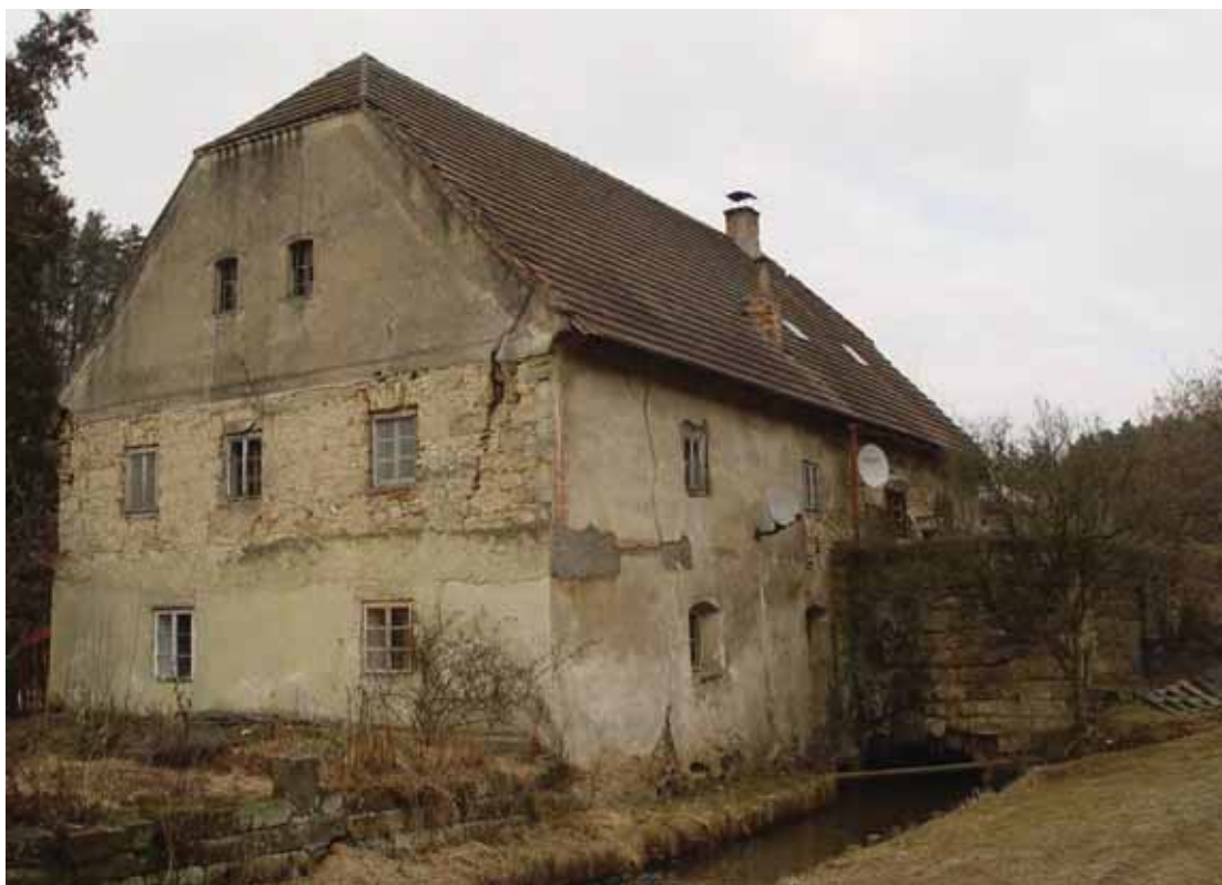
obr. 6/20 – Pohled na mlýn z jihu (foto Šimek 2011).
