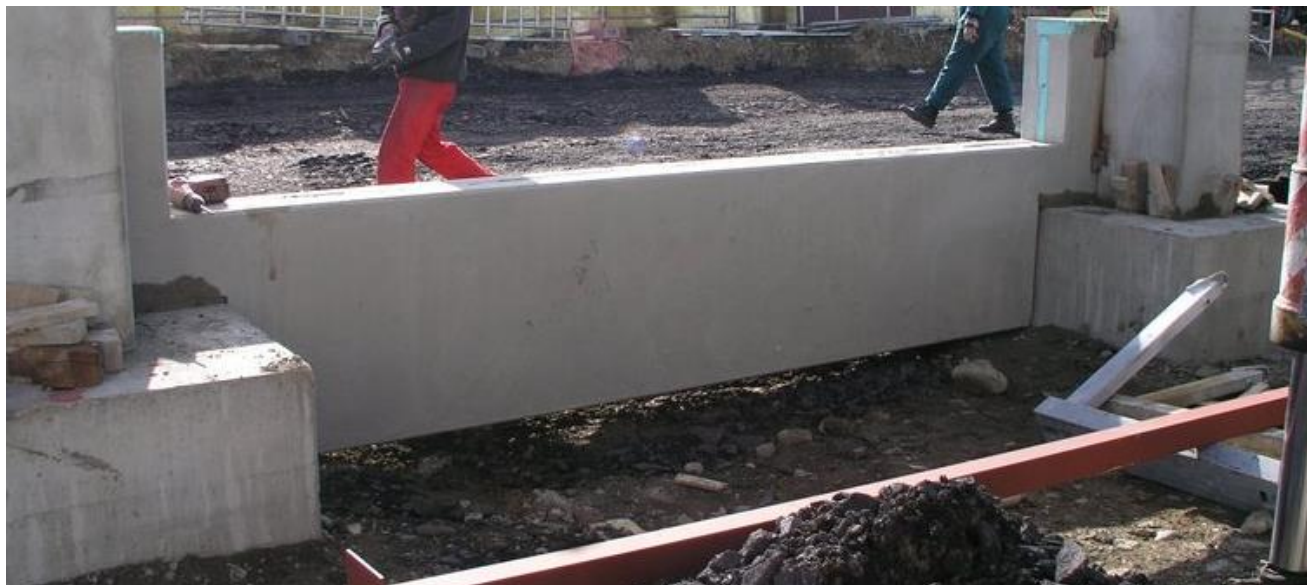
Obrázek 29 - Praktické zobrazení základového prahu
