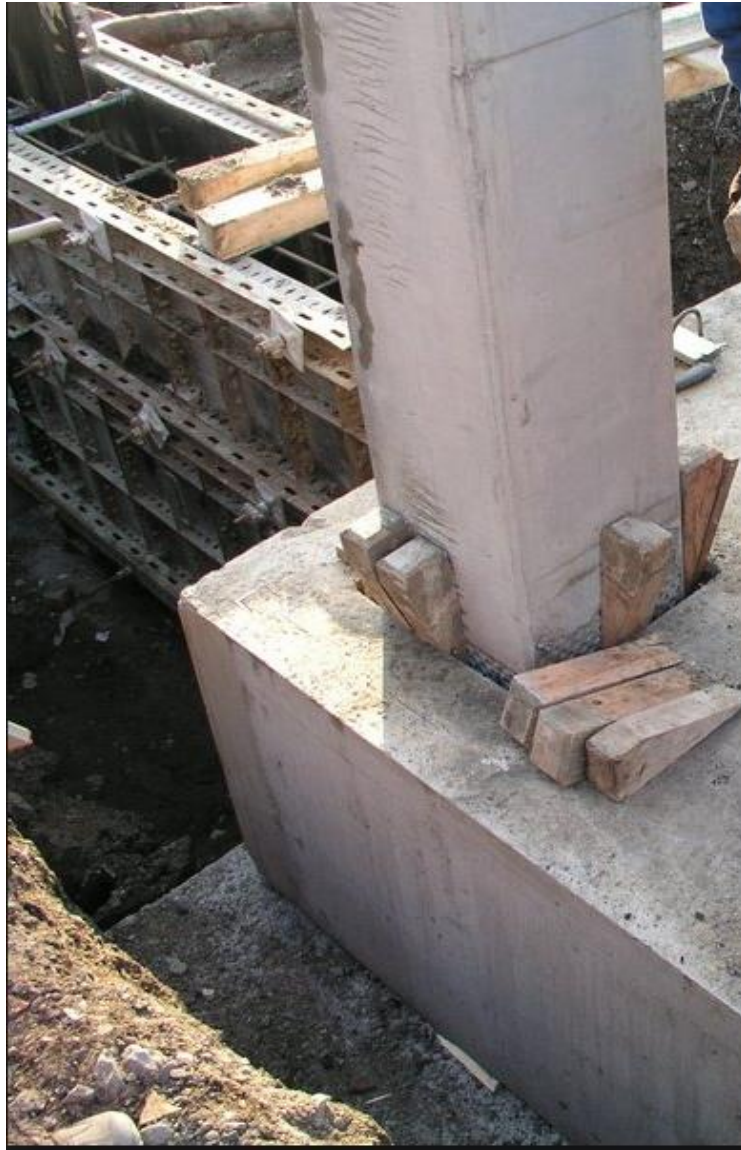
Obrázek 27 - Praktické zobrazení osazení sloupu do kalichu
