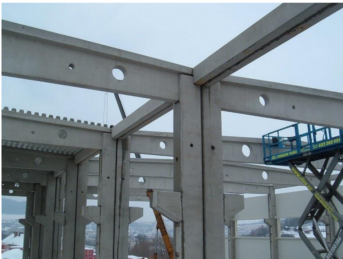
Obrázek 31- Praktické zobrazení vazníků spolu se střešním ztužidly
