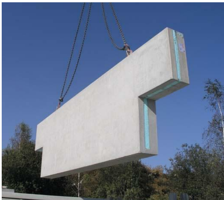
Obrázek 17 - Ilustrační foto základového prahu
