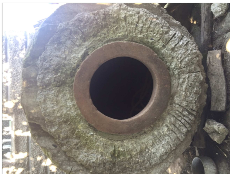
Obrázek 8 Obezdvíčka vnějšího pláště kvevri silnou vrstvou vápenaté malty (foto autor)
