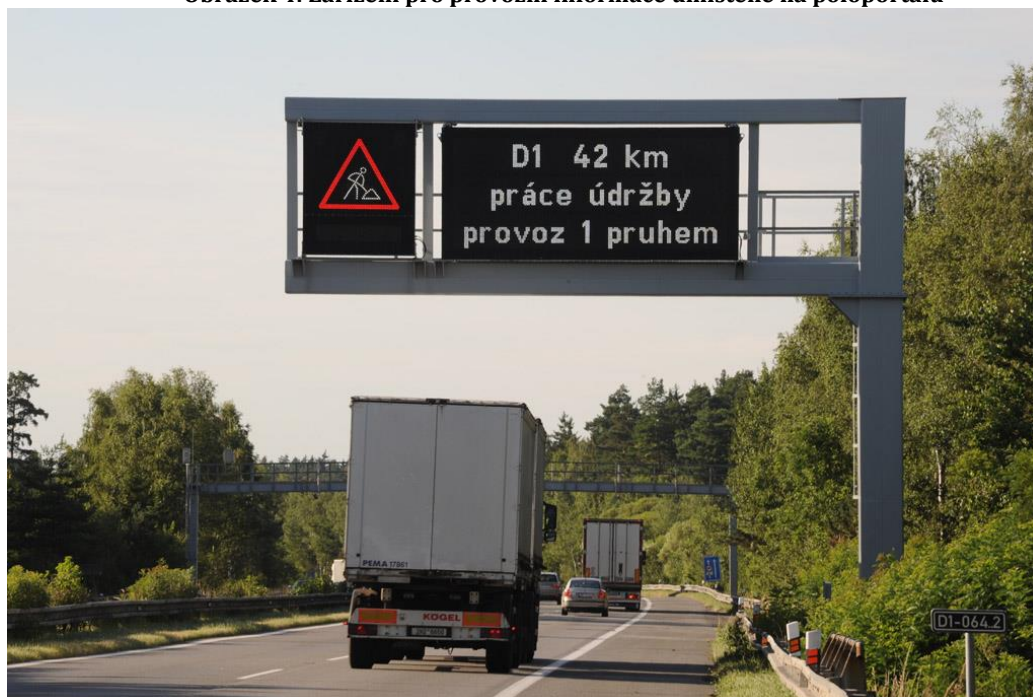
Obrázek 4: Zařízení pro provozní informace umístěné na poloportálu
