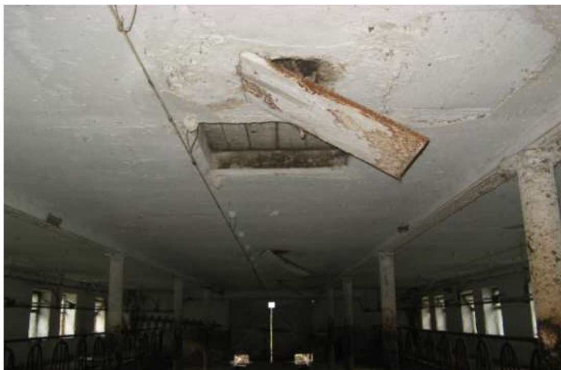
Foto č. 10: Větrací otvor a shoz z půdních prostor
