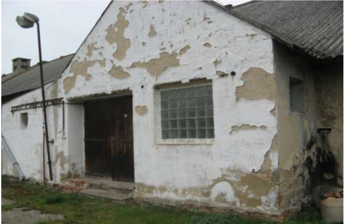
Foto č. 5: Jižní vstup do mléčnice a sociálních zařízení
