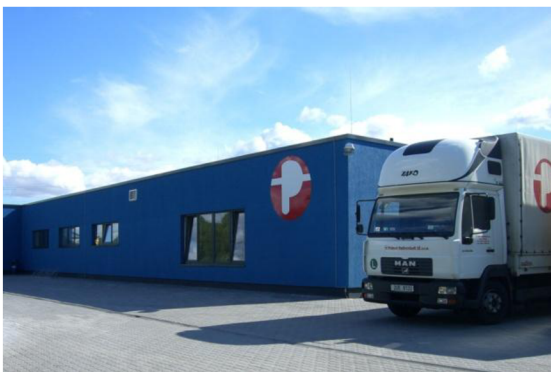
Obrázek 10 Budova Primed Halberstadt-CZ, s.r.o. (zdroj: www.primed-halberstadt.de , 2022)
