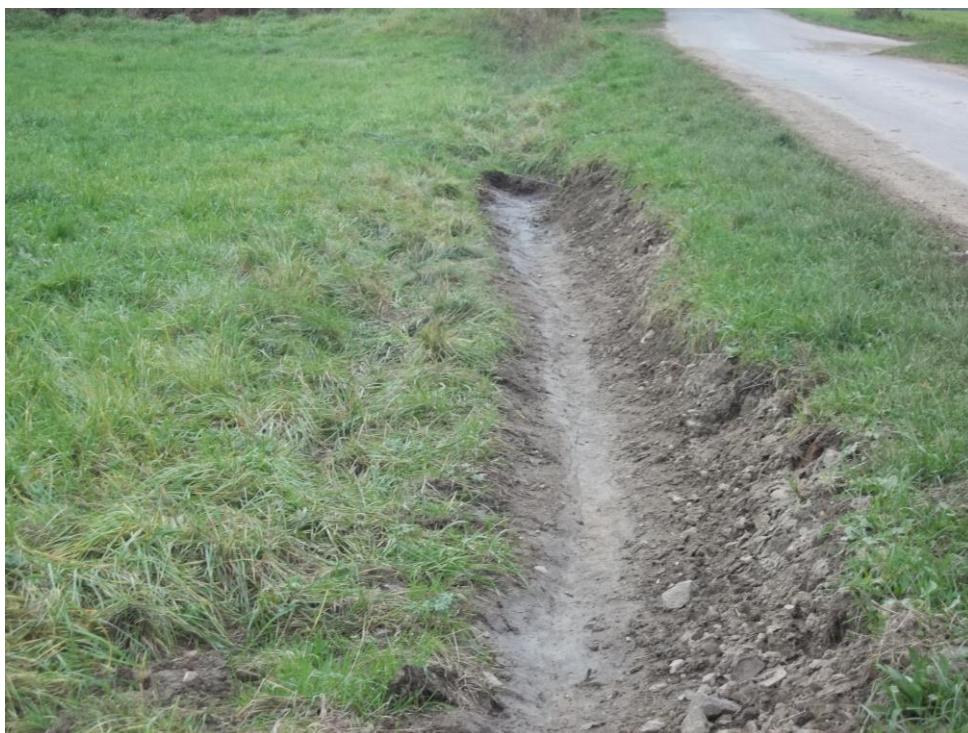
Foto č. 3 – Prohloubení svodného příkopu (Zdroj: vlastní, 2014).
