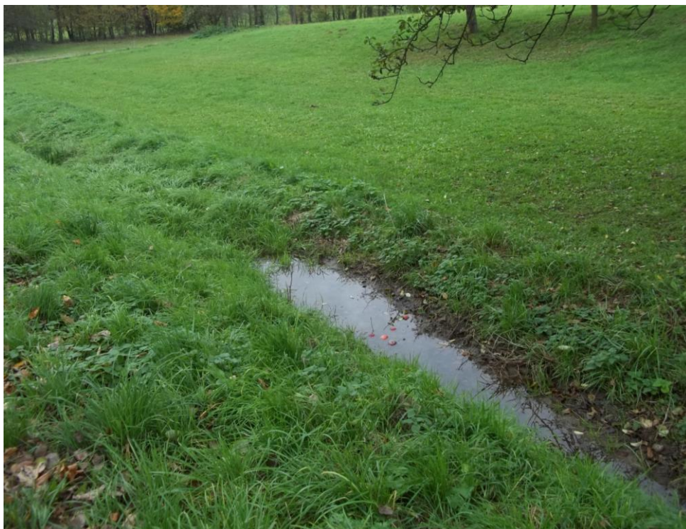
Foto č. 1 - Nutná úprava svodného příkopu (Zdroj: vlastní, 2014).
