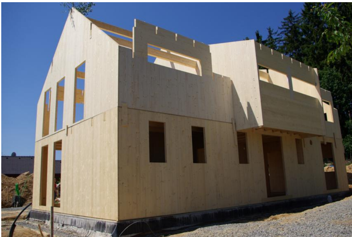
Obrázek 17 - Masivní dřevěná stavba z panelu NOVATOP [24]
