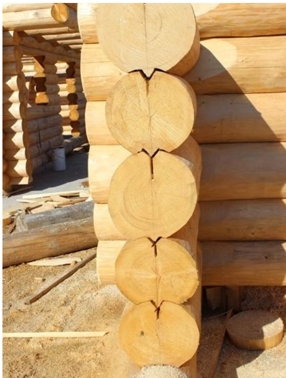
Obrázek 9 - Systém spoje srubu [17]
