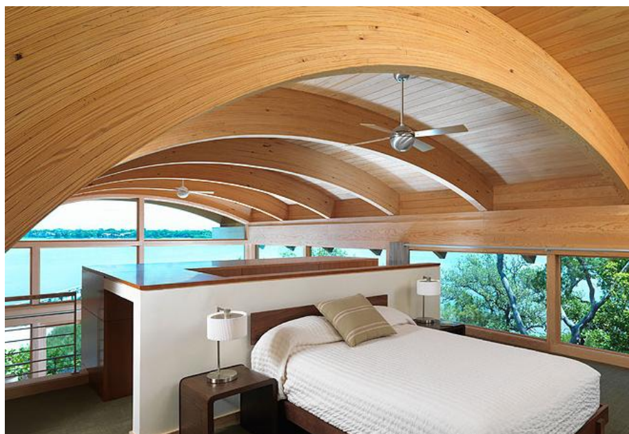
Obrázek 4 - Využití lepeného dřeva v praxi [12]
