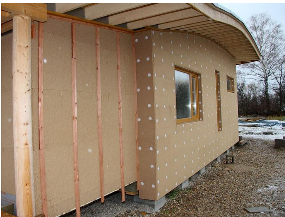
Obrázek 5 - Zateplení dřevovláknitou deskou [13]
