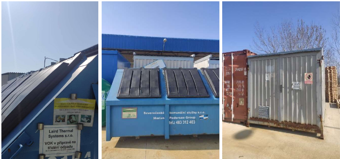
Obrázek 8: Venkovní velkoobjemové kontejnery a šedý kontejner na skladování nebezpečného odpadu, vybavený záchytnou vanou
