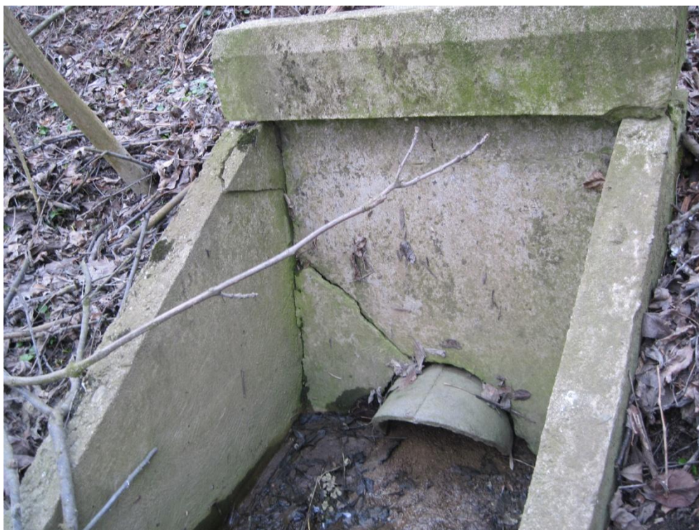
Foto č. 8: Ústí melioračního kanálu do Benkovského potoka (Pavlíková, říjen 2012)
