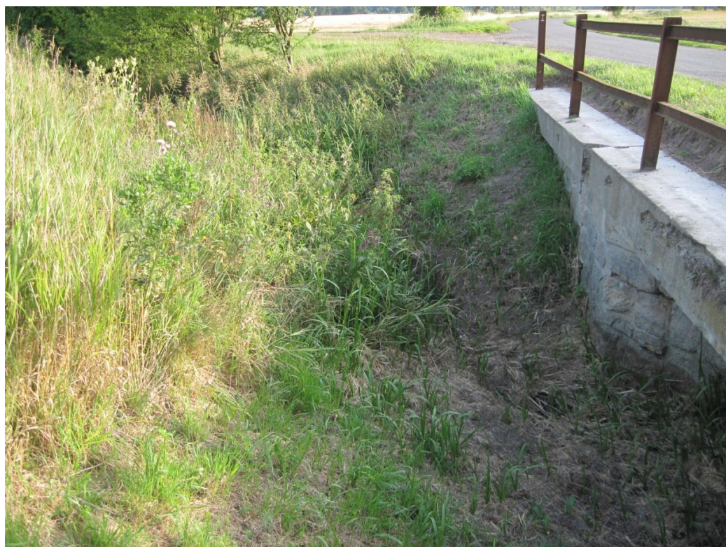
Foto č. 12: Zarostlé a vyschlé koryto v horní části vodního toku (Pavlíková, srpen 2012)
