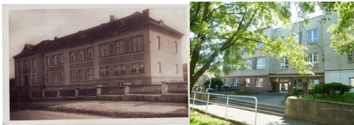
Obrázek 6: Měšťanská škola v čp. 215 a Obecní úřad městyse Chudenice tamtéž
