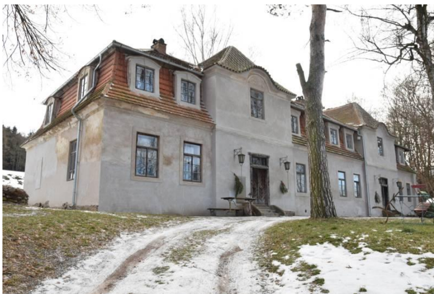
Obrázek 4.25: Barokní zámek v Elbančicích (zdroj: vlastní)
