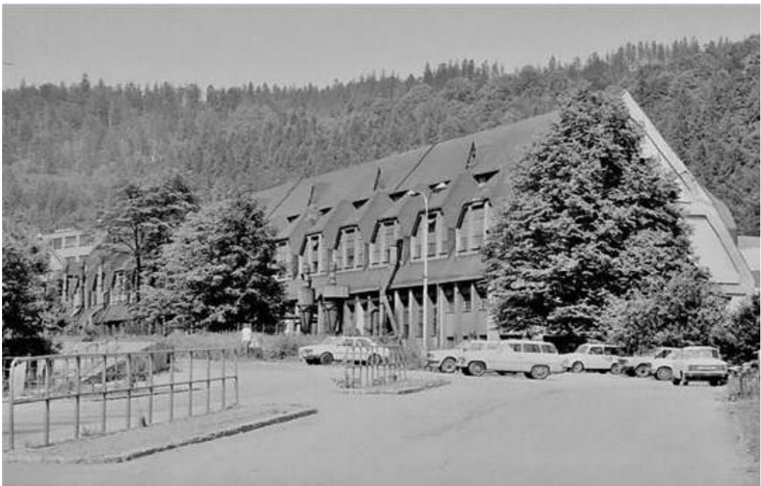
Obr. 2 - Objekt č. 4 (zdroj: www.mestovsetin.cz )
