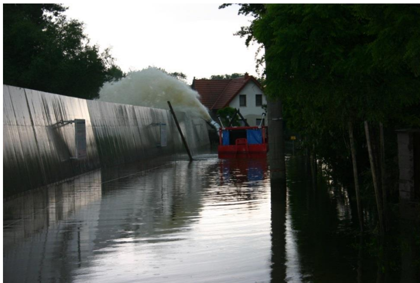
Obrázek 12, Nasazení velkokapacitního čerpadla v Hoříně (archiv HZS Mělník)
