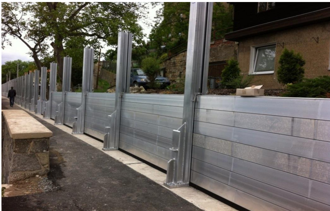
Příloha A, Zkouška montáže mobilního hrazení v části Rybáře – týden před povodněmi.(archiv HZS Mělník)
