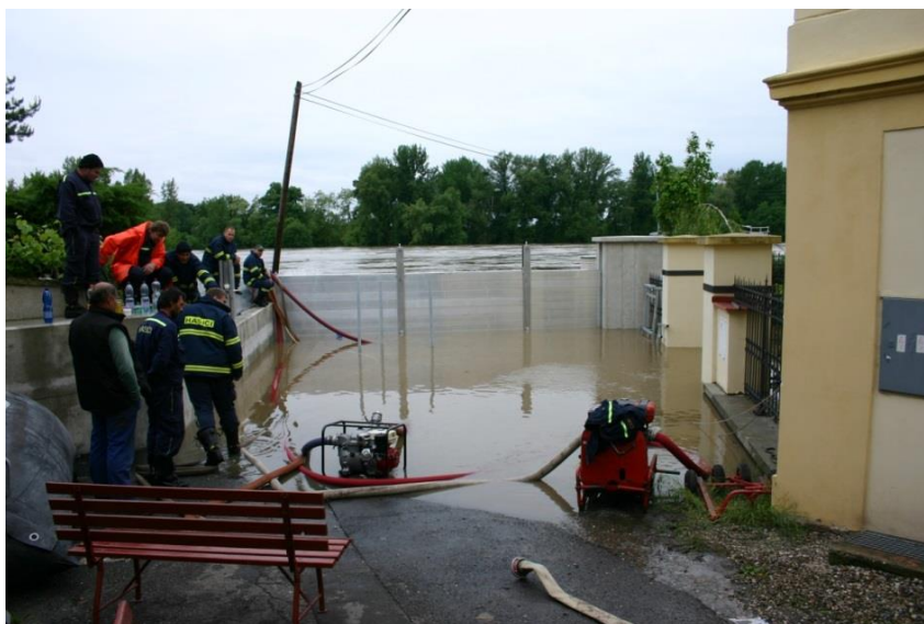
Obrázek 8, Odčerpávání vody za mobilním hrazením části Vinařství (archiv HZS Mělník)
