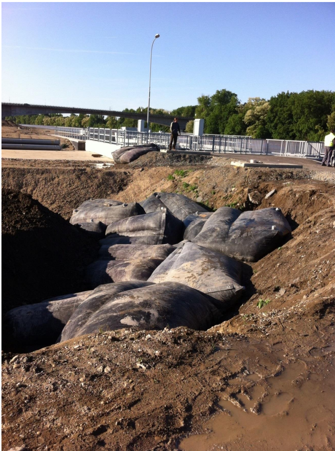
Příloha R, Instalované vodní vaky k zamezení dalšího trhání hráze Mělník.(archiv HZS Mělník)
