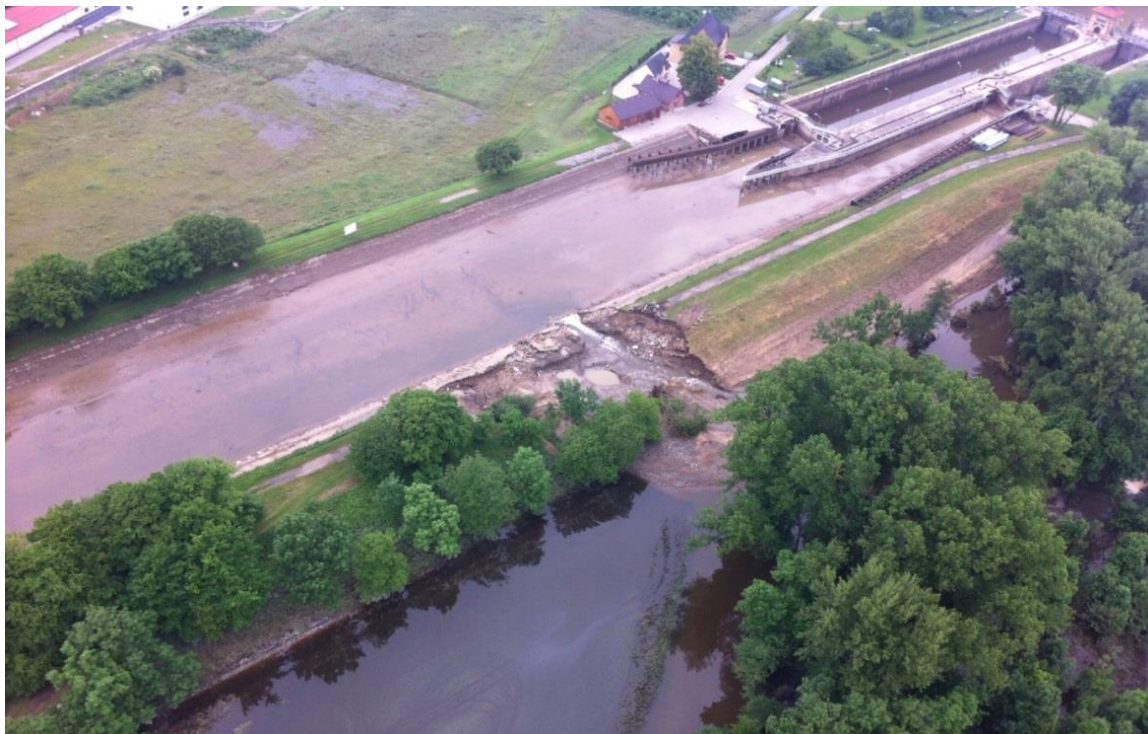
Příloha J, Umělé odvodnění plavebního kanálu v obci Hořín.(archiv HZS Mělník)
