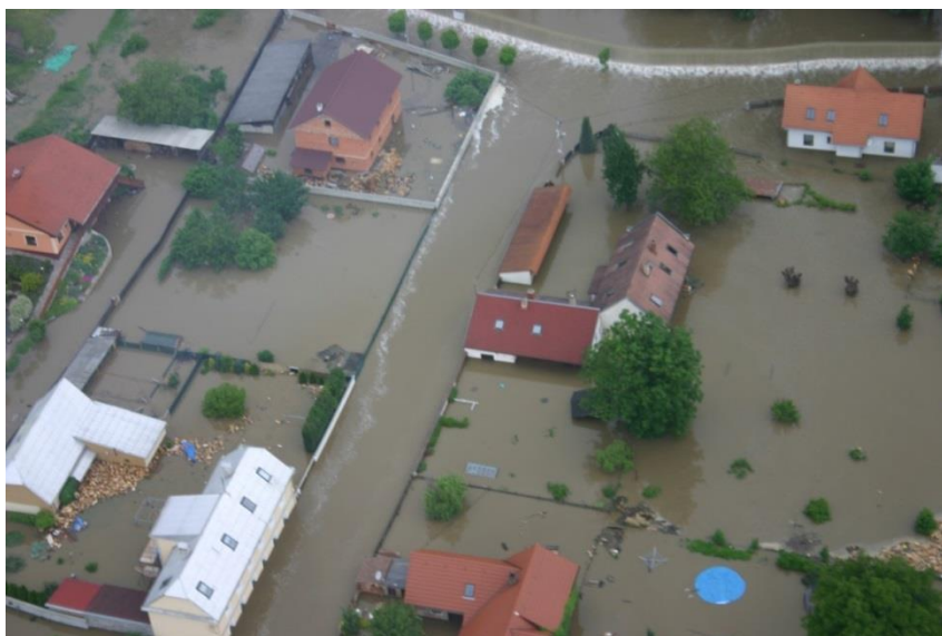
Obrázek 11, Zatápění obce Hořín po přelivu povodňové hráze (archiv HZS Mělník)
