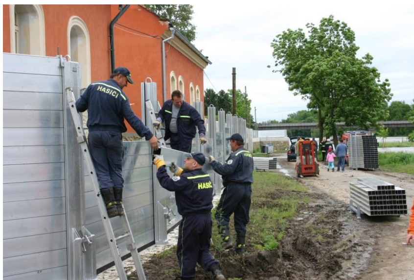
Obrázek 7, Stavba mobilní povodňové hráze Mělník – Vinařství (archiv HZS Mělník)
