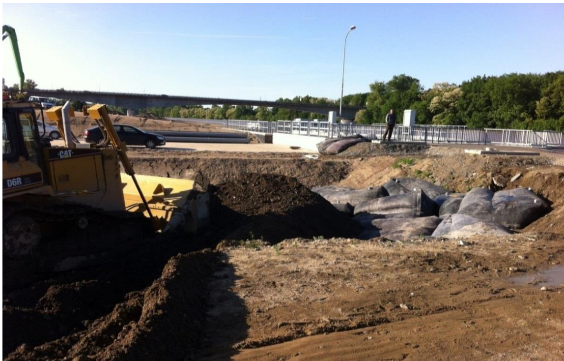
Příloha H, Opatření k zamezení průsaku (trhání) hráze Mělník.(archiv HZS Mělník)
