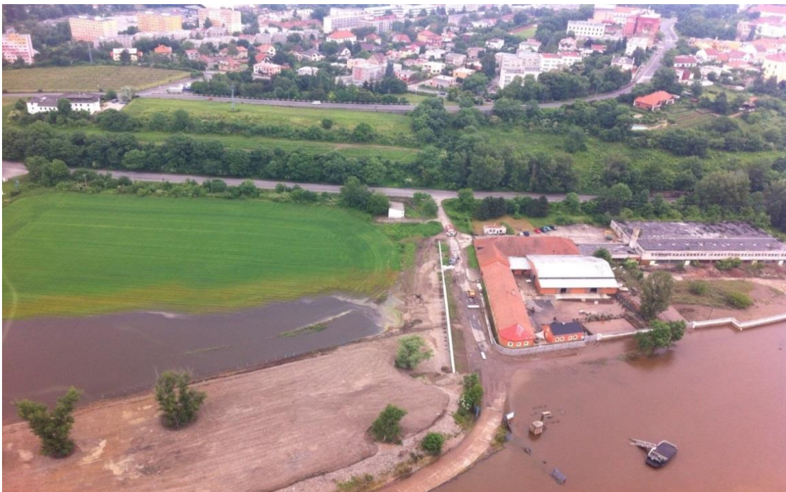
Příloha L, Pohled na mobilní hrazení v části Vinařství. (archiv HZS Mělník)
