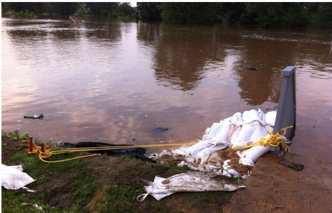
Příloha I, Opatření k zamezení průsaku hráze Mělník.(archiv HZS Mělník)
