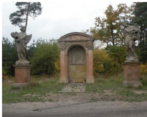
Obr. č. 30: Pohled ze sev. na výklenkovou kapli
