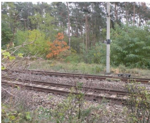
Obr. č. 31: Pohled z jihu na místo bývalé eremitáže
