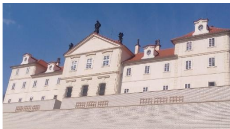
Obr. č. 7: Pohled na klášter z jihu
