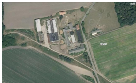
Obr. č. 24: Dvůr Karlov v současnosti, zdroj: URL 4
