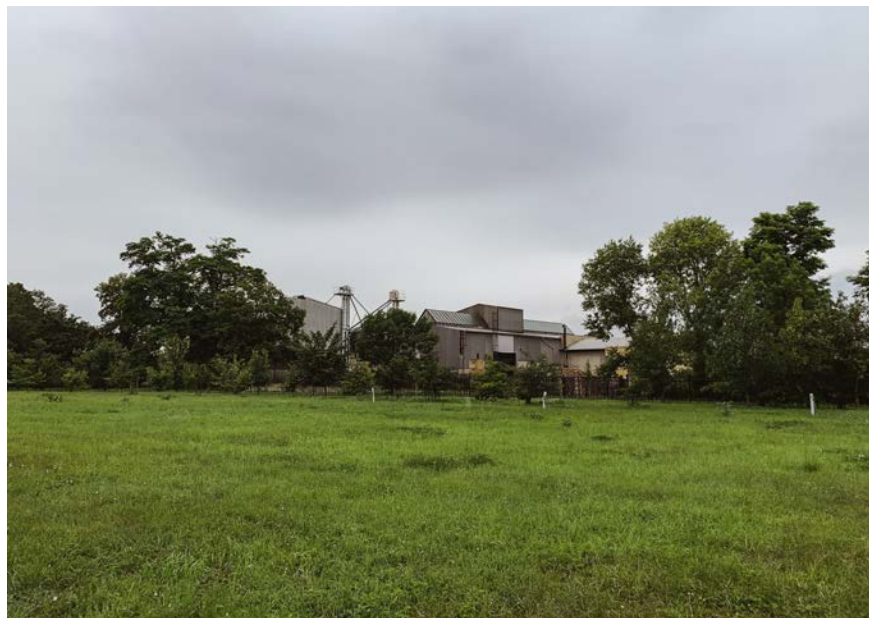
Obr. č. 53 - 57- Současný stav Fotografie: autorská práce
