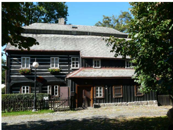
Obr. č. 12: Dochovalá Sklářská škola v Kamenickém Šenově
