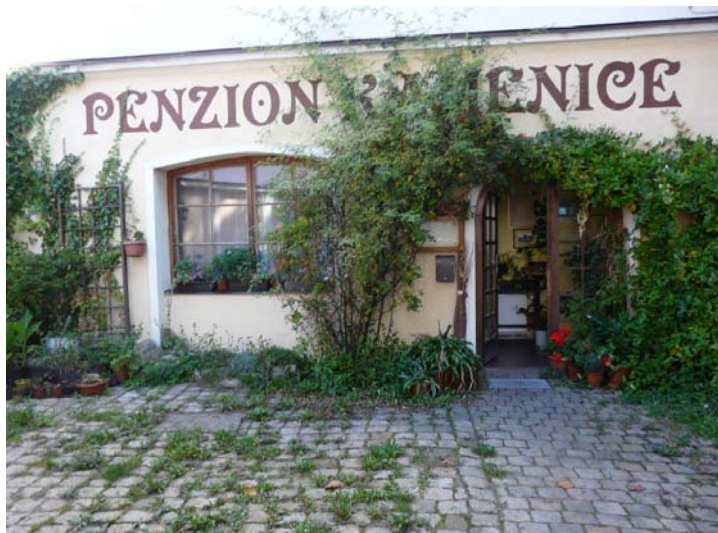
Obr. č.18 : Penzion Kamenice
