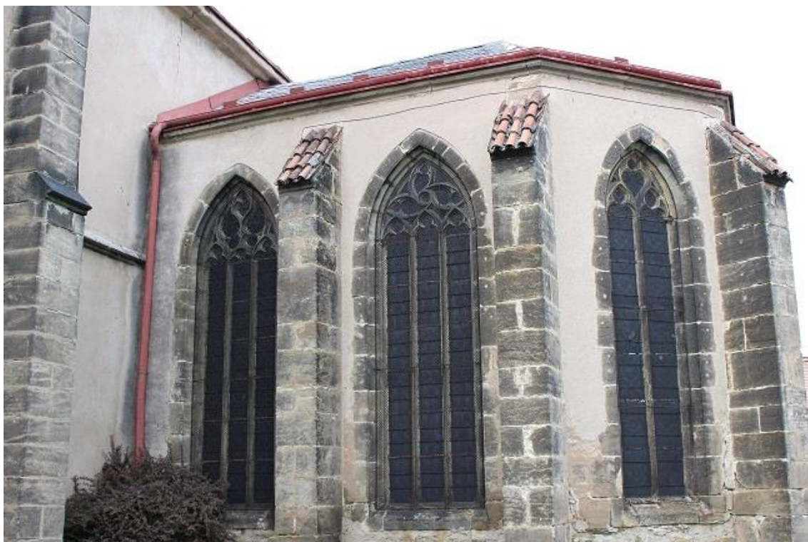
6) Chrudim, kostel sv. Kateřiny, pohled na presbytář od jihu
