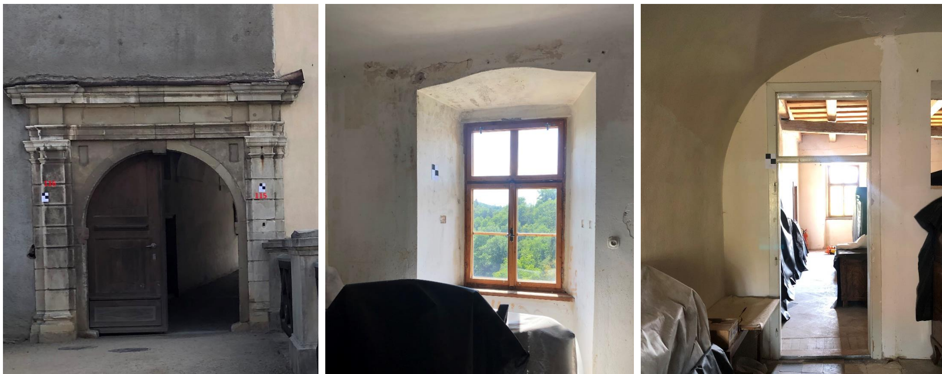
Obrázek 11 – Umístění černobílých šachovnicových terčů použitých jako navazovací body při LS
