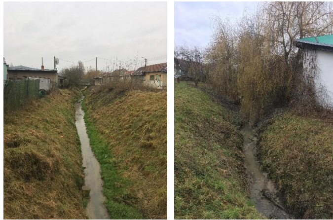
Obr. 35 Přímý úsek, lichoběžníkové koryto říční km 8,345, MO_LES_011 [Čihák]
