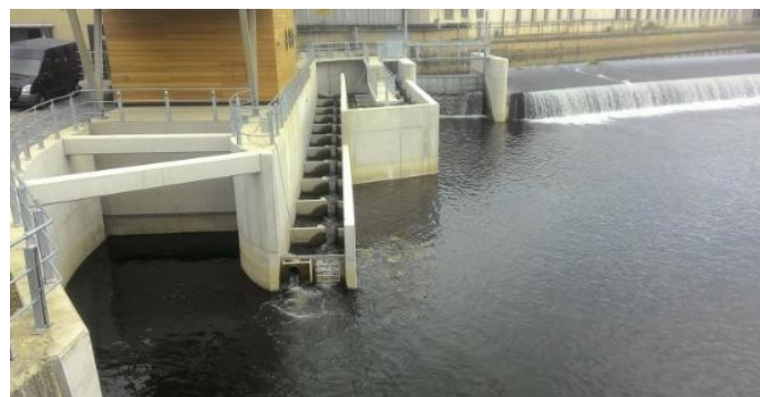
Obr. 25 Technický štěrbinový rybí přechod [58]
