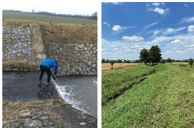
Obr. 37 Spádový stupeň, zahloubené koryto s hrázkou, říční km 0,075, MO_LES_002 [Čihák]
