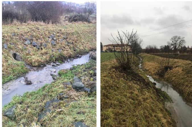
Obr. 36 Zanesené, uměle zahloubené koryto, říční km 7,025, MO_LES_009 [Čihák]
