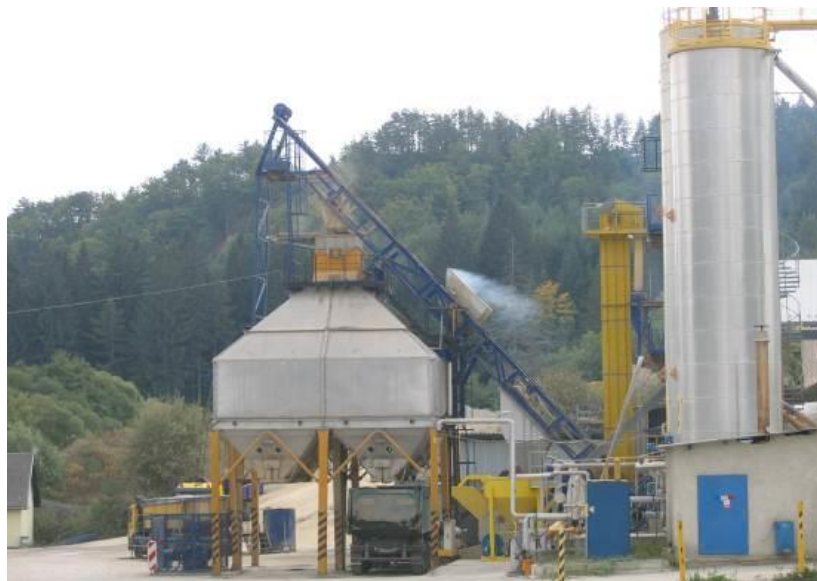
Obrázok 16: Výroba asfaltovej zmesi SMA 11 modifikovanej asfaltom PmB 45/80-55
