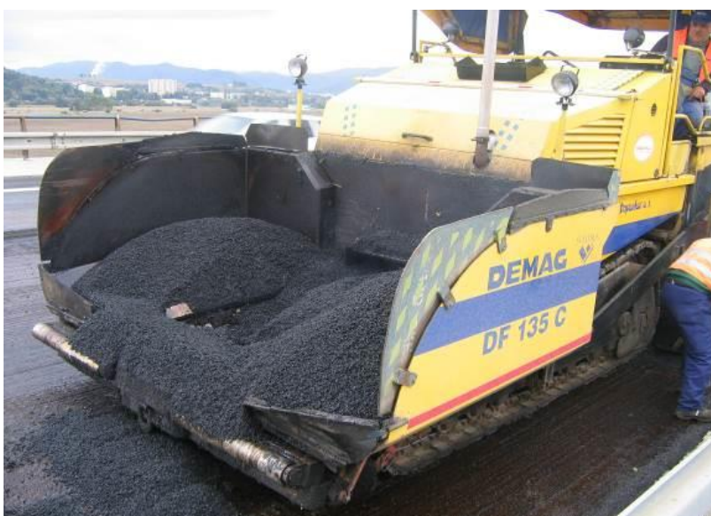
Obrázok 18: Pokládka zmesi SMA 11 modifikovaná asfaltom PmB 45/80-55
