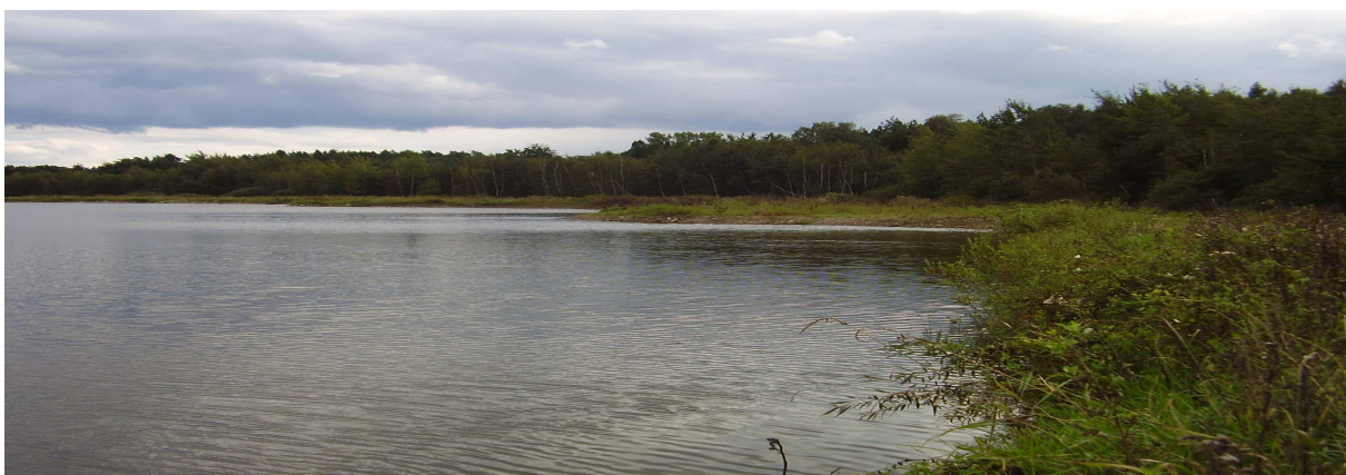
Obr. 7: Násyp, pískovna Horusice I pohled od S, 22. 8. 2006
