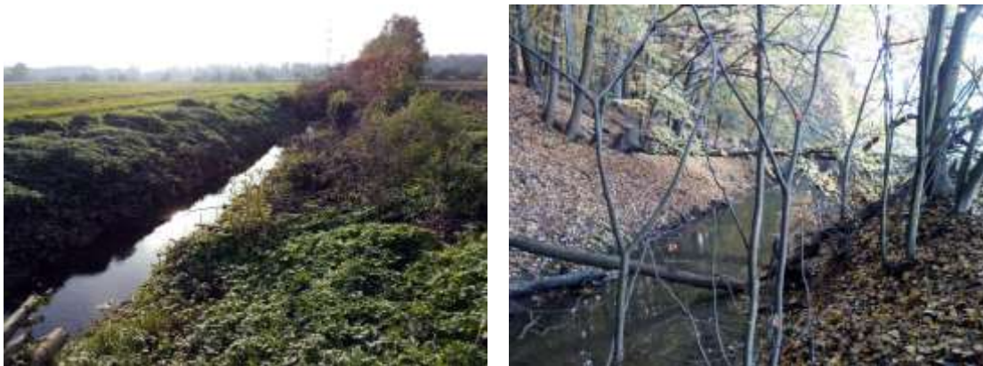
Obrázek 51 - Doubravka úsek HM_DOUB_001 (zdroj: archiv autora)
