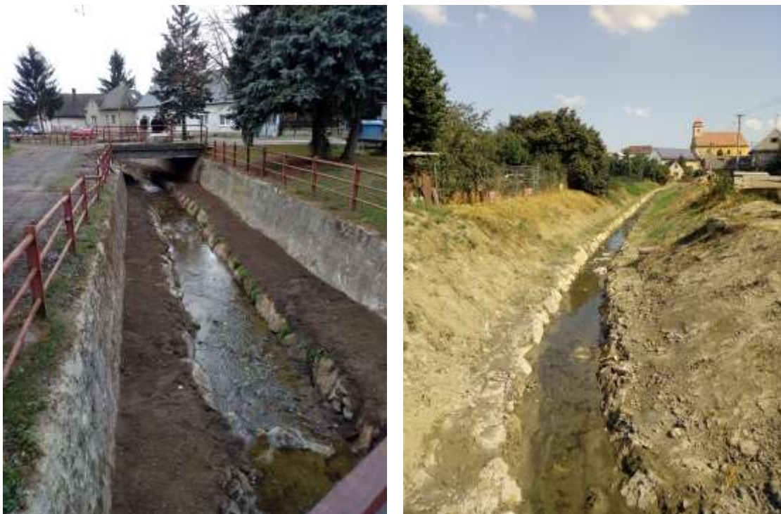
Obrázek 14 - Fotodokumentace stavby na Doubravce (zdroj: archiv Povodí Moravy, Šumperk)
