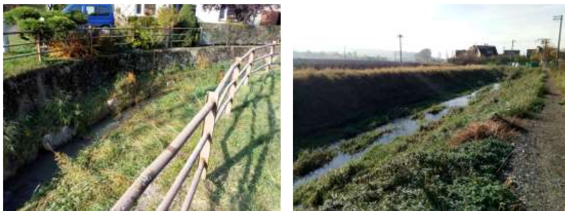
Obrázek 56 - Doubravka úsek HM_DOUB_003 (zdroj: archiv autora)
