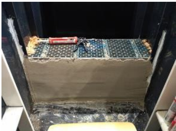
Obr. 54 Konstrukce po nanesení jádrové omítky
