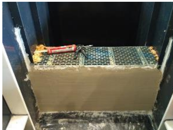
Obr. 55 Konstrukce po nanesení finální povrchové úpravy
