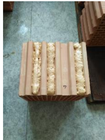
Obr. 44 Nanesení zdicí PUR pěny Dryfix
