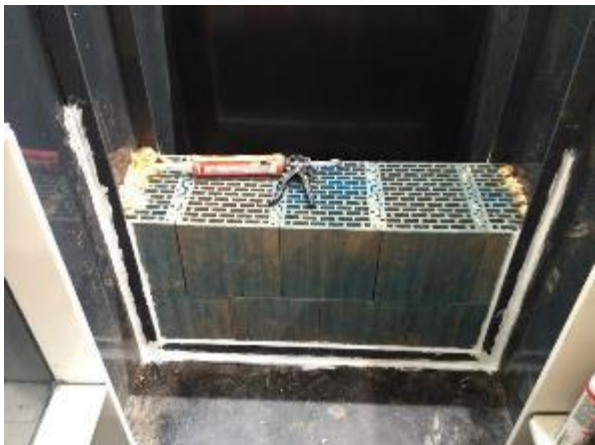
Obr. 52 Lícová strana konstrukce z mokré strany po vyzdění konstrukce
