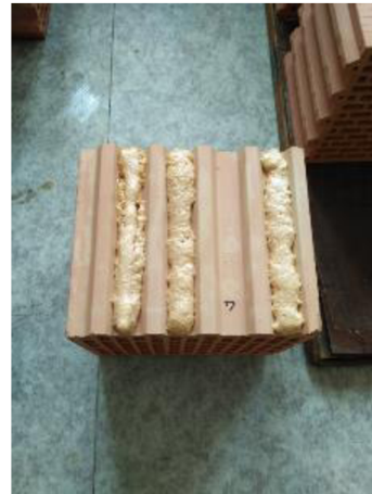
Obr. 44 Nanesení zdicí PUR pěny Dryfix
