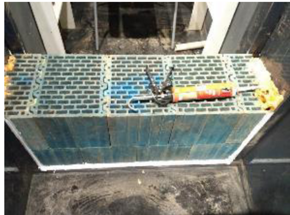
Obr. 53 Lícová strana konstrukce ze suché strany po vyzdění konstrukce
