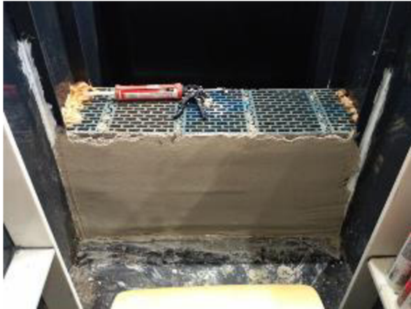
Obr. 54 Konstrukce po nanesení jádrové omítky
