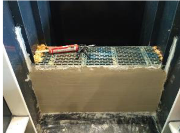
Obr. 55 Konstrukce po nanesení finální povrchové úpravy
