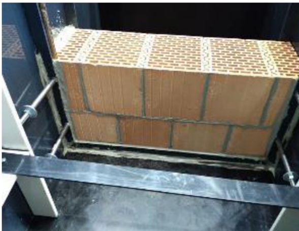
Obr. 46 Lícová strana konstrukce z mokré strany před zatopením vodou
