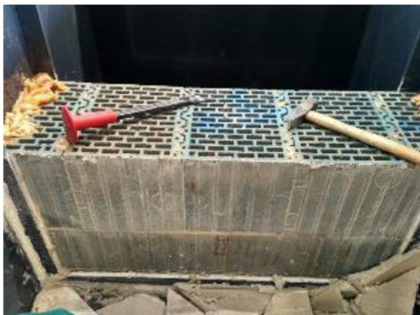
Obr. 58 Lícová strana konstrukce z mokré strany po vypuštění nádrže a odsekání strany po vypuštění nádrže a odsekání povrchové úpravy
