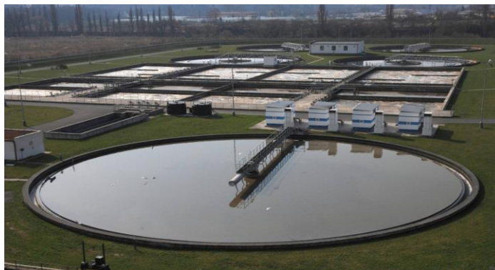
Obr. 5 - Čistírna odpadních vod Plzeň 31
