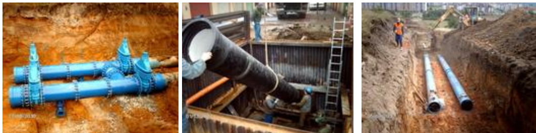
Obr. 6 - Kontrolní dny stavby 39
