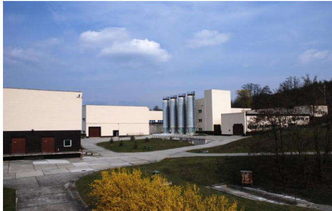
Obr. 4 - Úpravna vody Plzeň 30
