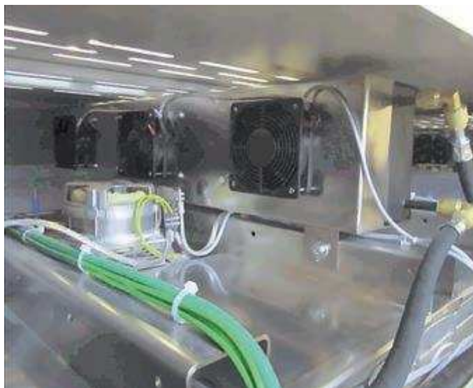
Obrázek 5: Přídavné chlazení krytů pece [4]
