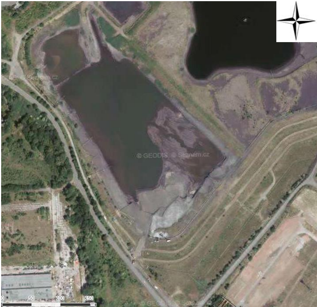
Obr. č. 4: Odkaliště Ušák s výsypkou na jeho jihovýchodním okraji.
