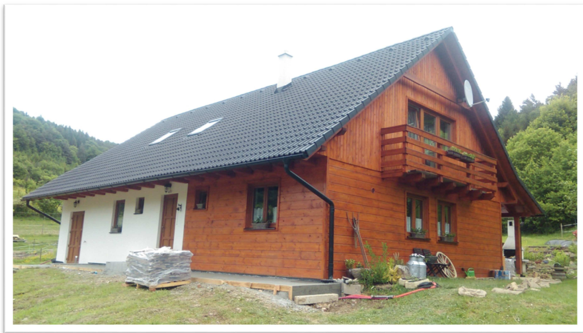
Obr. 1 Rámová konstrukce stávající dřevostavby
