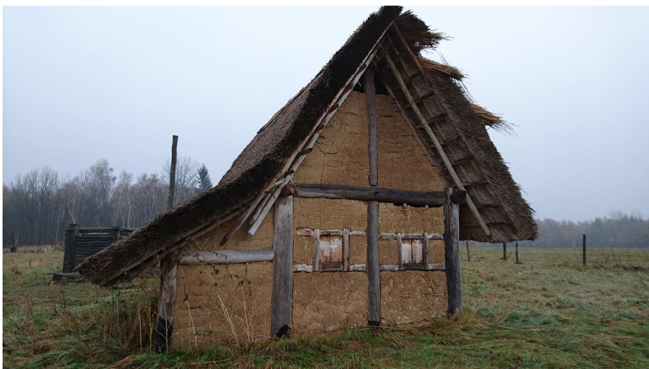
Obrázek 13 - Jedna z budov archeoskanzenu. Lze zde vidět druhy materiálů a jak byl objekt stavěn. Stěny jsou tvořeny slámou a půdou, střechy jsou pak slaměný. Základy tvoří dubové dřevo, které je na místech, které jsou v zemi, vypalováno. Objekty podléhají povětrnostním podmínkám a stěny tak praskají. (vlastní)
