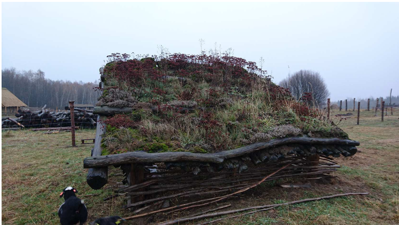
Obrázek 12 – Tato stavba slouží jako úkryt pro ovce, Na střechu byla navezena půda a vznikla tak přírodní střešní zahrada. Lze spatřit i oplocení výběhu, které je provizorně drátěné na dřevěných kůlech. (vlastní)
