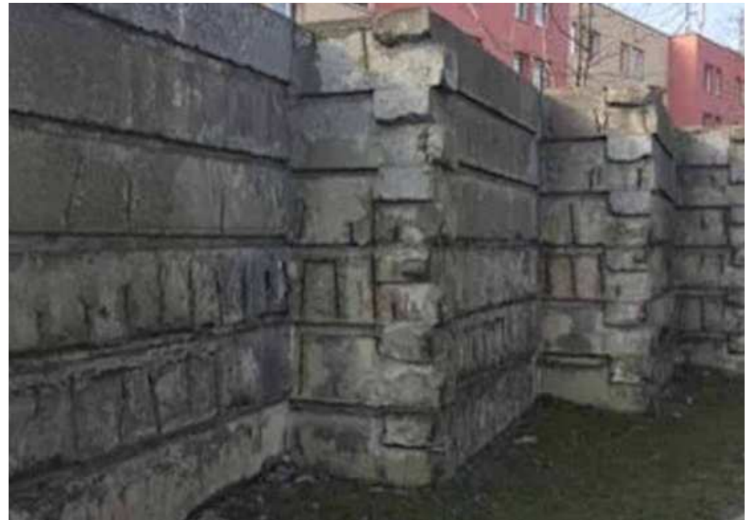
Obr. 32 Původní protihluková stěna ( https://karlovarsky.denik.cz/zpravy_region/kv-protihlukove-steny )
