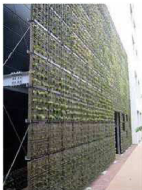
Obr. 13 Osázená stěna zajišťující regulaci hluku ( http://greenplantsforgreenbuildings.org/about.htm )
