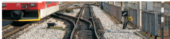
Obrázek 3.2: Výhybka s elektromotorickým prestavníkom
