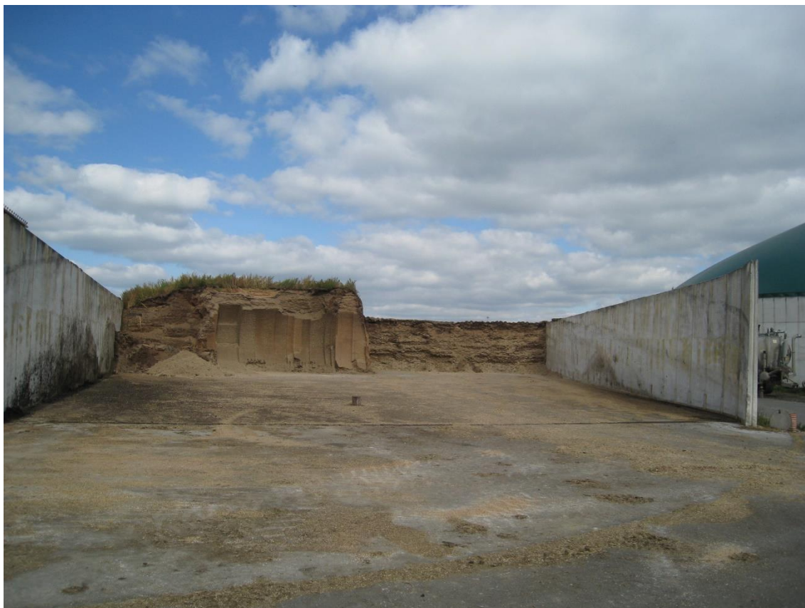
Příloha 16 – Silážní žlab (vystavěn spolu s bioplynovou stanicí) (zdroj – autor)
