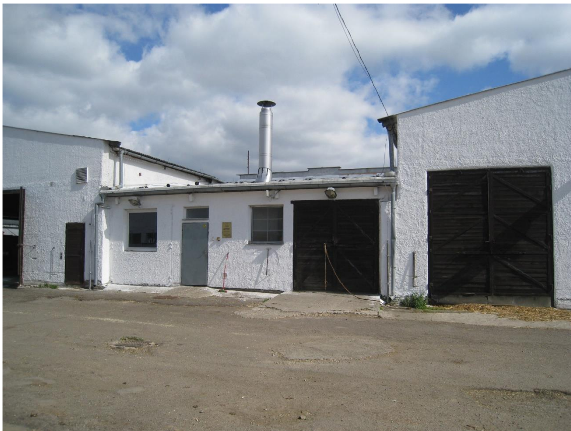
Příloha 11 – Stáje – vstup k předvadišti (původně vstup do dojírny) (zdroj – autor)
