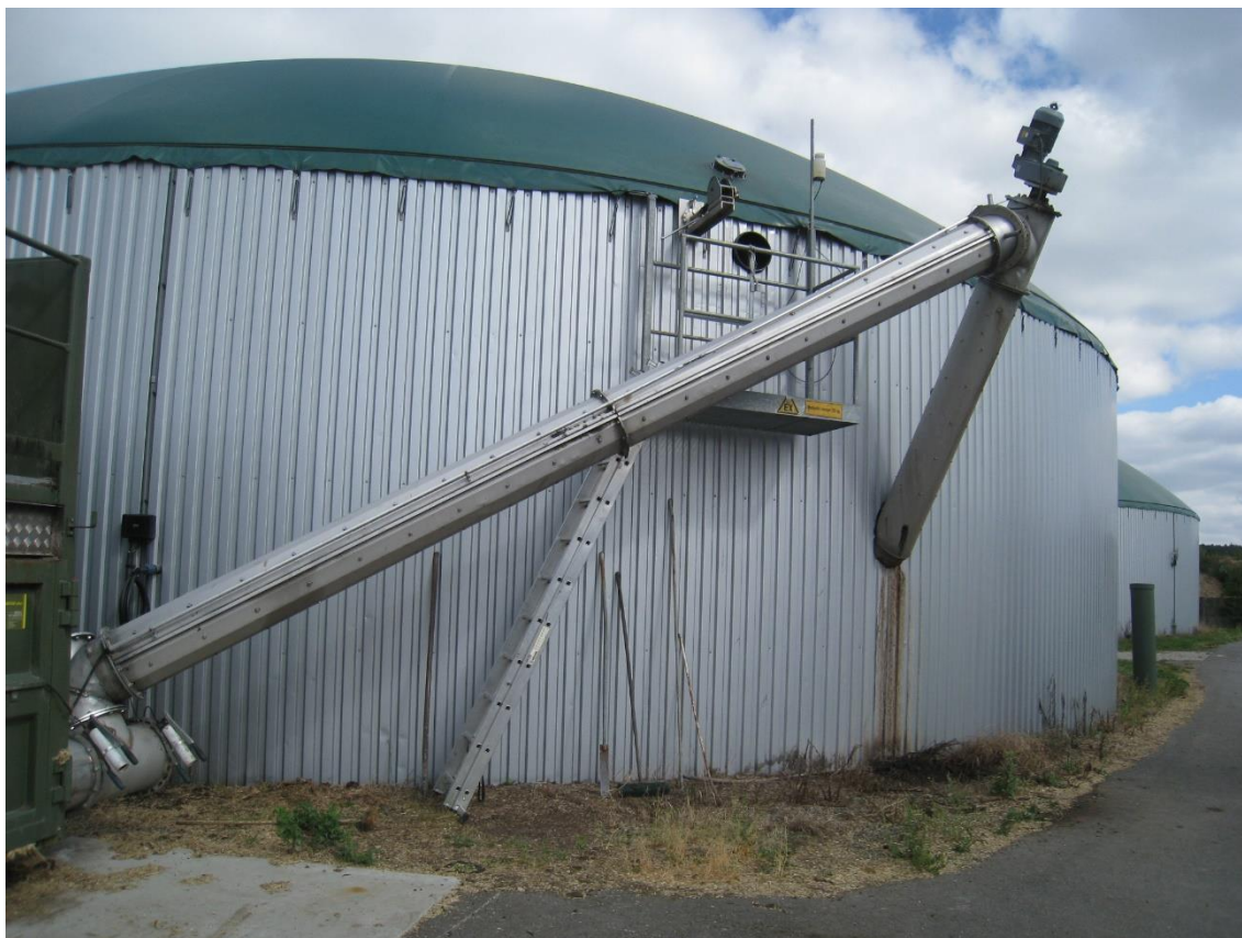
Příloha 20 – Bioplynová stanice – plnicí zařízení (zdroj – autor)
