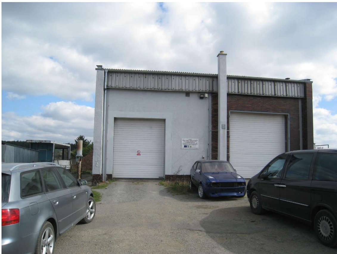
Příloha 18 – Umývárna a pneuservis (zdroj – autor)
