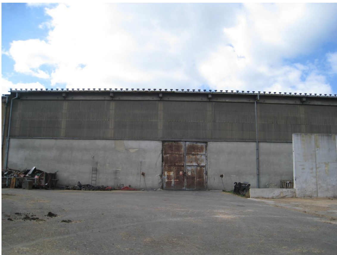
Příloha 7 – Skladovací hala (zdroj – autor)
