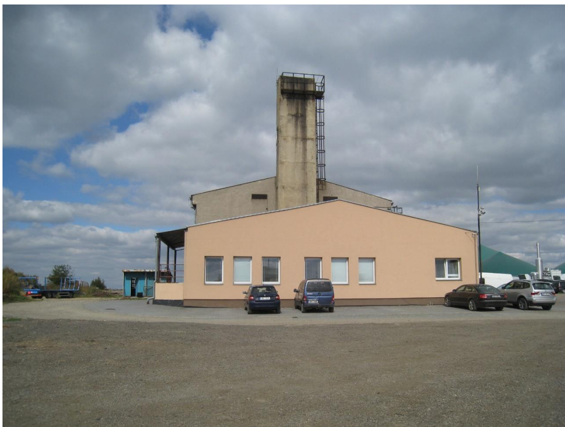
Příloha 23 – Administrativní budova (zdroj – autor)
