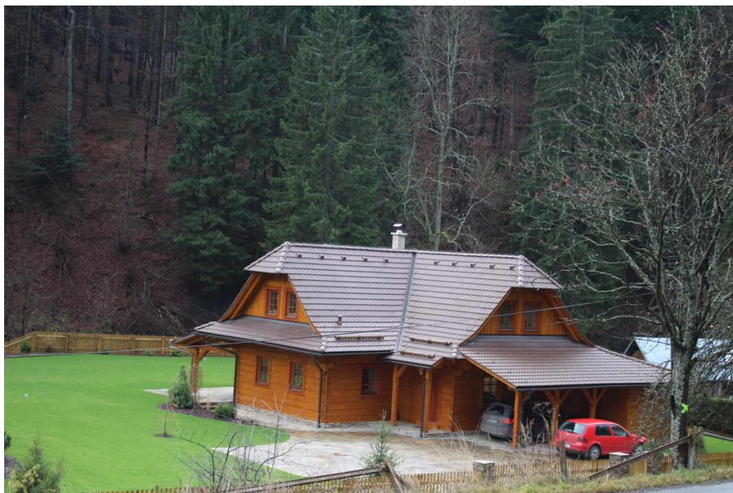
Obr. 13: Roubenka ve Velkých Karlovicích – nová zástavba (Vlastní fotografie)
