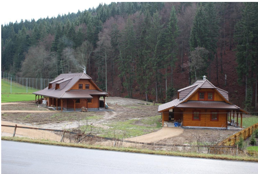
Obr. 14: Roubenky Velké Karlovice – nová zástavba (Vlastní fotografie)
