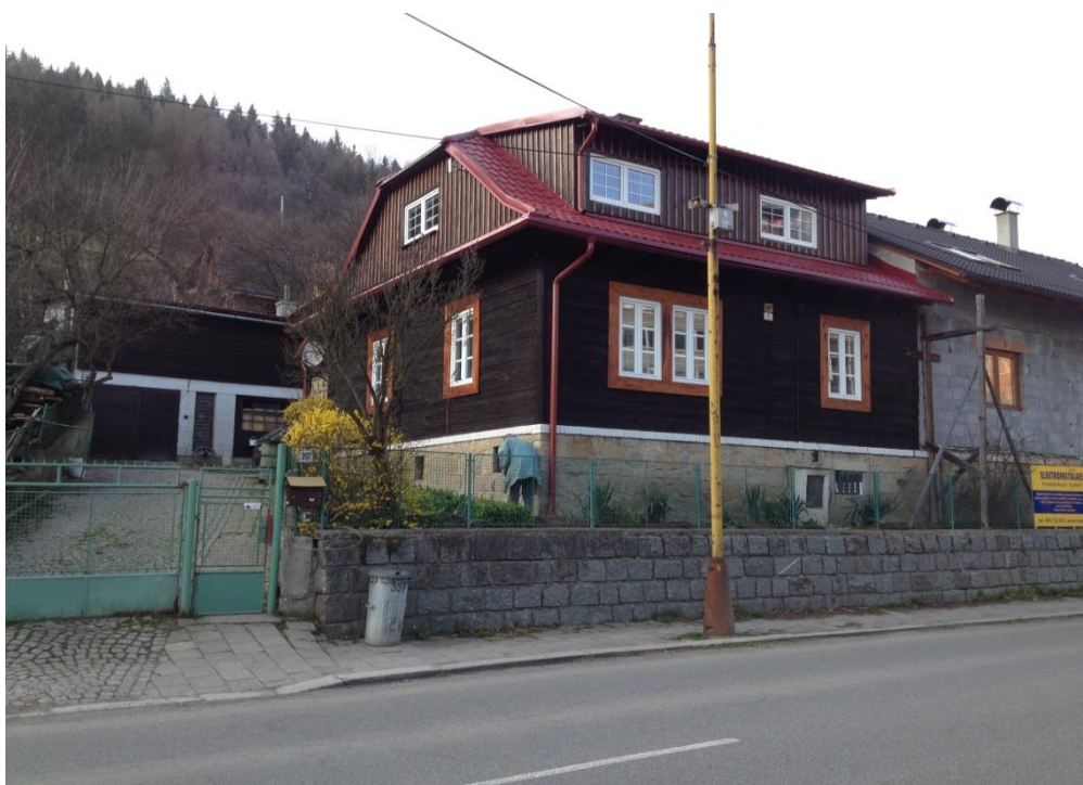
Obr. 9: Roubenka na Jasence – výstavba v 70. letech 20. století (Vlastní fotografie)
