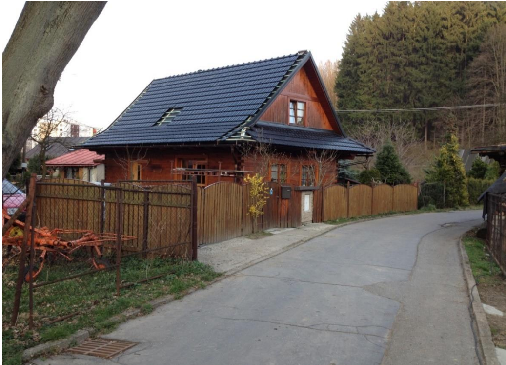
Obr. 12: Roubenka v Rokytnici – nová zástavba (Vlastní fotografie)
