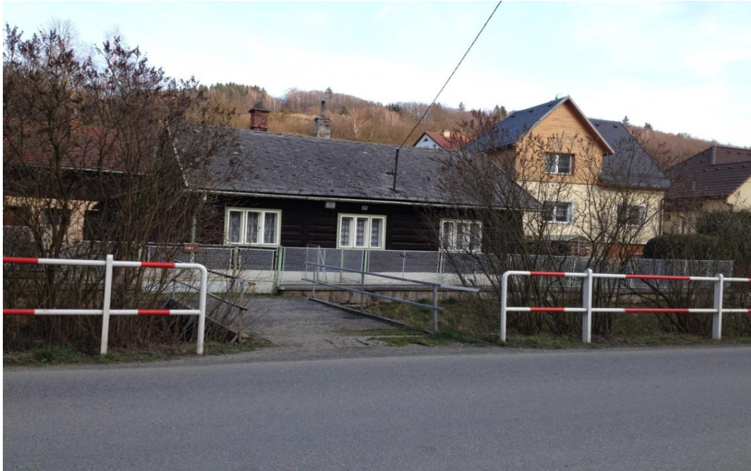
Obr. 6: Roubenka na Jasence – výstavba v 50. letech 20. století (Vlastní fotografie)
