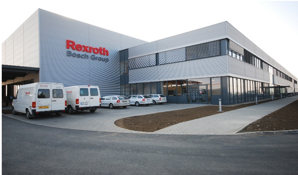
Obr. 3) Sídllo Bosch Rexroth v Brně – Černovicích [10]
