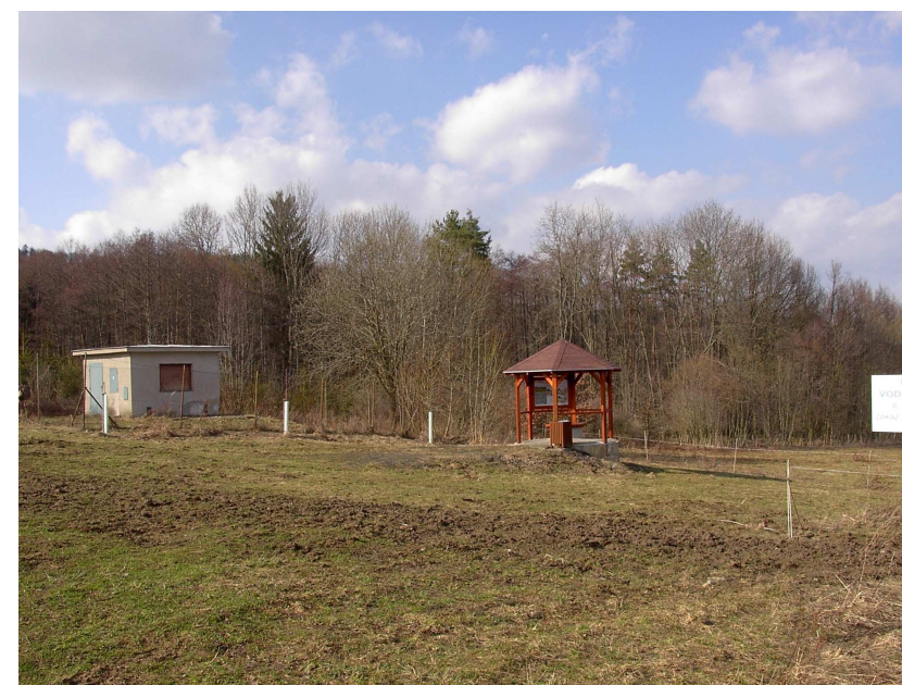
20. Po značené turistické stezce z Jankova do Votic je současně vedena i naučná stezka, která je zakončena vyhlídkovým altánem. V tomto místě je také zbudován zemní vodojem pro jankovský vodovod.
