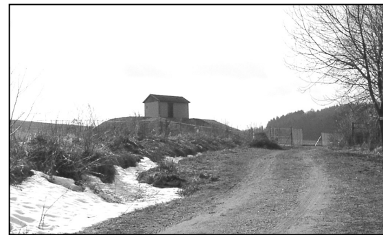
Obr. 13.: Nový zemní vodojem v Jankově, fungující od roku 2004 (foto vlastní, 2010)
