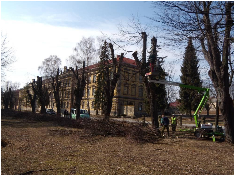
Obr. 42 Práce při prořezávání lip v aleji (J. Pavlíček, 7. 3. 2012)
