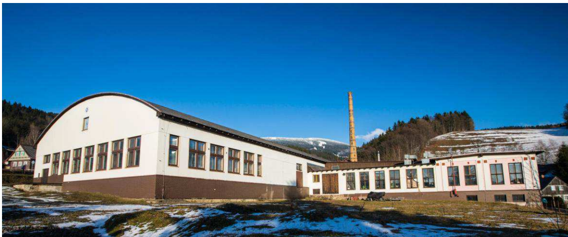
Obr. 17: RTK tkalcovna v Horní Rokytnici (Zdroj: RTK, spol. s r. o.)
